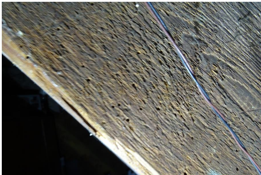
Fot. 26 Otwory wylotowe Kołatka domowego na kolejnej krokwi (strona dachu j.w.)
