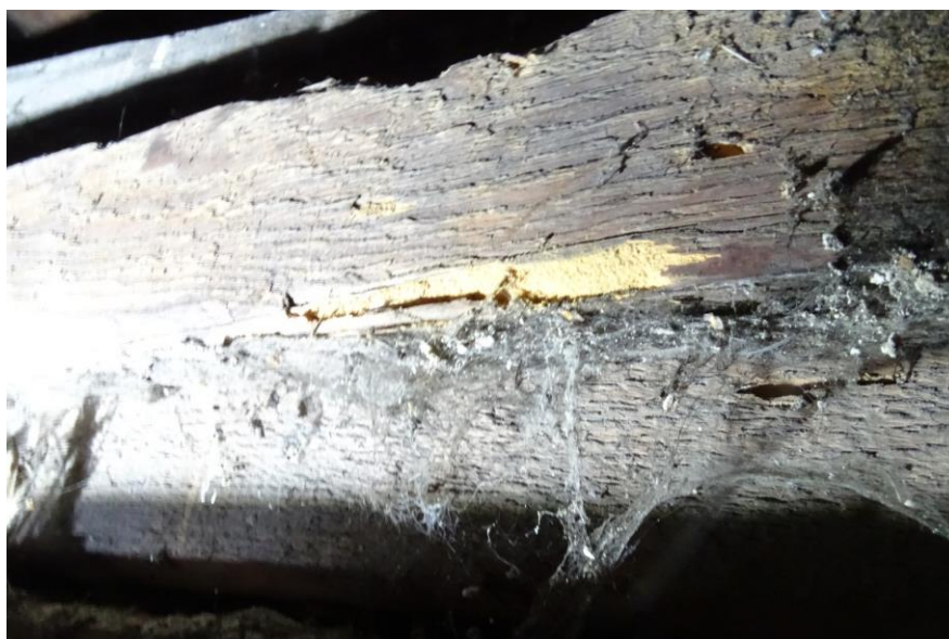
Fot. 43 Żerowisko Spuszczela pospolitego na elemencie drewnianym górnego poddasza
