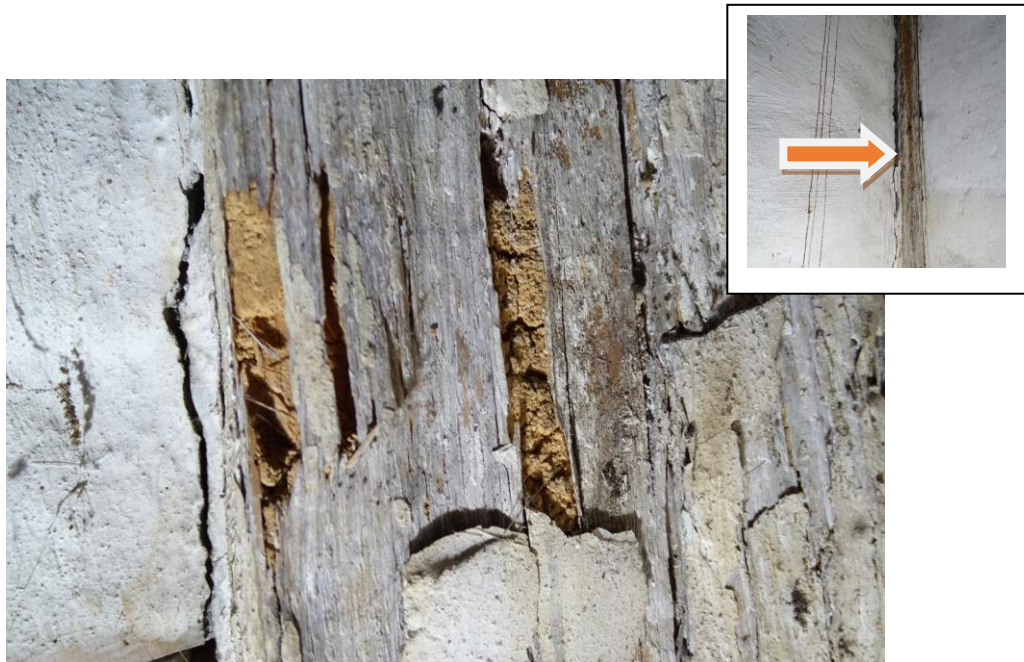
Fot. 10 Korytarze z czynnym żerowiskiem Spuszczela pospolitego na słupie
