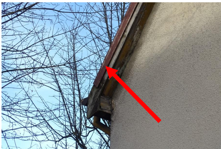
Fot. 64 Skorodowana, niepełna obróbka blacharska
