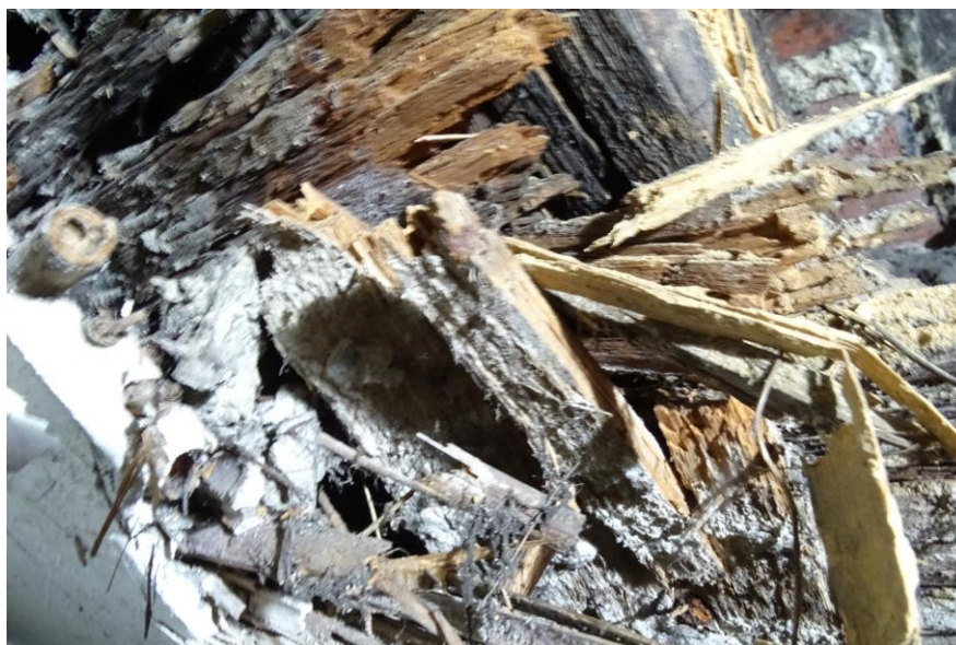
Fot. 18 Przegniłe elementy drewniane dachu j.w. rozsypują się
