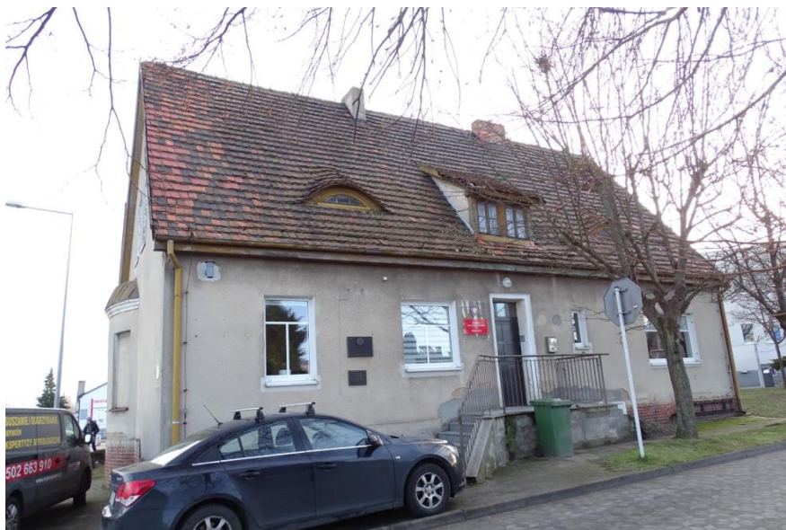
Fot. 55 Połąc dachowa budynku od strony zachodniej. Dachówki pokryte mchem, glonami, zagrzybione
