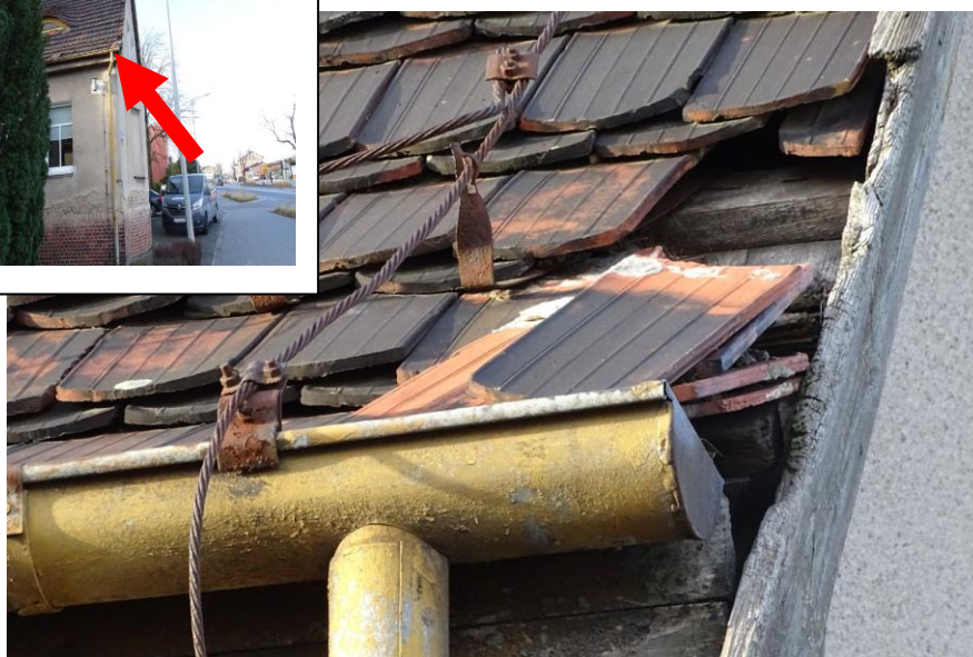
Fot. 72 Brak obróbek blacharskich, luźne dachówki w narożniku płn.-wsch.
