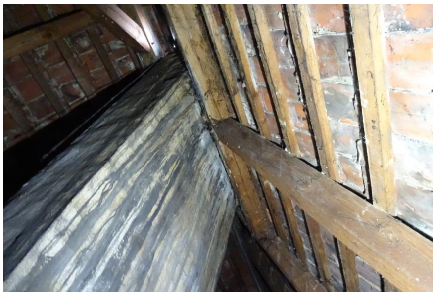
Fot. 37 Zacieki na kominie – górne poddasze
