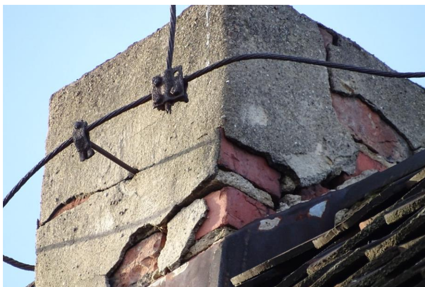
Fot. 76 Zły stan techniczny komina – sypiący się tynk i cegły
