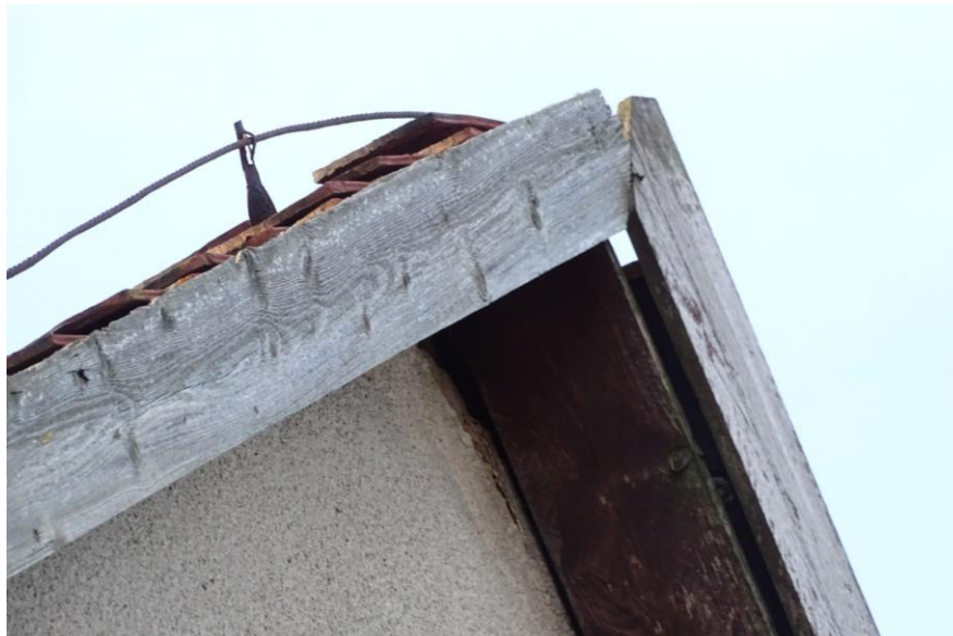
Fot. 75 Obróbka drewniana dachu na ścianie szczytowej – deski mogą odpaść
