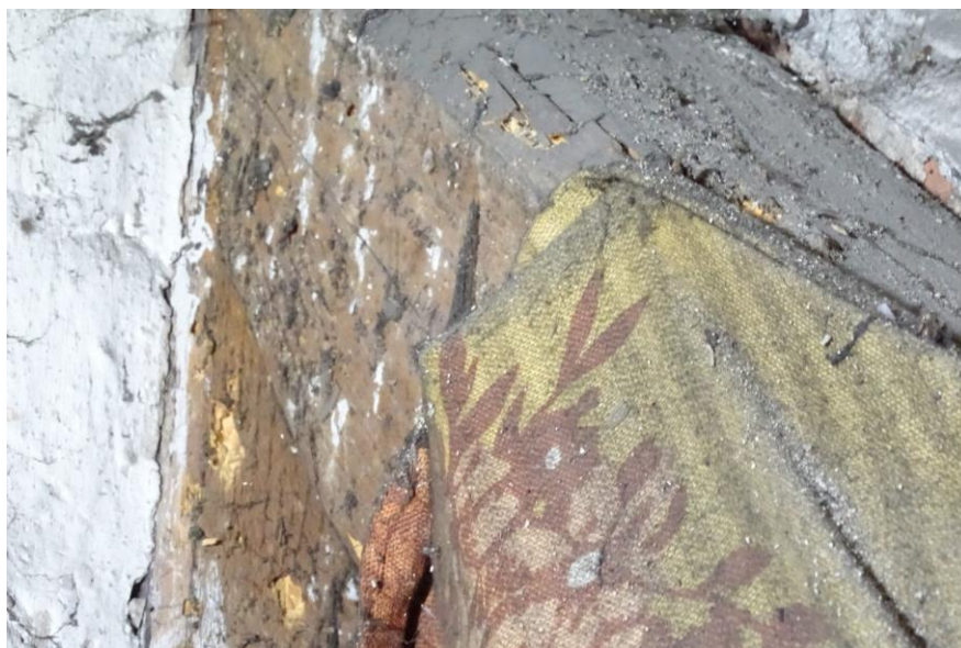
Fot. 30 Widoczne żerowisko drewnojadów na słupie (strona dachu zachodnia)
