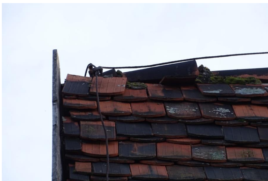
Fot. 56 Luźne gąsior i dachówki w kalenicy od strony płn. – spadające dachówki zagrażają przechodniom. Należy odgrodzić teren pod dachem i oznakować tablicami ostrzegawczymi o spadających dachówkach
