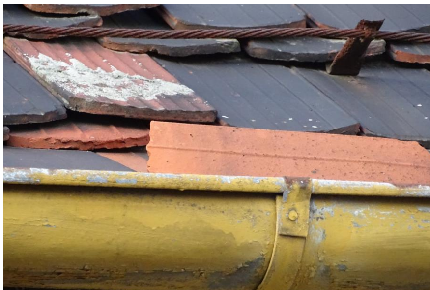
Fot. 70 Luźne dachówki stanowią zagrożenie dla przechodniów
