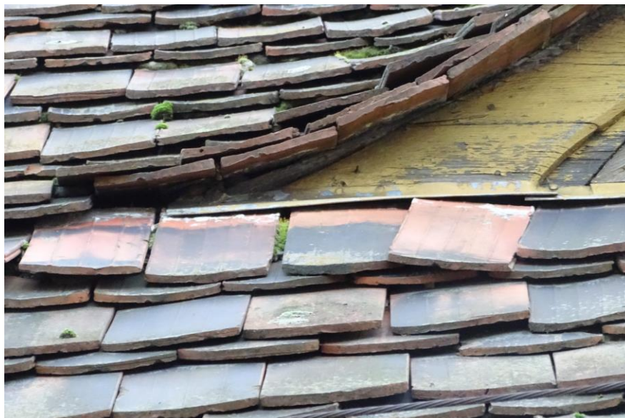
Fot. 61 Kolejne luźne dachówki j.w.
