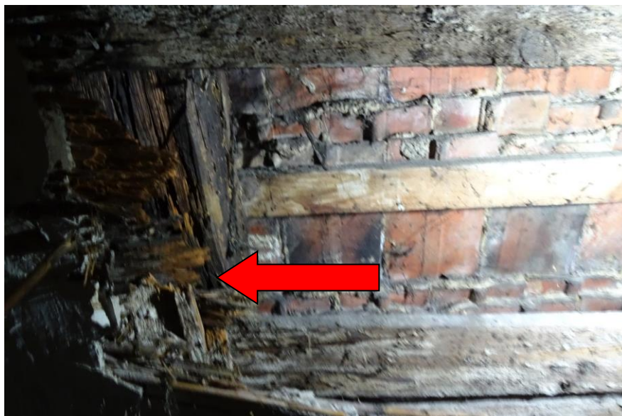
Fot. 15 Zgnilizna brunatna drewna na dachu od strony wschodniej
