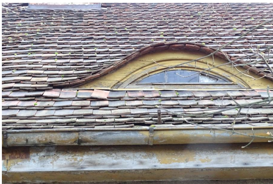
Fot. 60 Skorodowane obróbki blacharskie i rynna (str.zach.)
