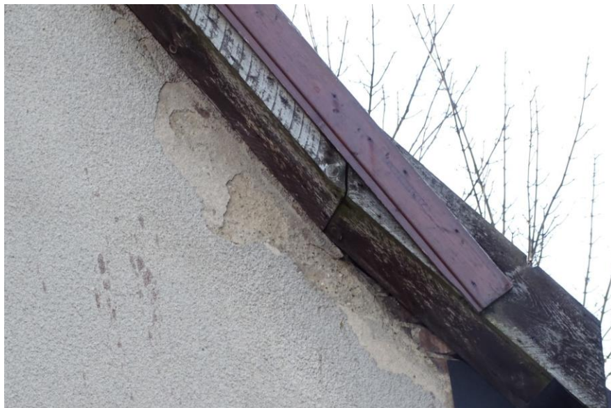
Fot. 77 Brak prawidłowych obróbek połaci dachowej powoduje zalewanie ściany szczytowej od strony ulicy
