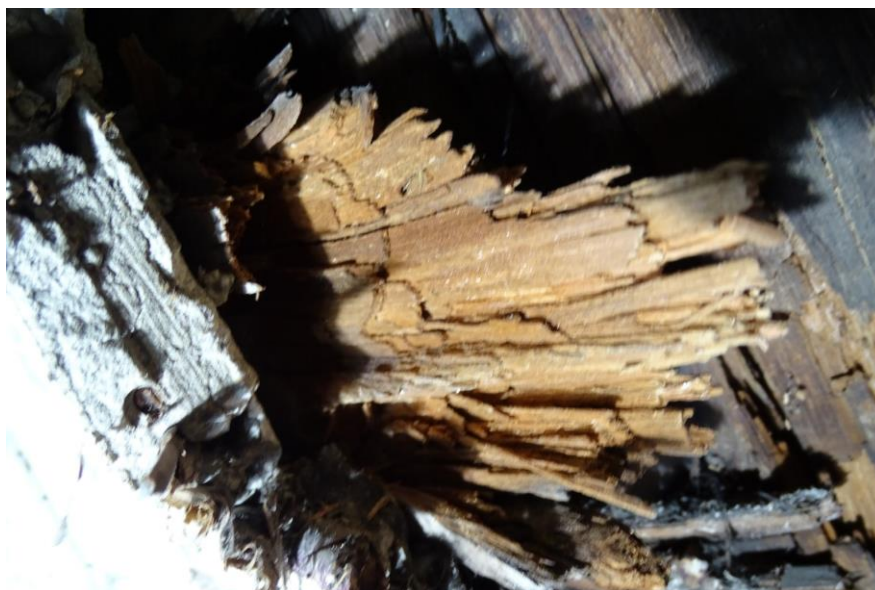
Fot. 4 Przegnięte elementy drewniane dachu i podsufitki rozsypują się (pom. j.w.)
