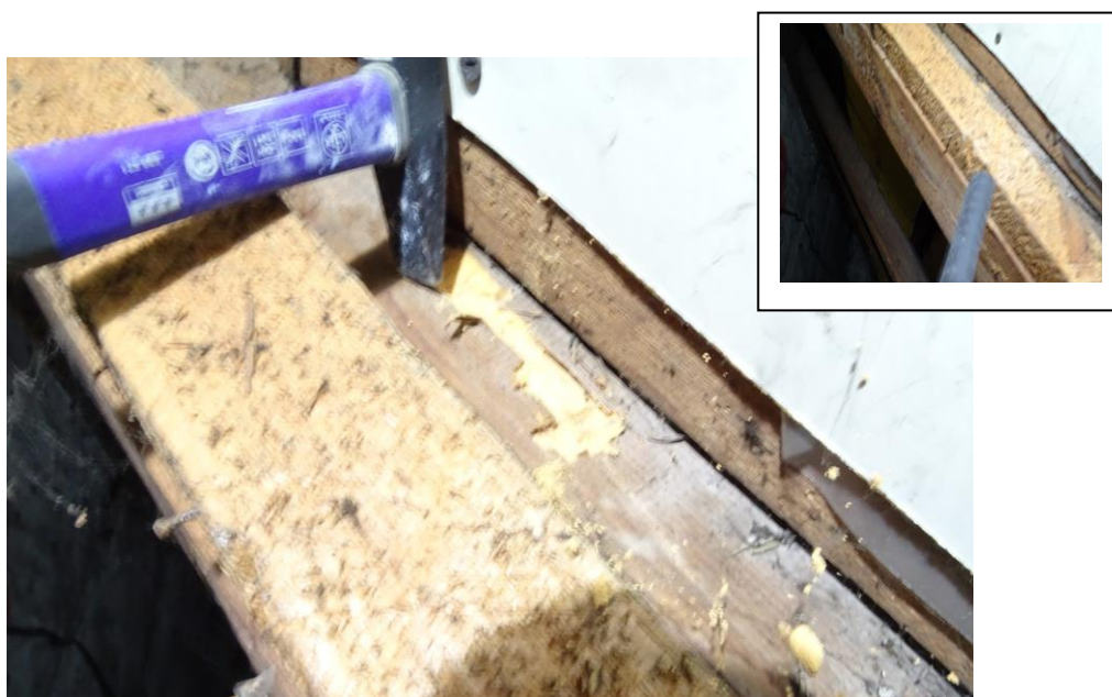
Fot. 35 Ostukiwanie kolejnej krokwi na stronie zachodniej dachu wskazuje na znaczne zniszczenia dokonane przez drewnojady
