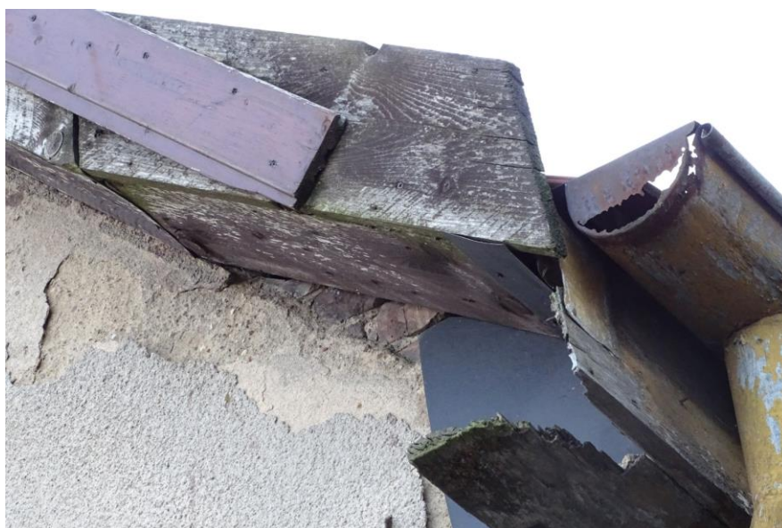
Fot. 78 j.w., przegniłe obróbki drewniane, dziurawa, skorodowana rynna
