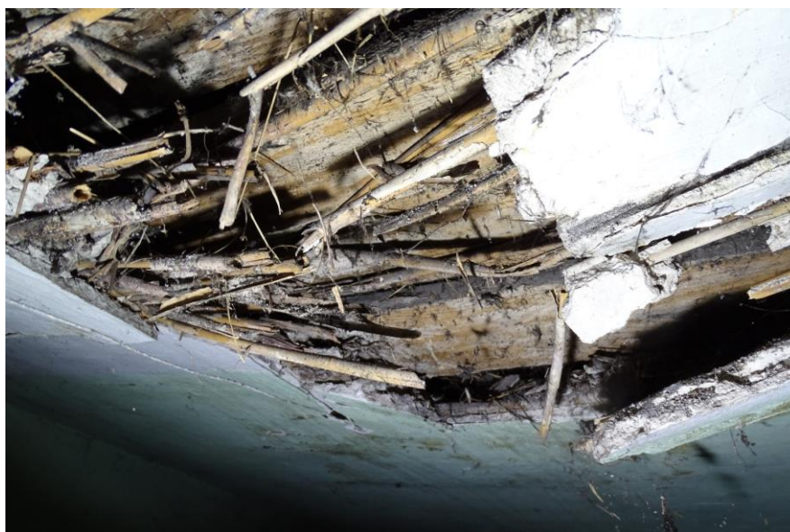
Fot. 9 Przegniłe deskowanie poddasza
