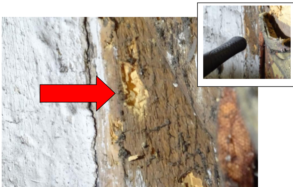
Fot. 33 Żerowisko ksylofagów na kolejnym elemencie konstrukcyjnym
