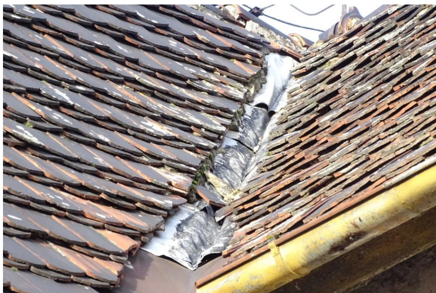
Fot. 66 Nieszczelne, niepełne obróbki blacharskie w koszu j.w.
