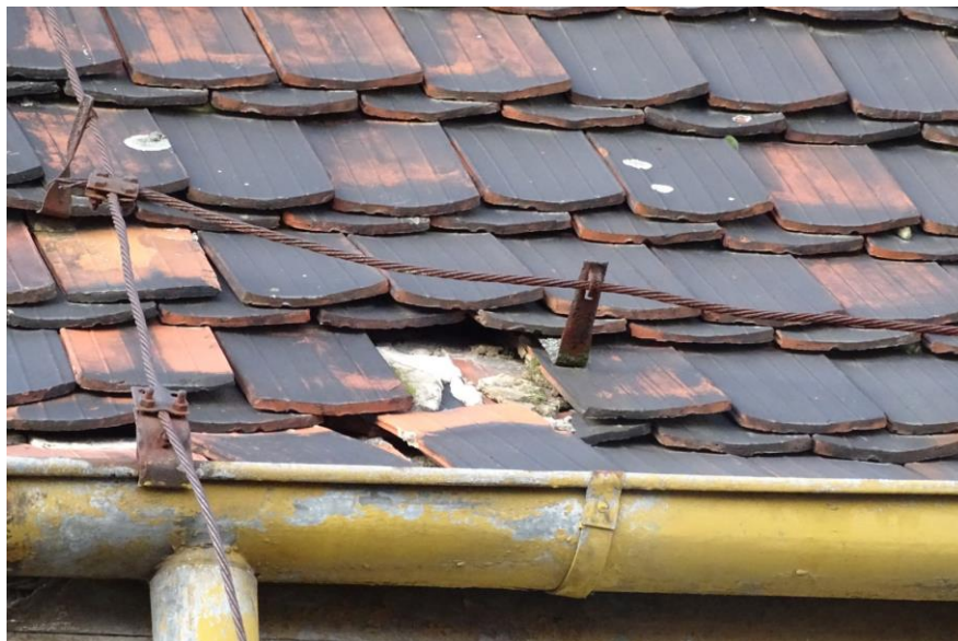
Fot. 69 Brak dachówki w części dachu j.w.
