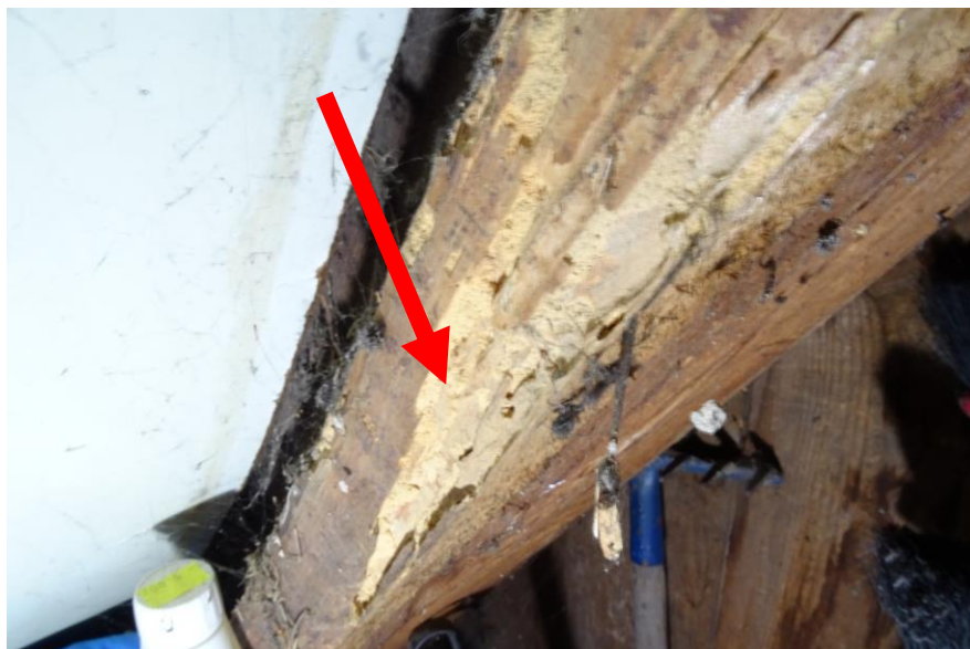
Fot. 21 Czynne żerowisko na krokwi, widoczna mączka drzewna z odchodami ksylofagów (strona dachu zachodnia)
