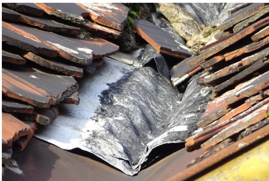
Fot. 68 j.w., widoczne sypiące się luźne dachówki – teren należy odgrodzić tak samo jak od strony zachodniej
