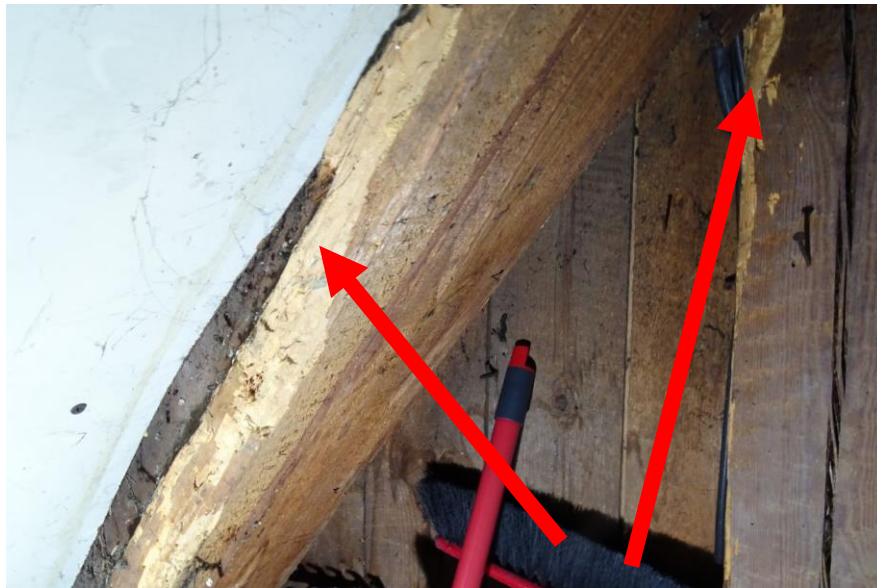
Fot. 20 Żerowiska Spuszczela pospolitego na elementach konstrukcyjnych dachu (strona zachodnia)
