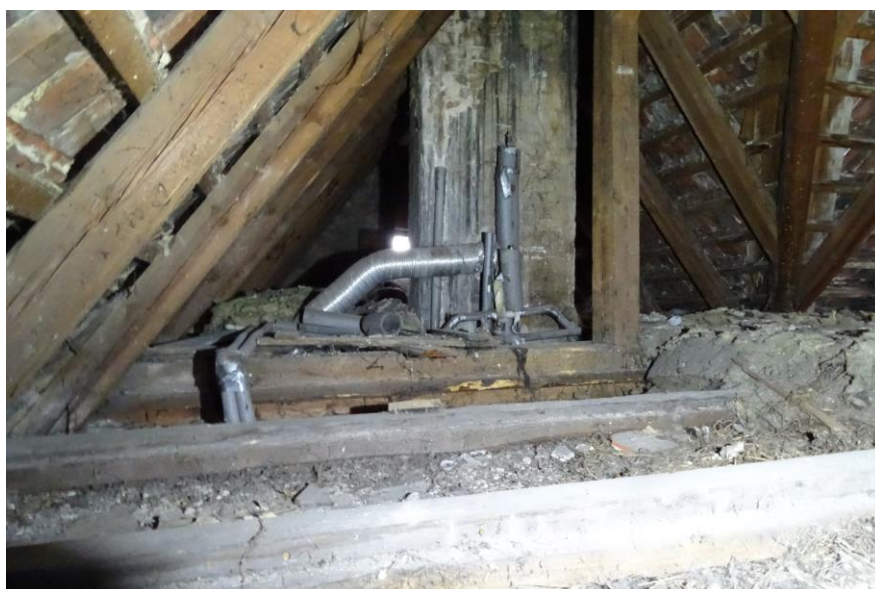
Fot. 41 Brak podłogi na górnym poddaszu
