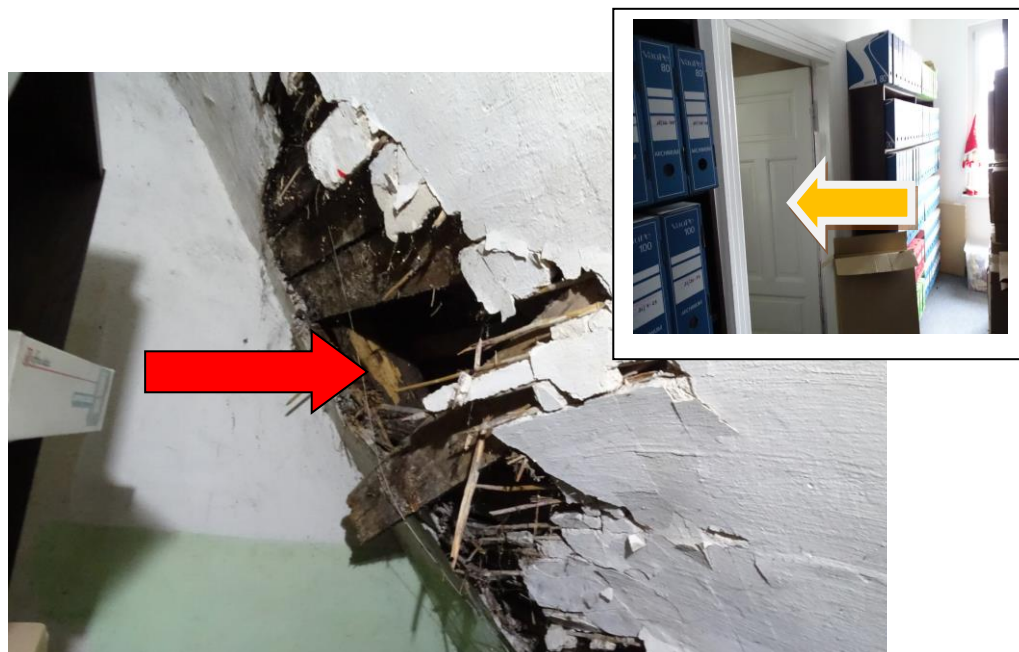
Fot. 1 Przegniłe elementy dachu i deskowanej podsufitki w pomieszczeniu od strony wschodniej (poddasze użytkowe)
