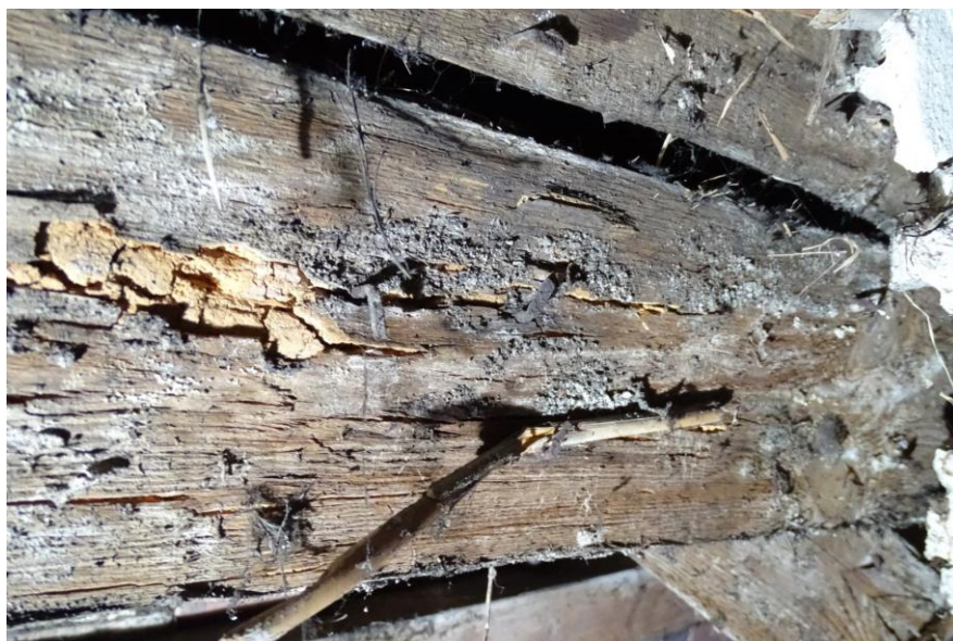
Fot. 6 Kolejny całkowicie zniszczony element konstrukcyjny dachu (strona j.w.) – czynne żerowisko Spuszcza pospolitego oraz zgnilizna brunatna drewna
