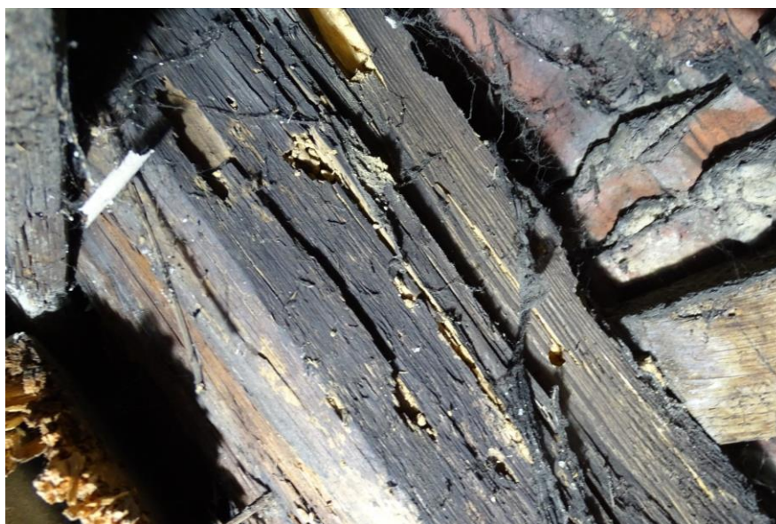
Fot. 3 Całkowicie zniszczona krokiew (spuszczał pospolity) – pomieszczenie j.w.
