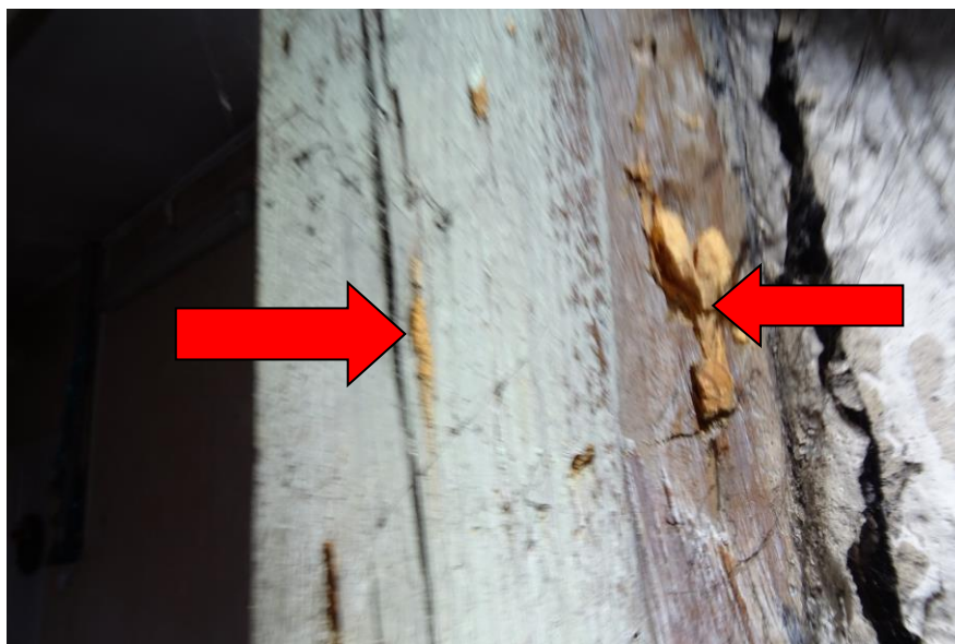
Fot. 24 Żerowisko Spuszczela pospolitego w słupie (strona j.w.)
