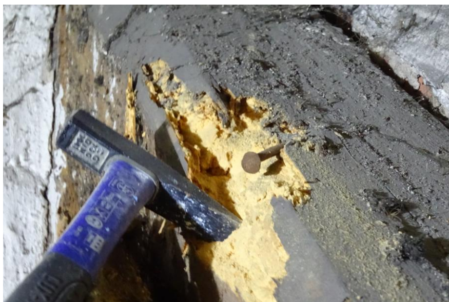
Fot. 31 Ostukiwanie wskazuje na głębokie zniszczenia dokonane przez ksylofagi j.w.
