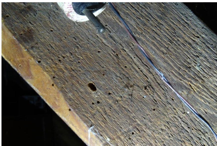
Fot. 27 Otwory wylotowe mniejsze Kołatka domowego i większy Spuszczela pospolitego
