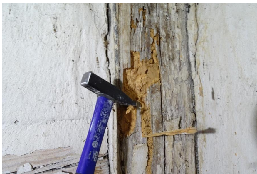
Fot. 13 Ostukiwanie młotkiem słupa wskazuje na głębokie zniszczenia dokonane przez ksylofagi
