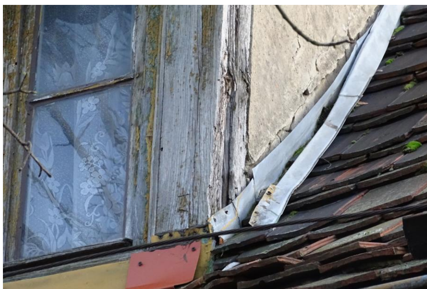
Fot. 58 „Rozjeżdżające” się obróbki blacharskie przy lukarnie j.w.
