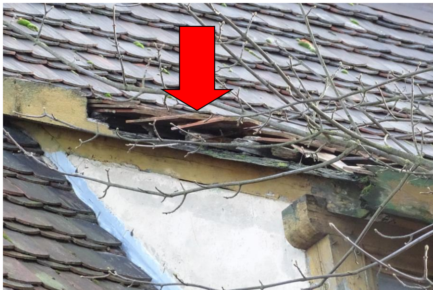
Fot. 57 Brak obróbki blacharskiej i luźne dachówki nad lukarną od strony zachodniej
