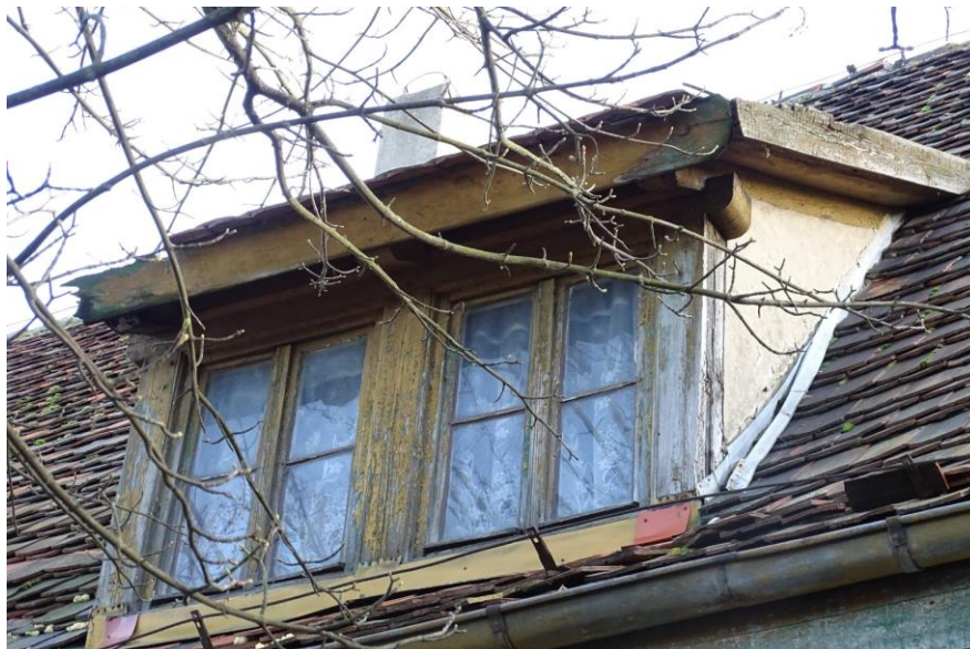
Fot. 59 Lukarna j.w. wokół niej widoczne luźne dachówki
