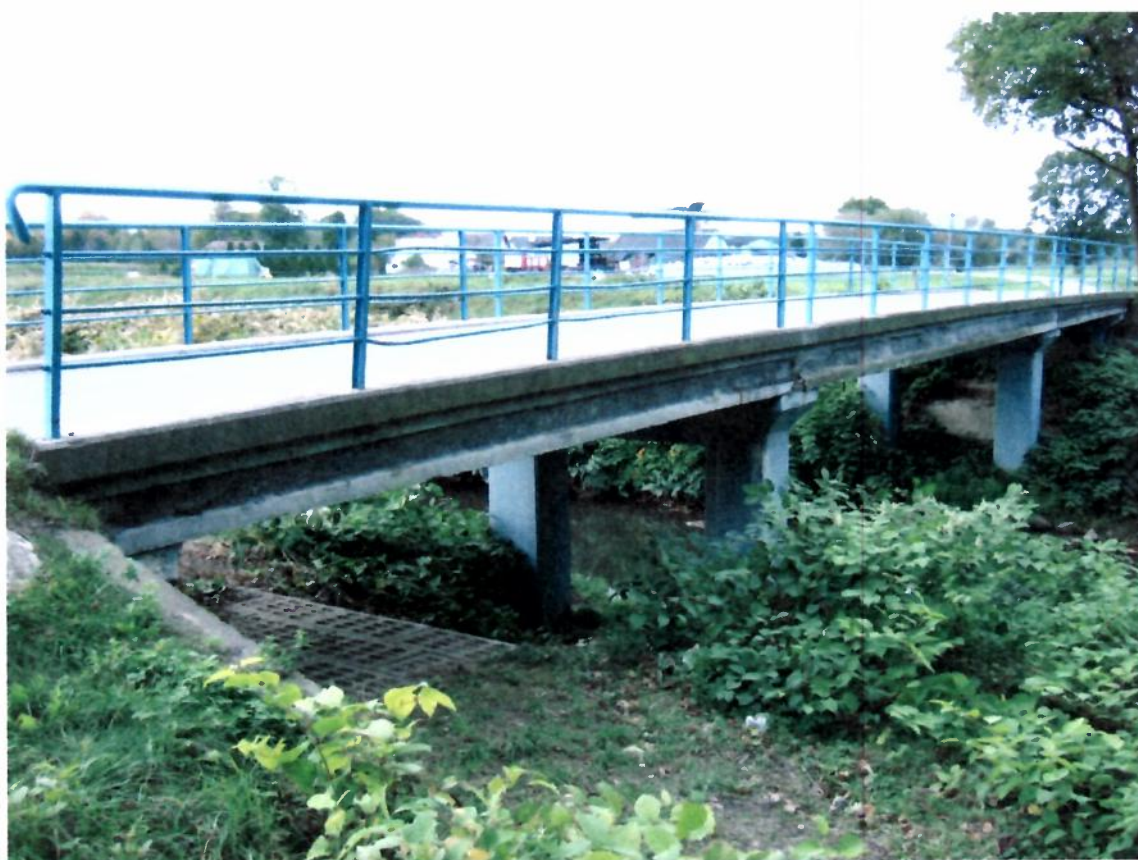
Fot. 4 Widok na obiekt od strony dolnej wody
