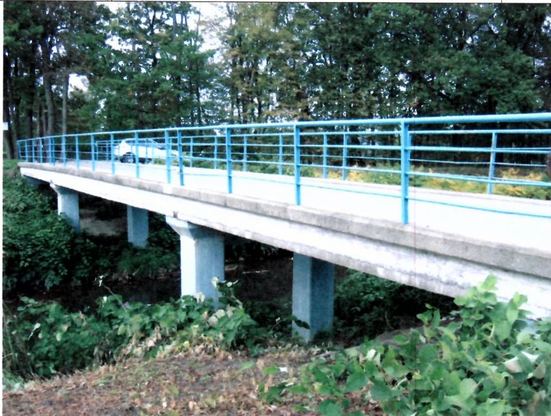
Fot. 3 Widok na obiekt od strony górnej wody
