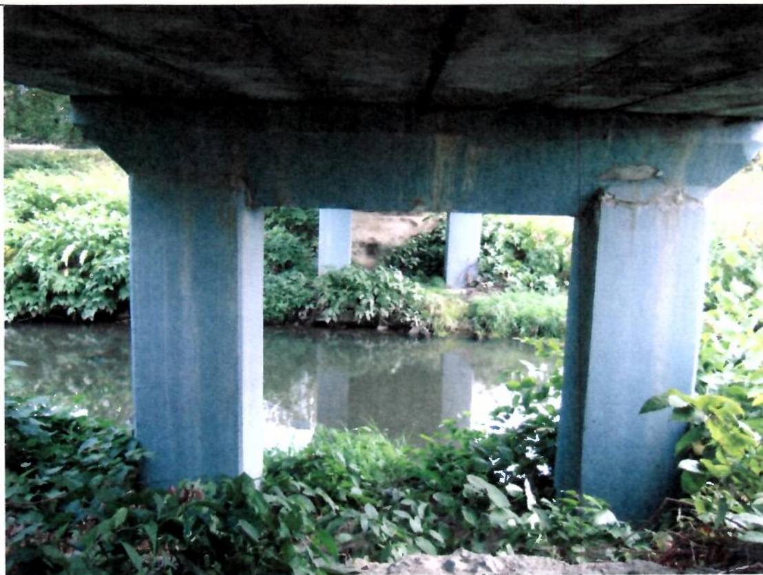
Fot. 8 Widok na przestrzeń pod obiektem.
