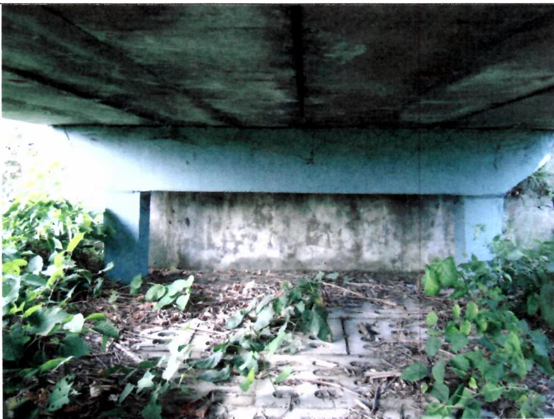
Fot. 6 Widok na przyczółek lewobrzeżny.
