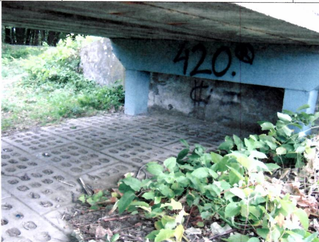
Fot. 5 Widok na przyczółek prawobrzeżny.
