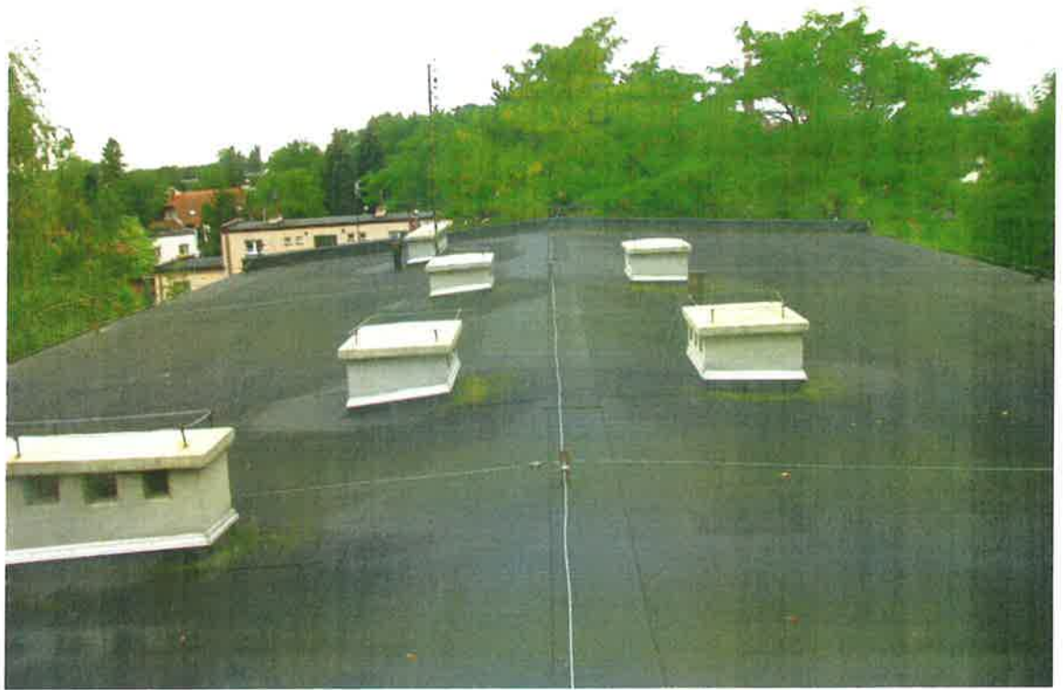
Fot. 3. Widok dachu
