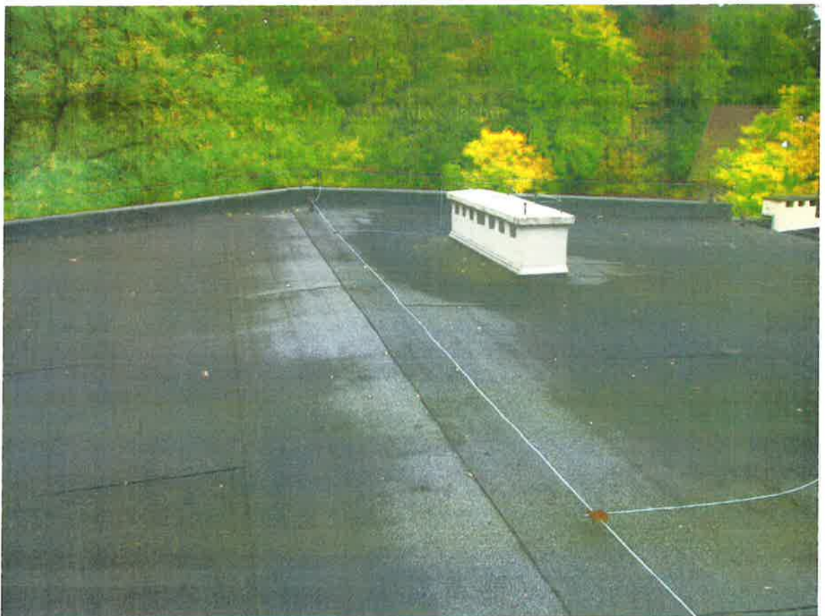
Fot. 4. Widok dachu
