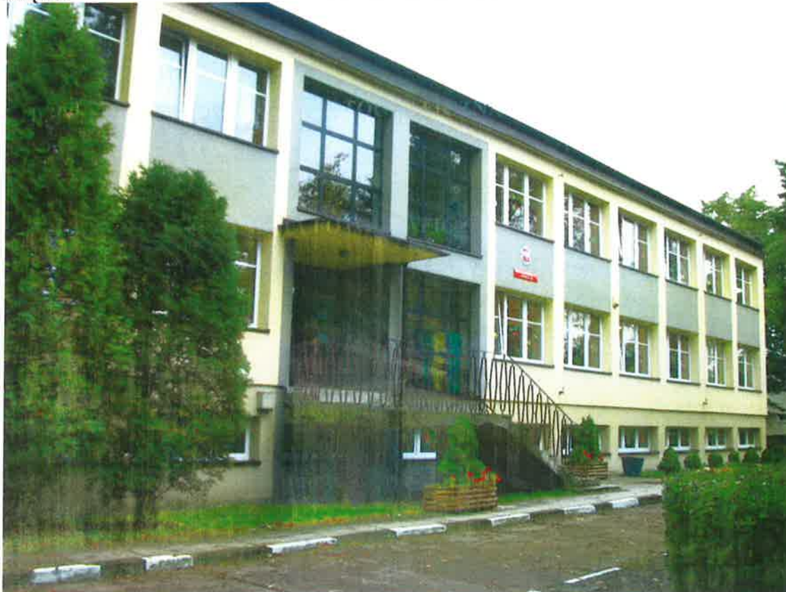
Fot. 1. Widok budynku od frontu
