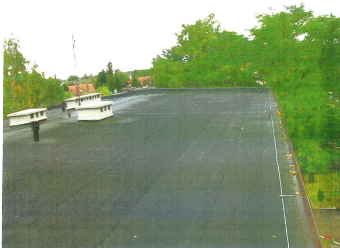
Fot. 5. Widok dachu
