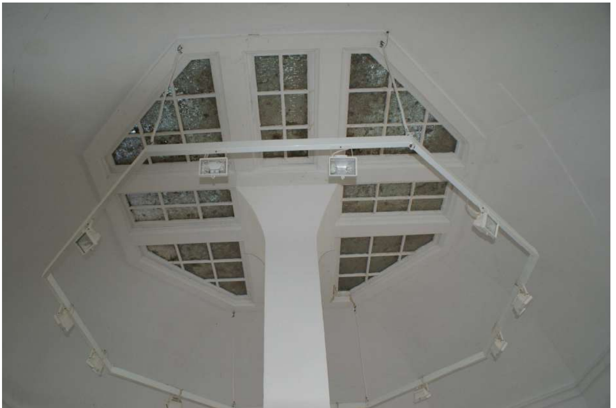
Fot.1. Naświetle - doświetlenie pomieszczenia.
