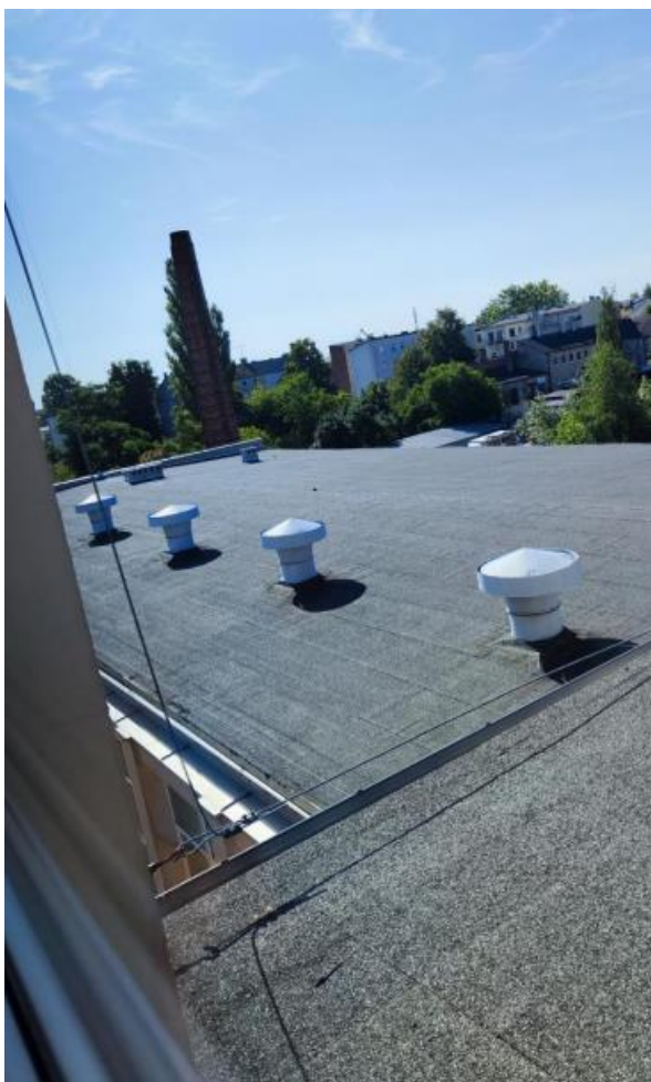
Widok stropodachu nad salą gimnastyczną.
