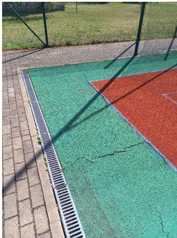
Ryc. 4 Widok na boisko – odwodnienie liniowe Źródło: archiwum własne z dn. 28.07.2022 r.
