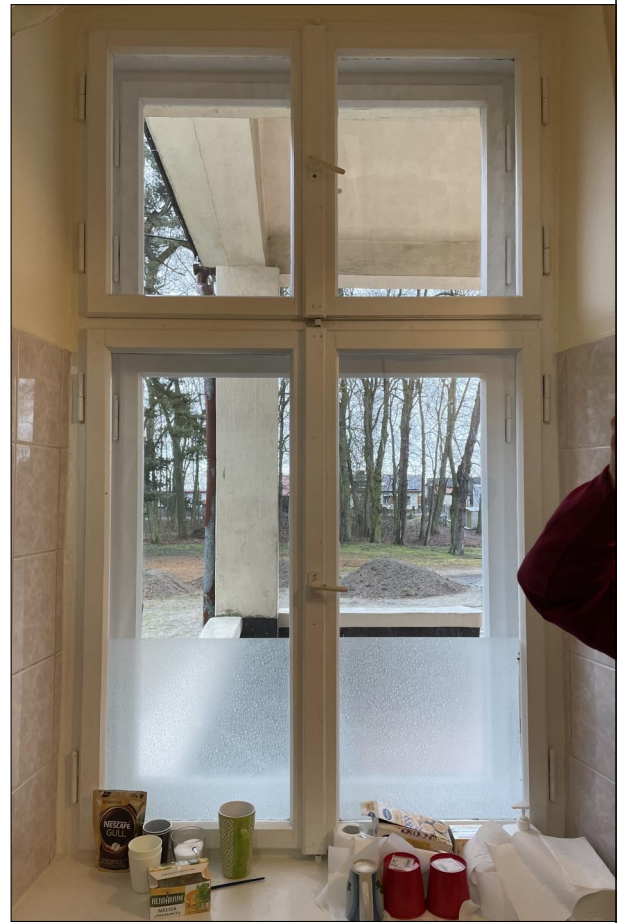
OKNO SKRZYNKOWE ZLOKALIZOWANE NA PARTERZE
