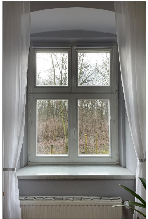
OKNO RAMIAKOWE ZLOKALIZOWANE NA PIĘTRZE
