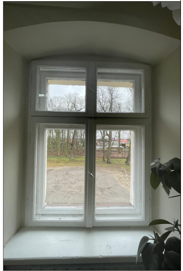
OKNO SKRZYNKOWE ZLOKALIZOWANE NA PIĘTRZE
