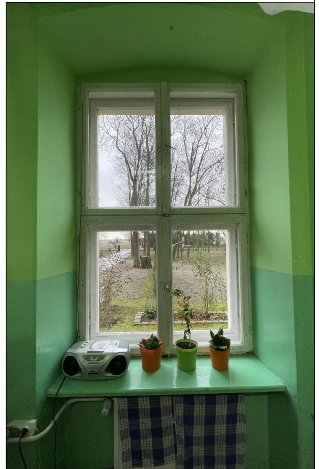
OKNO SKRZYNKOWE ZLOKALIZOWANE NA PARTERZE
