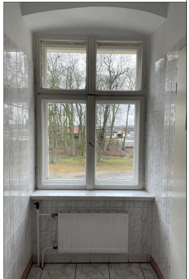
OKNO SKRZYNKOWE ZLOKALIZOWANE NA PIĘTRZE
