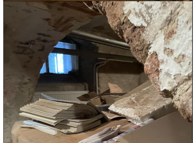
OKNO ZLOKALIZOWANE W PIWNICY
