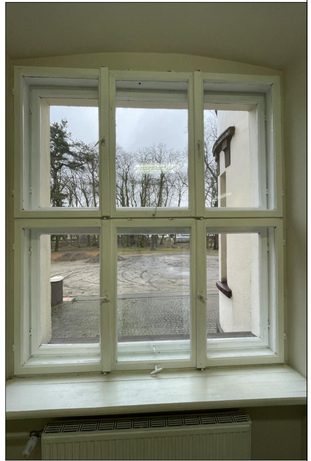
OKNO SKRZYNKOWE ZLOKALIZOWANE NA PARTERZE
