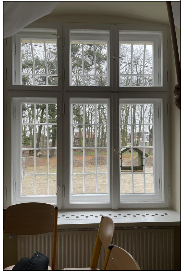
OKNO SKRZYNKOWE ZLOKALIZOWANE NA PARTERZE
