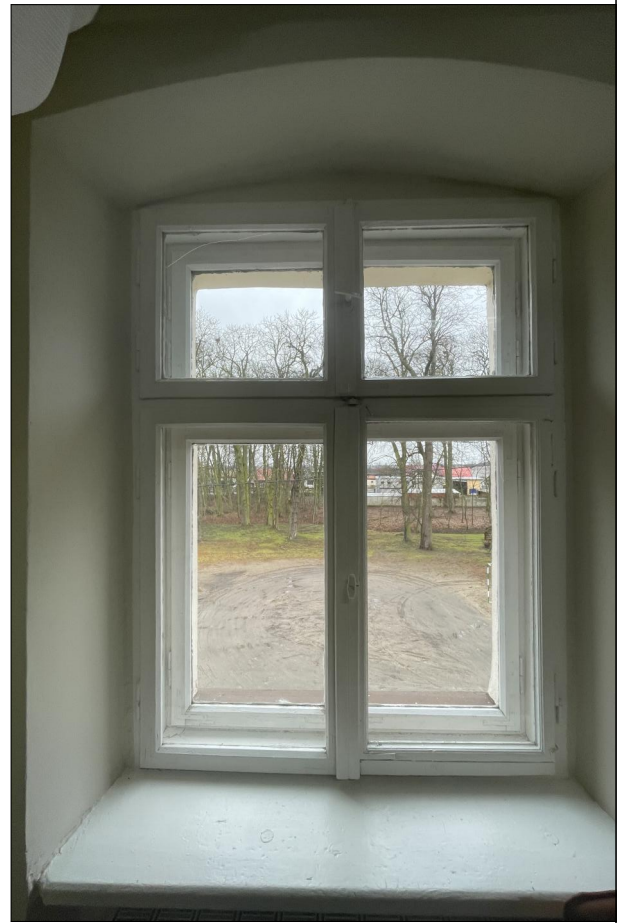
OKNO SKRZYNKOWE ZLOKALIZOWANE NA PIĘTRZE
