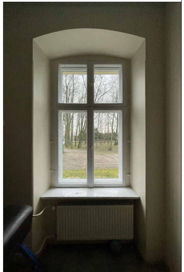
OKNO SKRZYNKOWE ZLOKALIZOWANE NA PARTERZE
