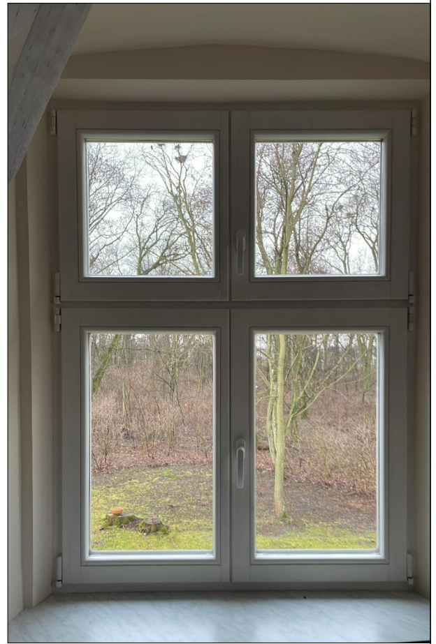
OKNO RAMIAKOWE ZLOKALIZOWANE NA PIĘTRZE
