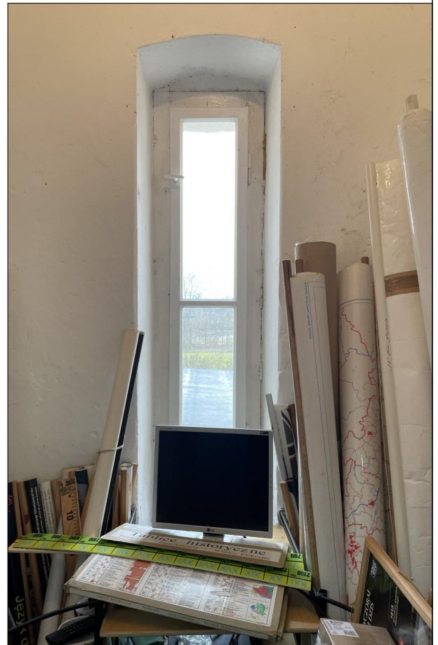
OKNO SKRZYNKOWE ZLOKALIZOWANE NA PIĘTRZE
