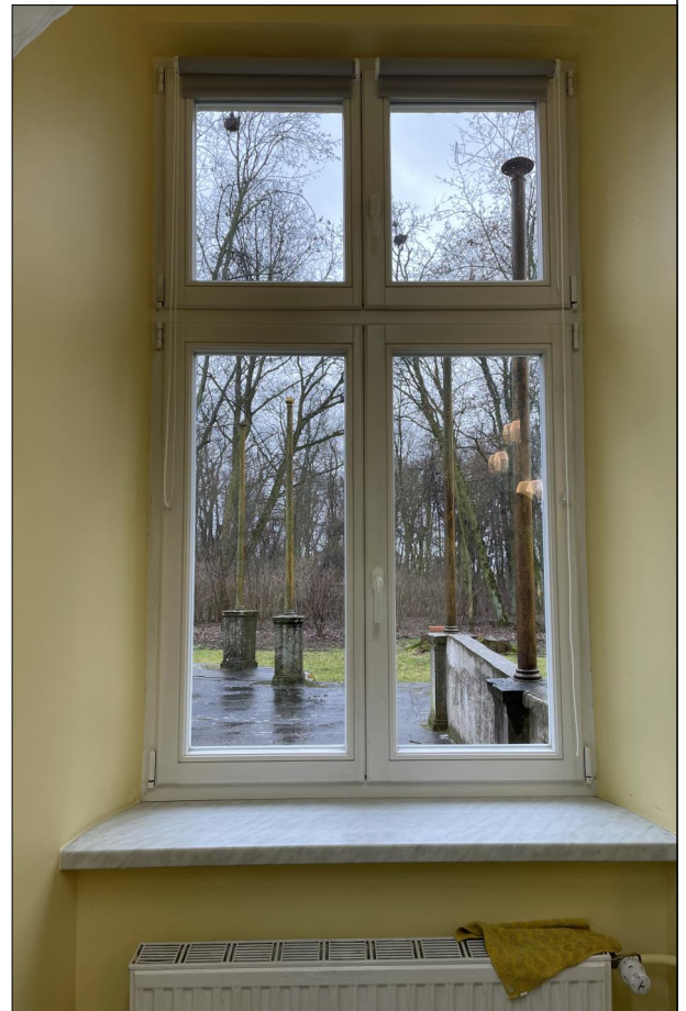
OKNO RAMIAKOWE ZLOKALIZOWANE NA PARTERZE
