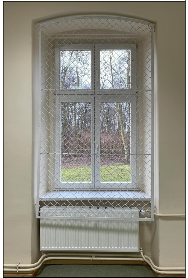
OKNO RAMIAKOWE ZLOKALIZOWANE NA PARTERZE
