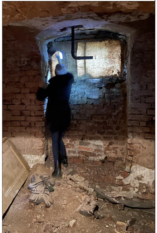
OKNO ZLOKALIZOWANE W PIWNICY
