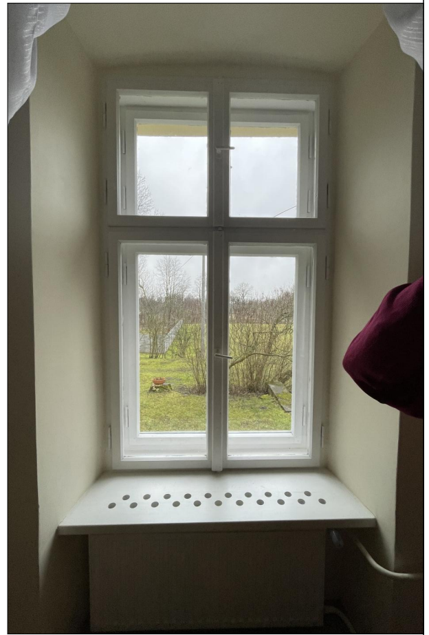
OKNO SKRZYNKOWE ZLOKALIZOWANE NA PARTERZE
