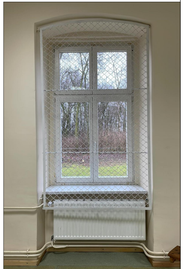
OKNO RAMIAKOWE ZLOKALIZOWANE NA PARTERZE
