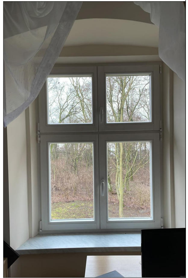
OKNO RAMIAKOWE ZLOKALIZOWANE NA PIĘTRZE
