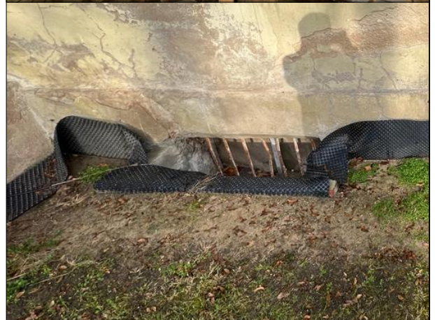
OKNO ZLOKALIZOWANE W PIWNICY
