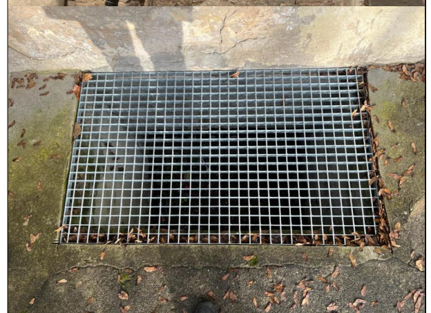
OKNO ZLOKALIZOWANE W PIWNICY
