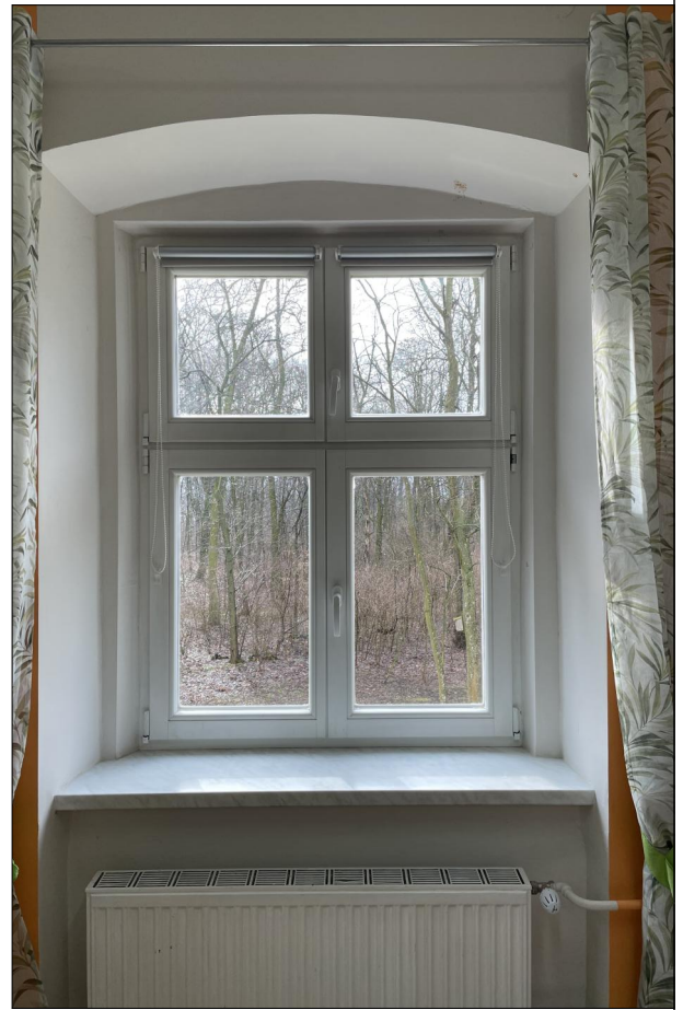
OKNO RAMIAKOWE ZLOKALIZOWANE NA PIĘTRZE
