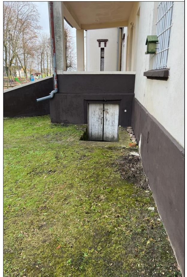
DRZWI ZEWNĘTRZNE DO PIWNICY
