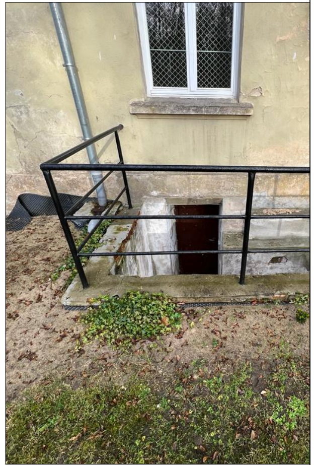
DRZWI ZEWNĘTRZNE DO PIWNICY
