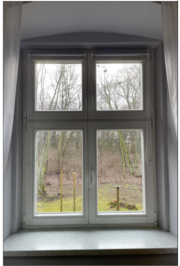
OKNO RAMIAKOWE ZLOKALIZOWANE NA PIĘTRZE
