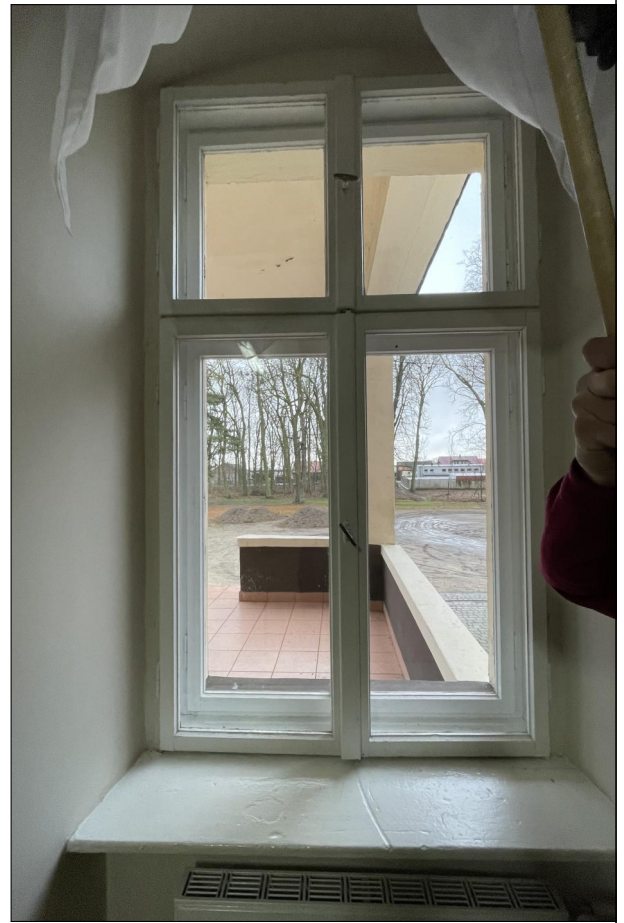
OKNO SKRZYNKOWE ZLOKALIZOWANE NA PARTERZE
