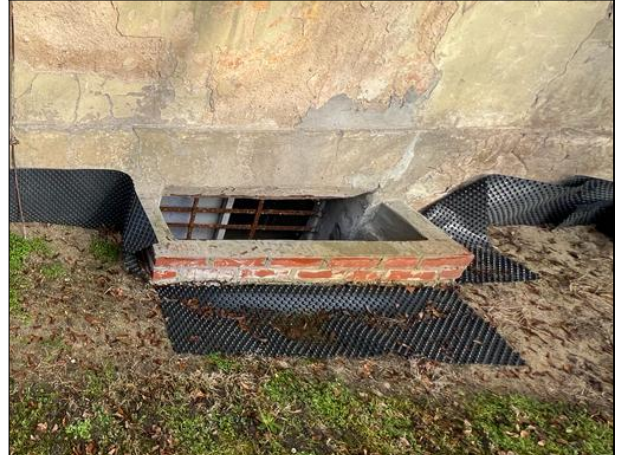
OKNO ZLOKALIZOWANE W PIWNICY
