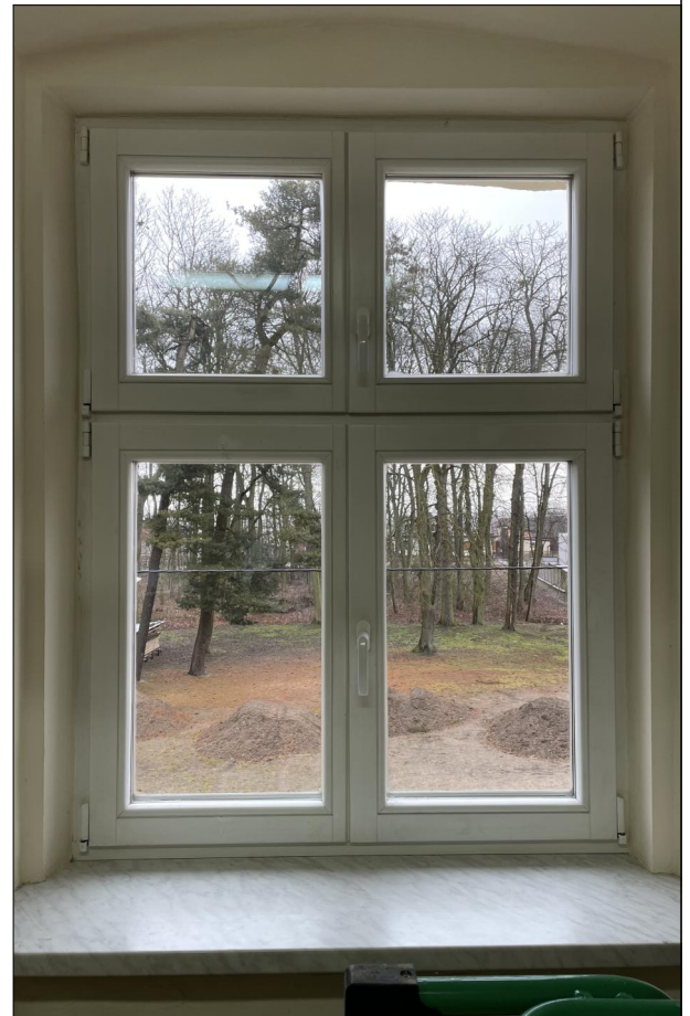
OKNO RAMIAKOWE ZLOKALIZOWANE NA PIĘTRZE
