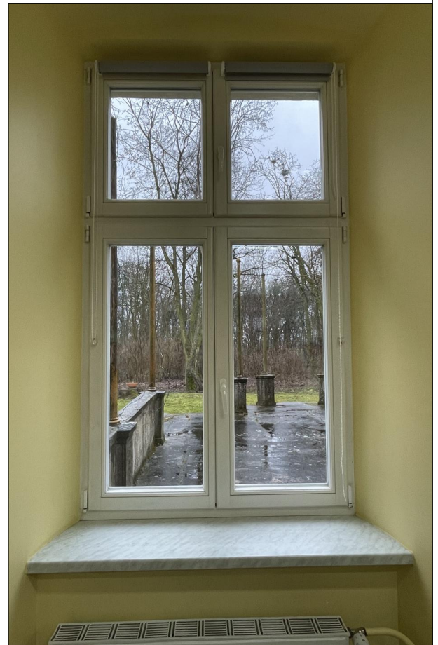
OKNO RAMIAKOWE ZLOKALIZOWANE NA PARTERZE
