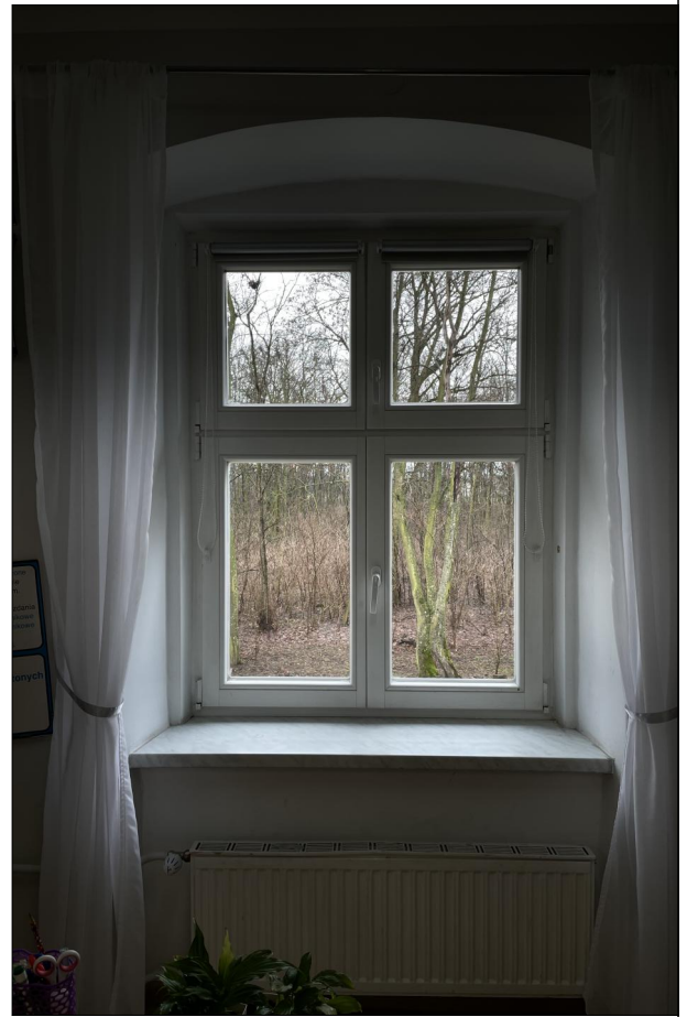
OKNO RAMIAKOWE ZLOKALIZOWANE NA PIĘTRZE
