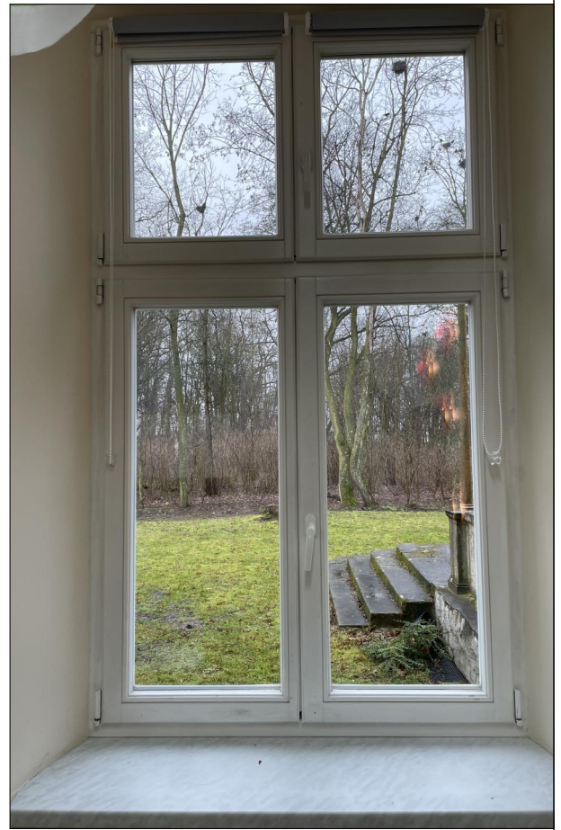
OKNO RAMIAKOWE ZLOKALIZOWANE NA PARTERZE
