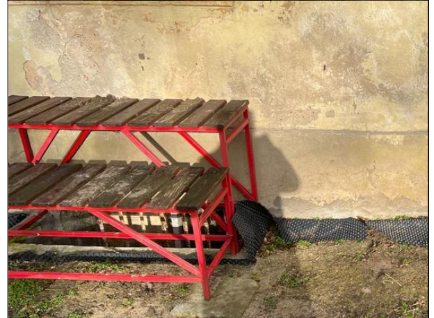
OKNO ZLOKALIZOWANE W PIWNICY
