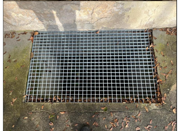
OKNO ZLOKALIZOWANE W PIWNICY
