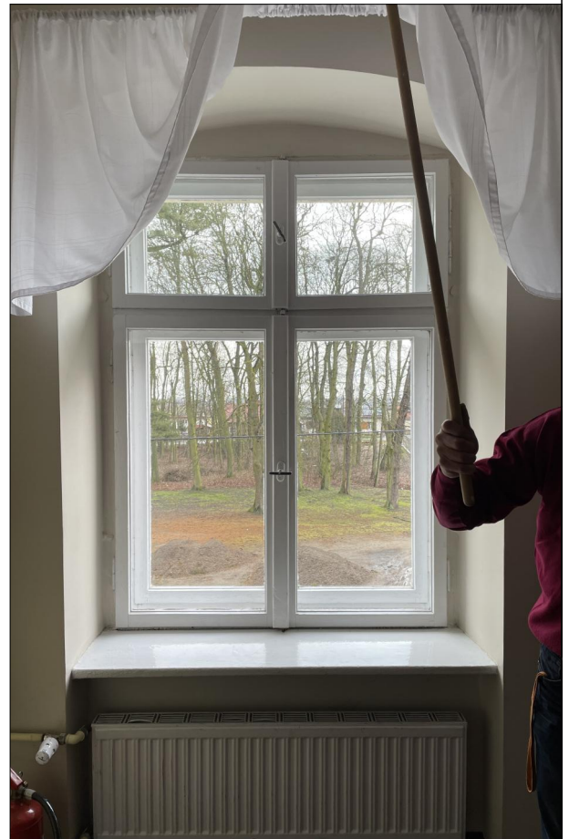
OKNO SKRZYNKOWE ZLOKALIZOWANE NA PIĘTRZE
