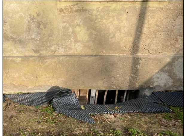
OKNO ZLOKALIZOWANE W PIWNICY
