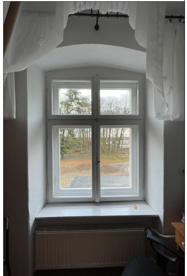
OKNO SKRZYNKOWE ZLOKALIZOWANE NA PIĘTRZE
