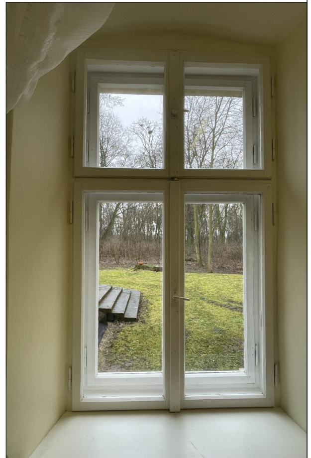
OKNO SKRZYNKOWE ZLOKALIZOWANE NA PARTERZE
