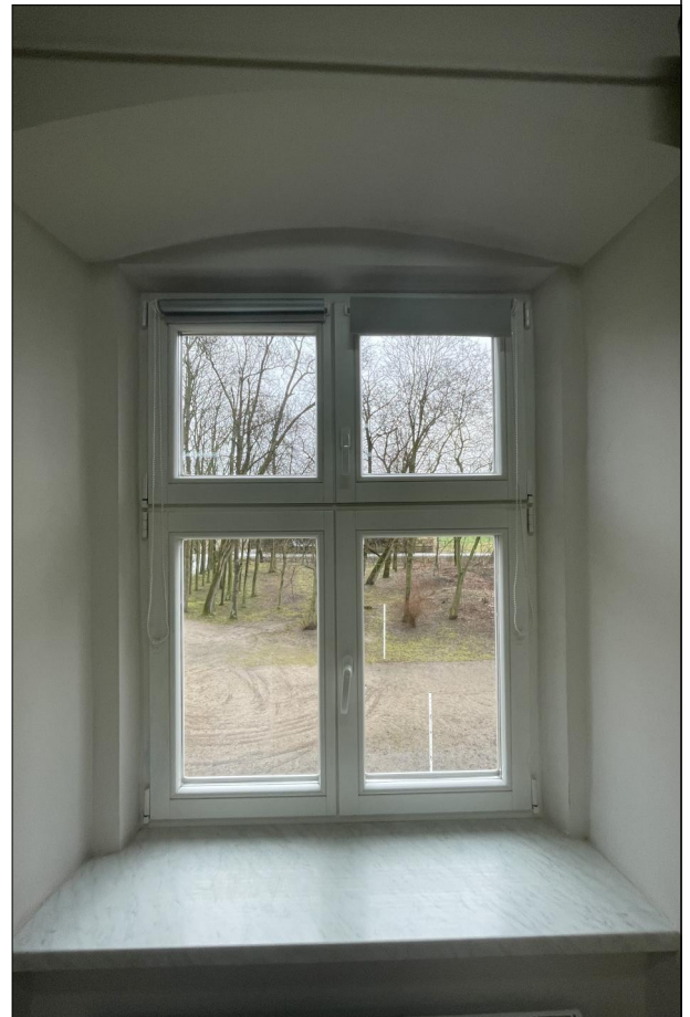
OKNO RAMIAKOWE ZLOKALIZOWANE NA PIĘTRZE
