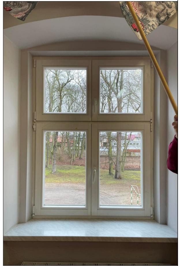
OKNO RAMIAKOWE ZLOKALIZOWANE NA PIĘTRZE
