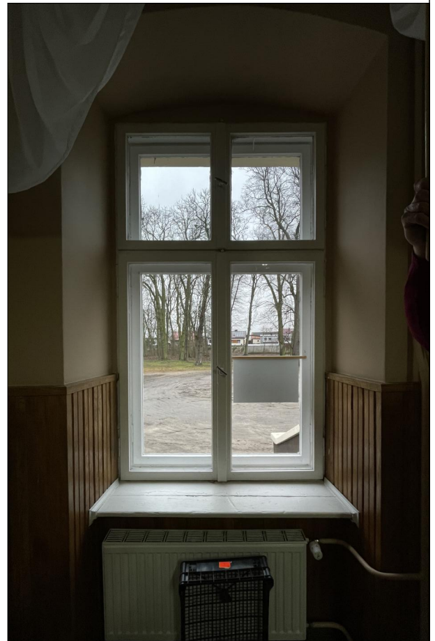
OKNO SKRZYNKOWE ZLOKALIZOWANE NA PARTERZE
