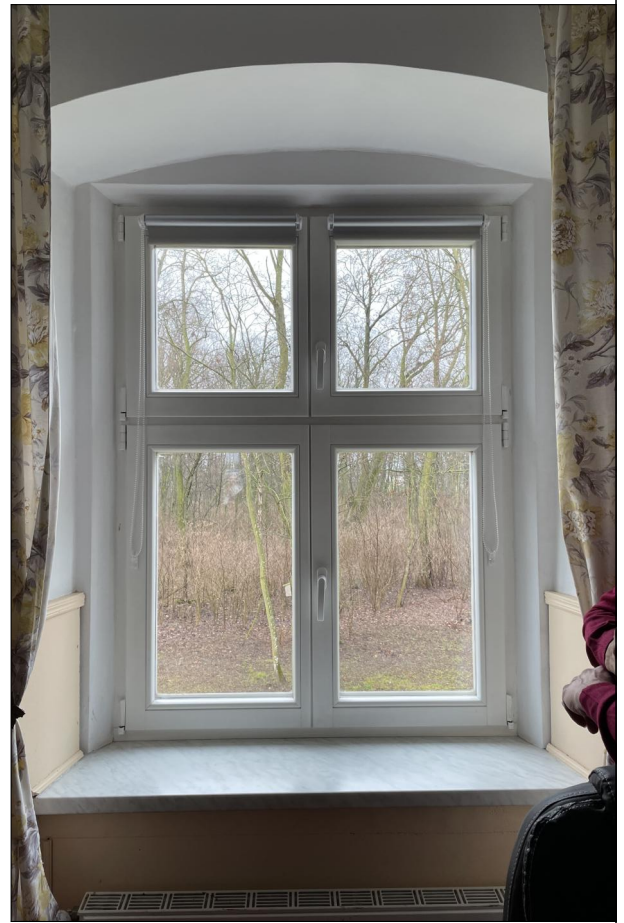
OKNO RAMIAKOWE ZLOKALIZOWANE NA PIĘTRZE
