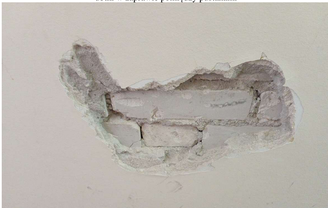
Fot.6-miejsce odkrywki tynku na ścianie działowej-widoczna cegła wapienno-piaskowa
