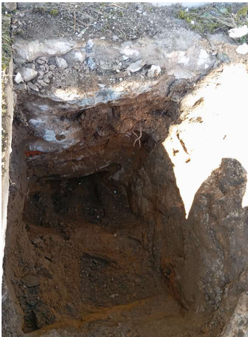
Fot.3-miejsce odkrywki fundamentu-widoczna ława betonowo-kamienna i brak izolacji przeciwwilgociowej
