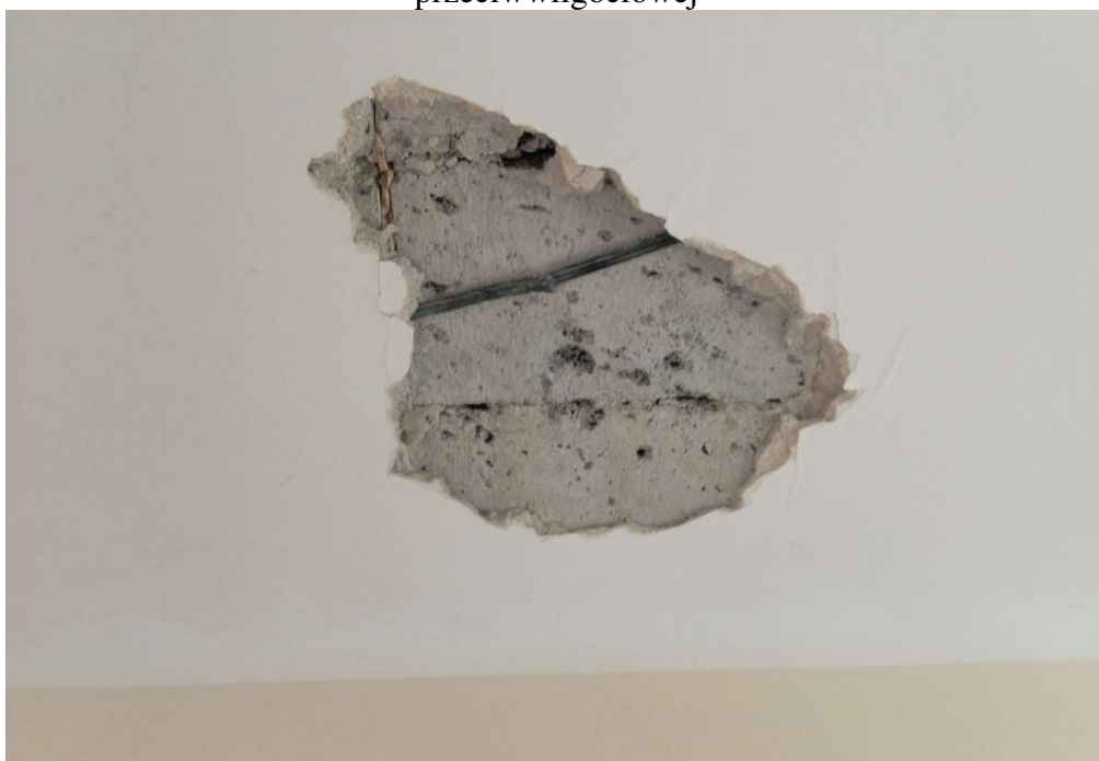
Fot.4-miejsce odkrywki tynku na stropie-widoczne pustaki żużlowo-betonowe
