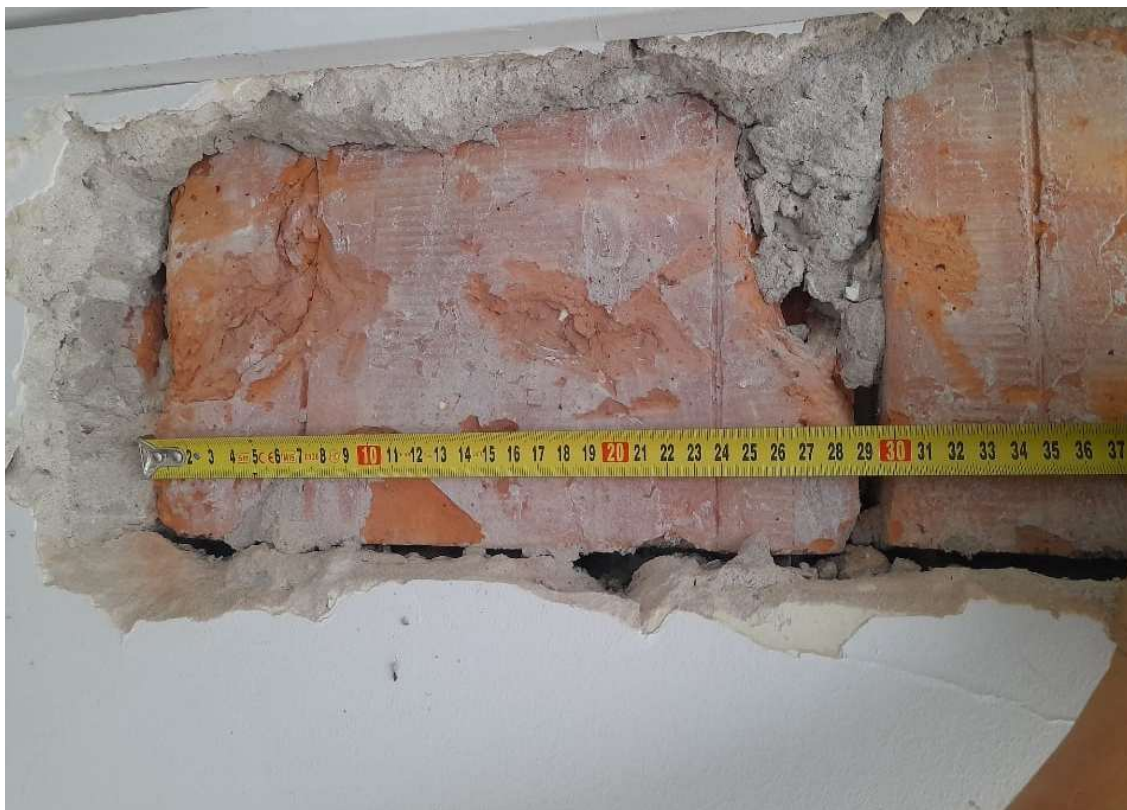
Fot.5-miejsce odkrywki tynku na ścianie wewnętrznej nośnej-widoczne pustaki ceramiczne i ubtki w zaprawie pomiędzy pustakami
