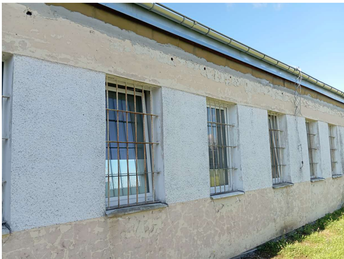
Fot.1-elewacja północna-widoczna złuszczone farba elewacyjna, rysy na tynku oraz nowe orywnowanie
