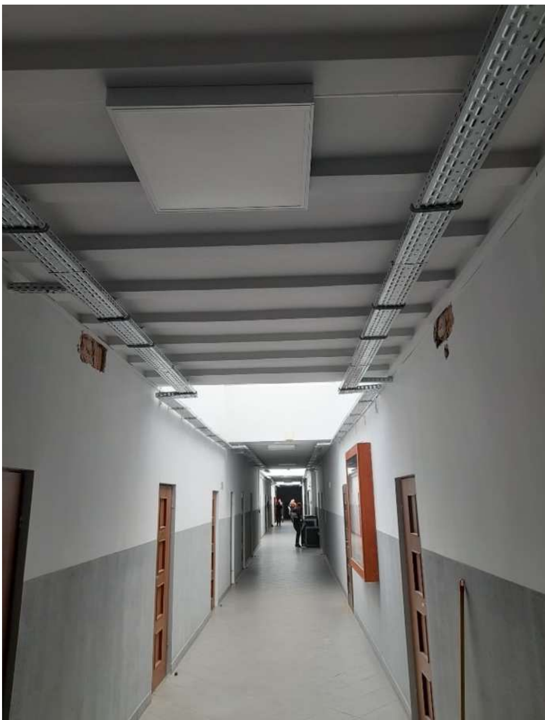
Fot.7-korytarz środkowy widoczny fragmet stropodachu z płyt korytkowych oraz światlik dachowy
