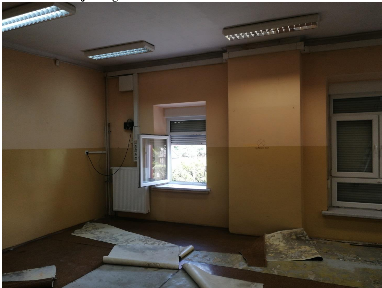
Fot. 1 Widok na ścianę oraz podłogę w czytelnicy
