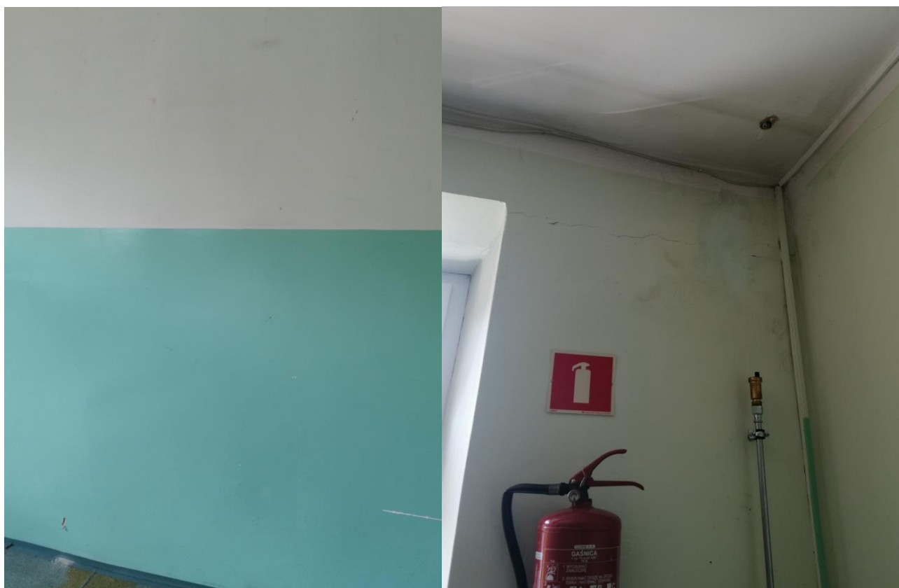
Fot. 12, 13 Ściany w bibliotece
