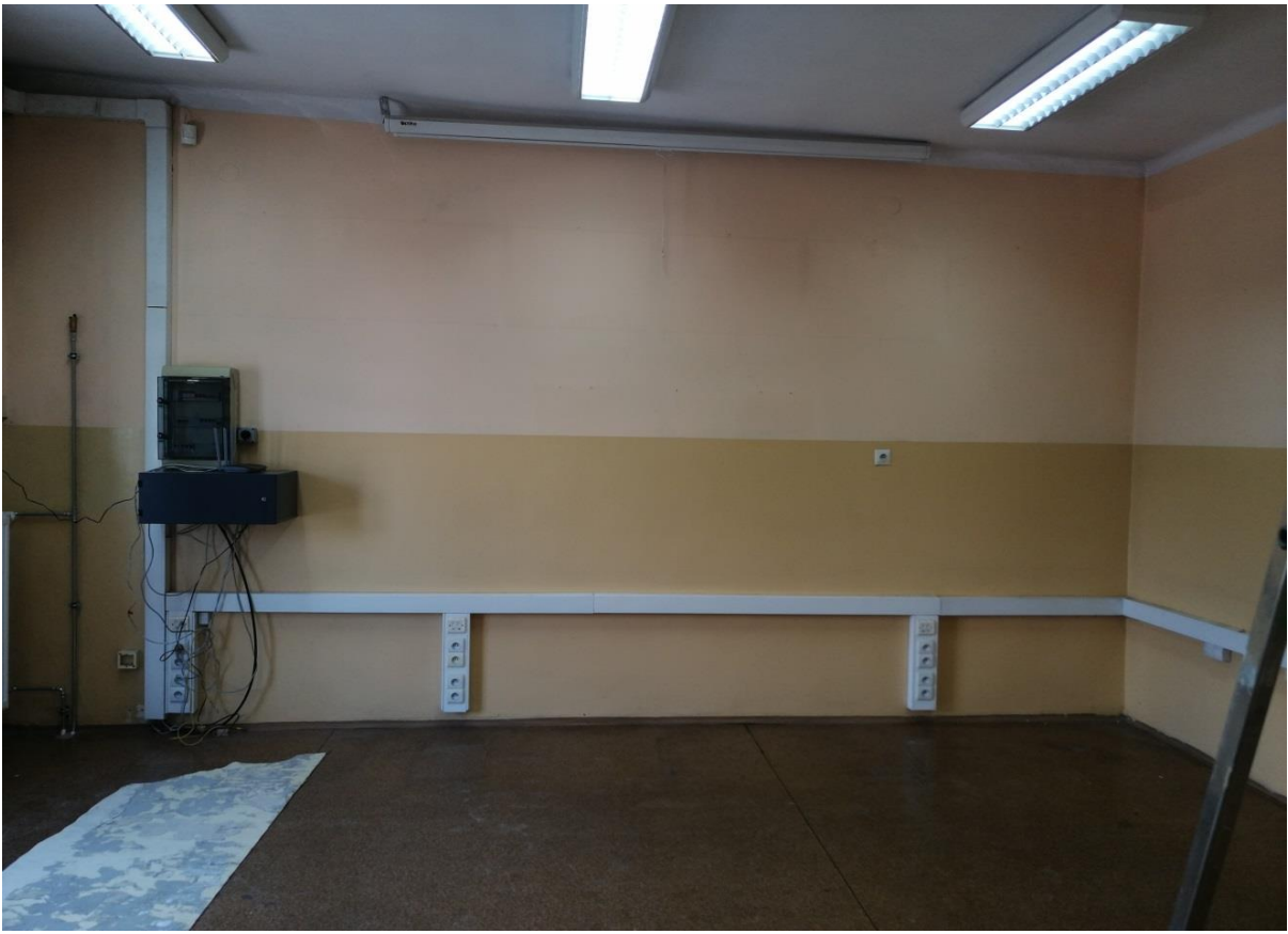
Fot 4. Widok na ścianę w czytelnicy
