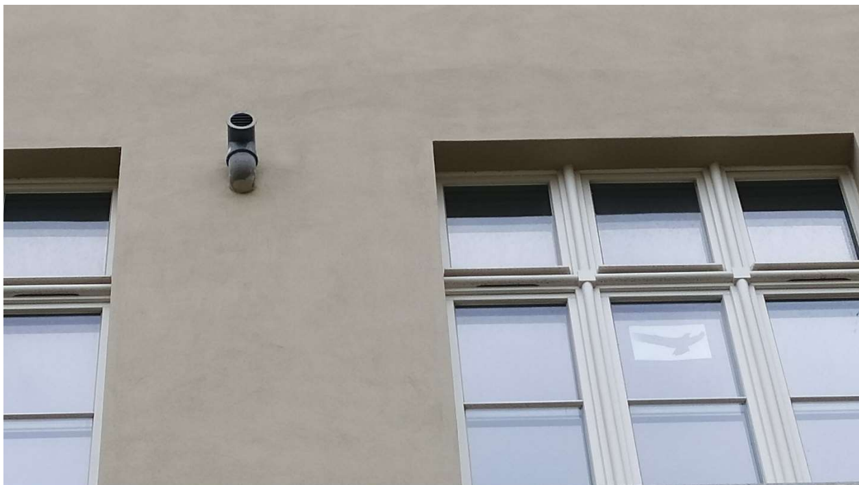
Fot. nr 7: Działanie nr 1 – Elewacja „C” króciec wentylacyjny do likwidacji
