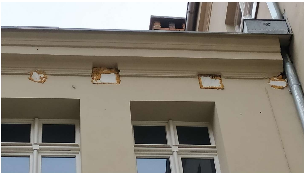
Fot. nr 5: Działanie nr 1 – widok na Elewację „F”, gzyms do odtworzenia po zamowaniu przepustów
