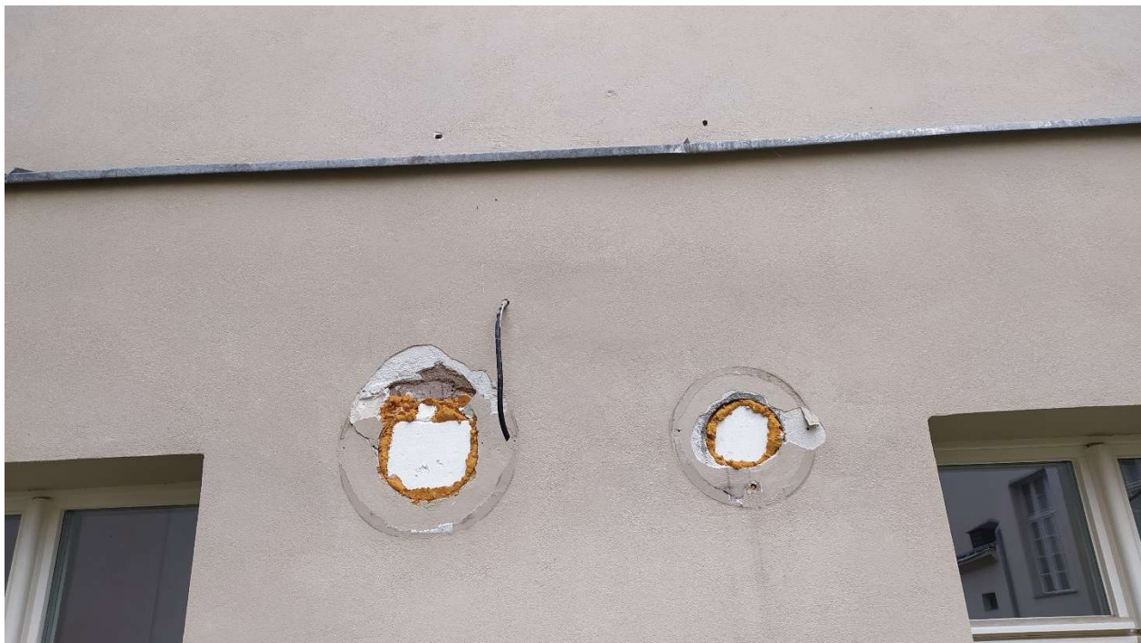
Fot. nr 6: Działanie nr 1 – Elewacja „C” widok na przepusty do zamurowania
