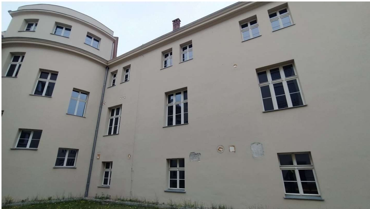
Fot. nr 4: Działanie nr 1 – widok na Elewację „F”, pozostałości po przepustach kanałów wentylacyjnych
