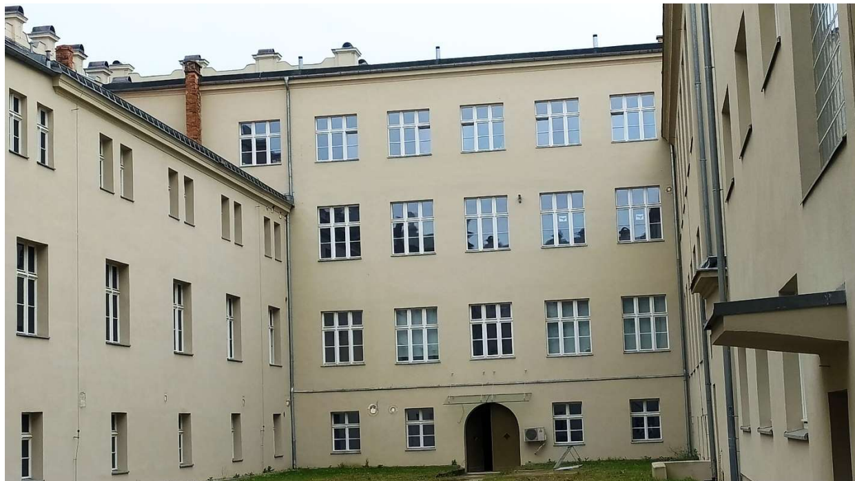
Fot. nr 2: Działanie nr 1 – widok na Elewację „C”
