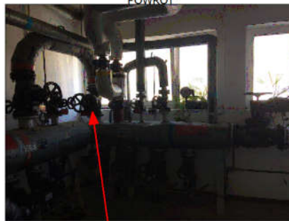
Projektowany powrót Budynku Onkologii DN80
