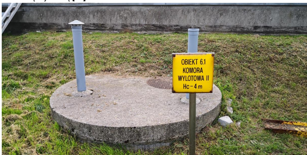
Fot. 10 Komora wylotowa
