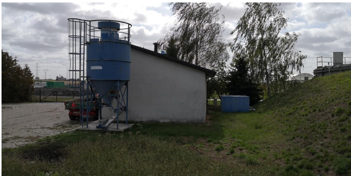
Fot. 17 Silos na wapno
