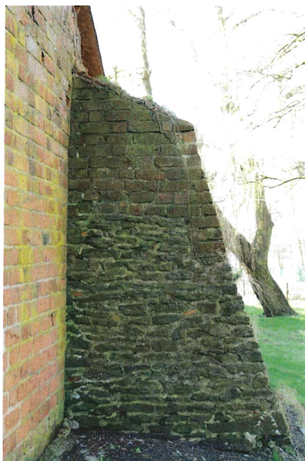
Zastosowanie kamienia do licowania przypór na odcinku północno-zachodnim obwarowań.
