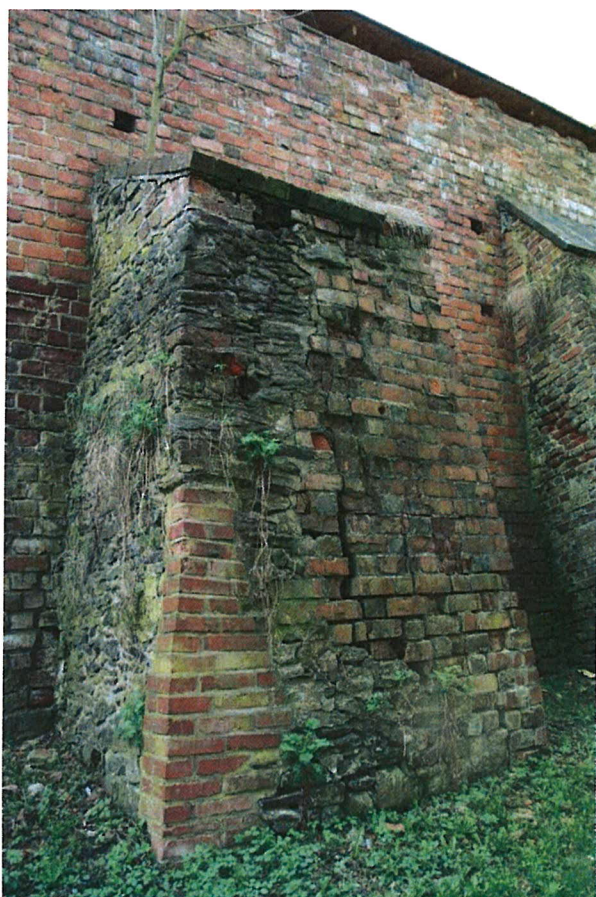
Zastosowanie kamienia do licowania przypór na odcinku północno-zachodnim obwarowań.
