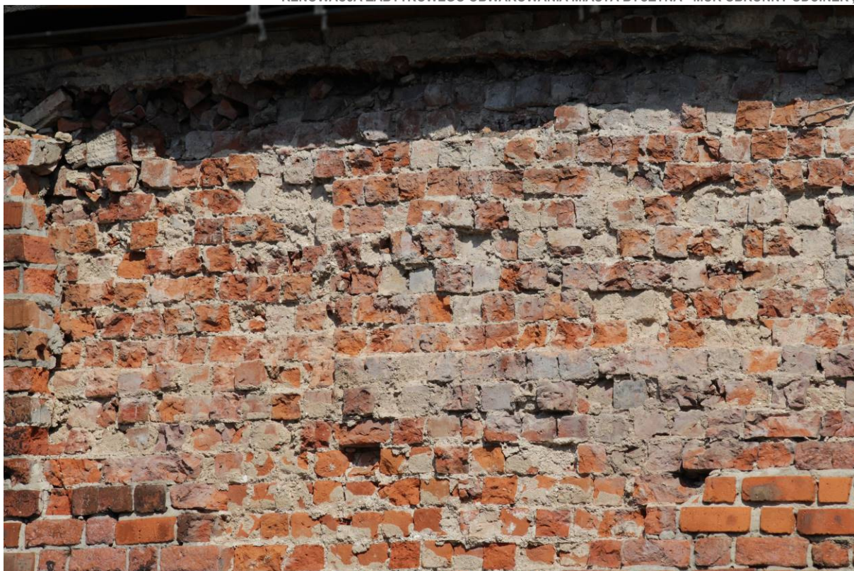
Ubytek lica na odcinku południowo-zachodnim
