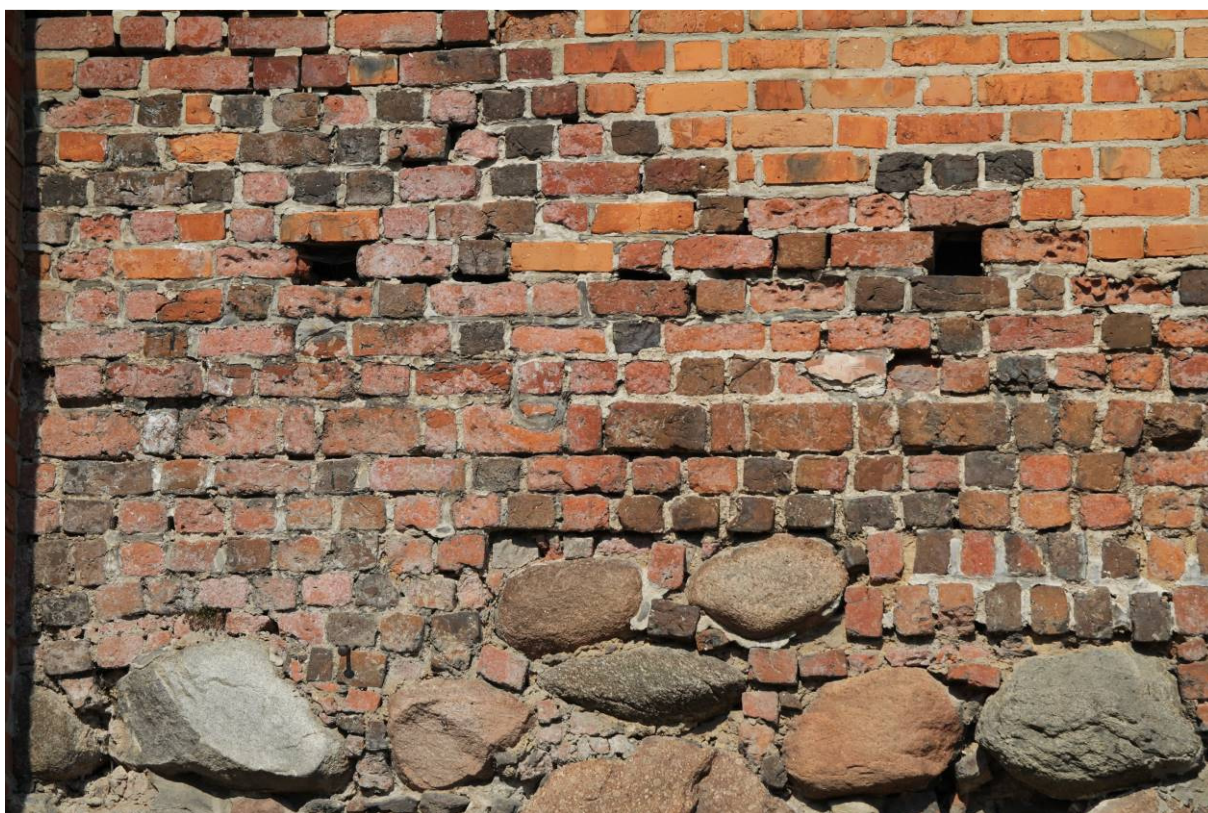
Zróżnicowany układ cegieł lica na fragmencie odcinka południowo – wschodniego murów.
