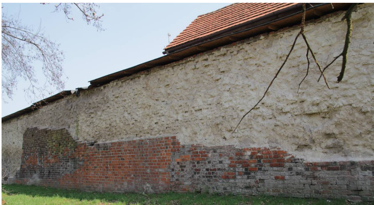
Ubytek lica pokryty tynkiem na odcinku północno-zachodnim
