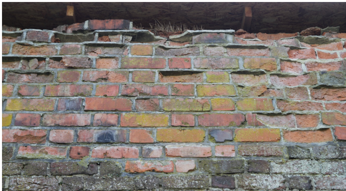
Zniszczenia podpowierzchniowej warstwy cegieł murowanych na zwartej zaprawie cementowej, charakterystyczny obraz stanu zachowania przemurowań w strefie korony murów.
