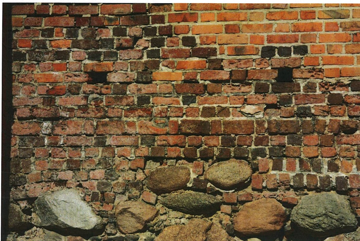
Zróznicowany układ cegieł lica na fragmencie odcinka południowo – wschodniego murów.
