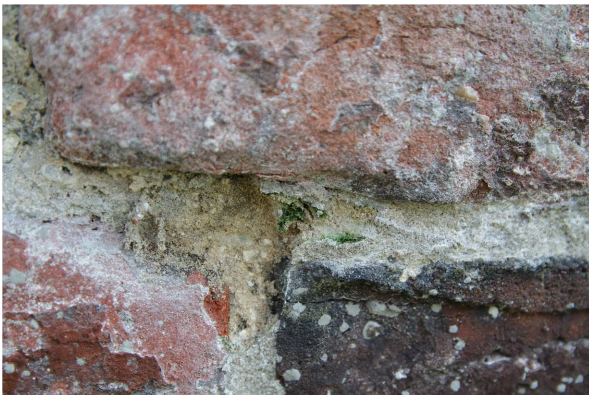
Spoina wapienna z widoczną zieloną warstwą glonów porastającą powierzchnię pod wtórną, uszczelniającą zacierką tynkarską, wysolenia, rozwarstwianie cegieł. Fragment lica muru na odcinku północno-wschodnim
