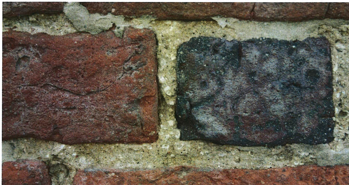
Spoina wapienna na fragmencie muru – odcinek północno-wschodni mogący służyć za wzór dla zaprawy spoinującej. Do weryfikacji na etapie prac remontowo-konserwatorskich.
