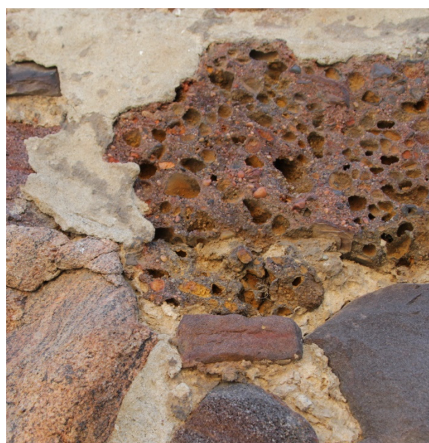
Elewacja wieży zachodniej, przyziemie – stan zachowania elementów kamiennych, pod wtórnym spoinowaniem muru zaprawa wapienna z okresu budowy.
