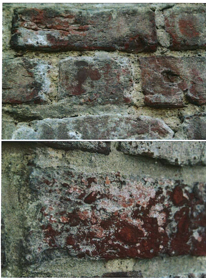
Stan zachowania powierzchni lica na przykładzie fragmentu odcinka północno-wschodniego obwarowań.
