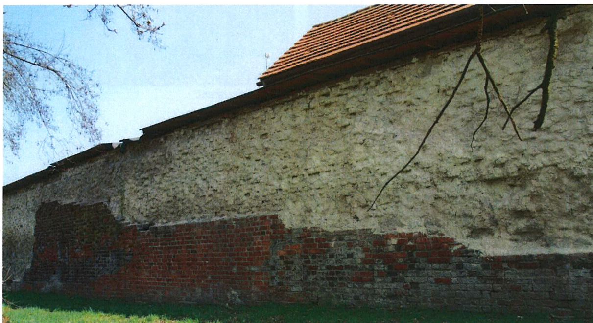
Ubytek lica pokryty tynkiem na odcinku północno-zachodnim
