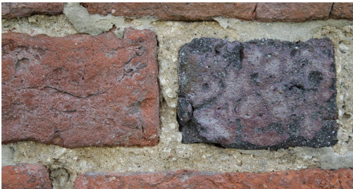
Spoina wapienna na fragmencie muru – odcinek północno-wschodni mogący służyć za wzór dla zaprawy spoinującej. Do weryfikacji na etapie prac remontowo-konserwatorskich.
