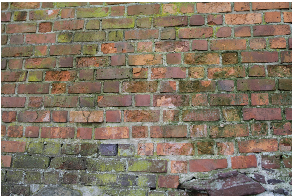
Stan zachowania murów, przykład korozji biologicznej zawilgoconych murów.
