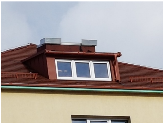
Fot. dach bursy
