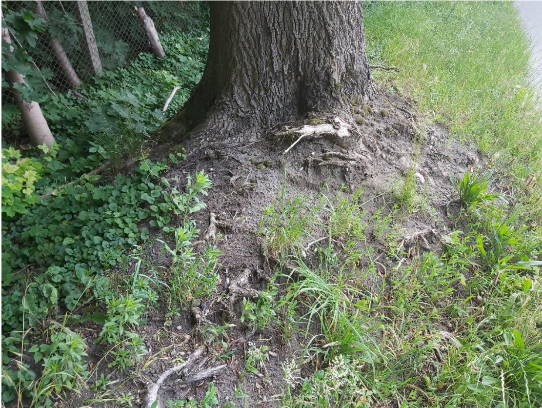
Fot. 133 Jesion nr 24 – uszkodzenia korzeni szkieletowych od strony ulicy
