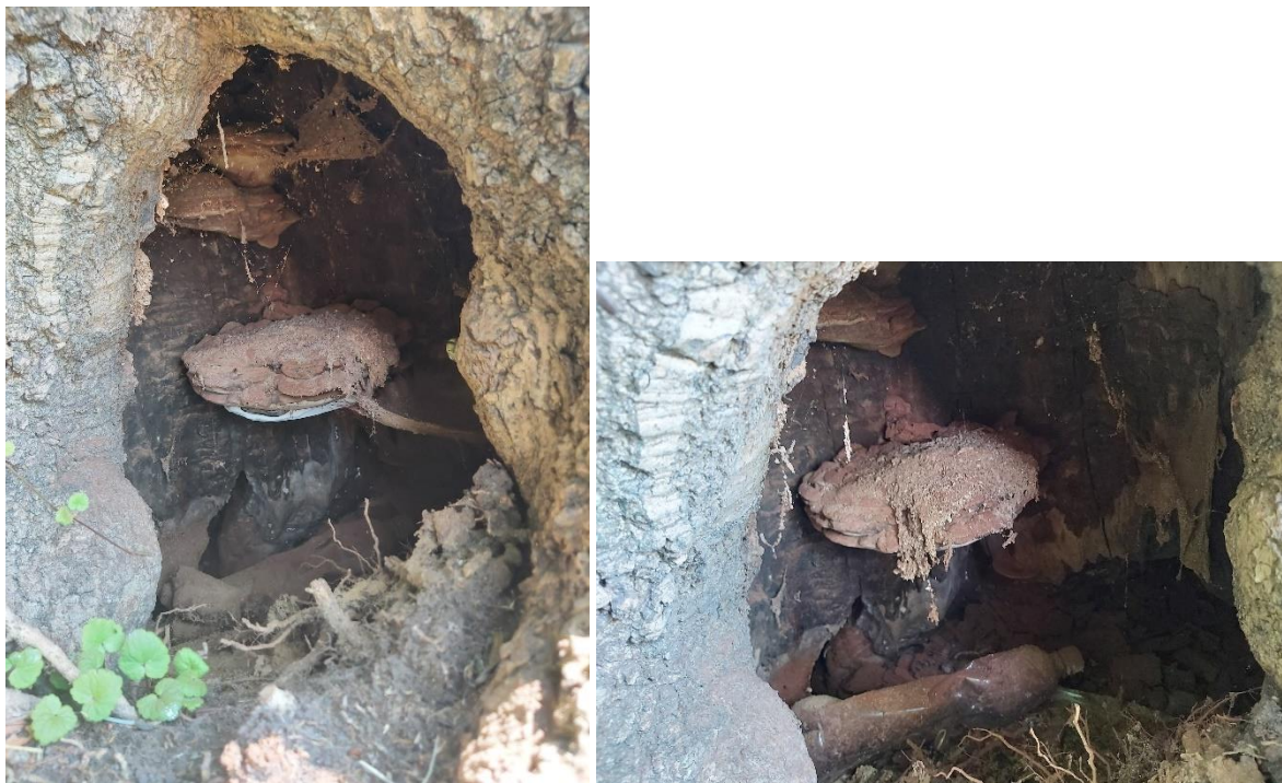
Fot. 104,105 Jesion wyniosły nr 21 -wewnątrz ubytku zaawansowany rozkład i brunatna zgnilizna oraz liczne (w tym wieloletnie) owocniki lakownicy spłaszczonej ( Ganoderma applanatum ). Ubytek przekracza 70% przekroju poprzecznego pnia u jego podstawy. Mocowanie drzewa w gruncie może być w znacznym stopniu osłabione.
