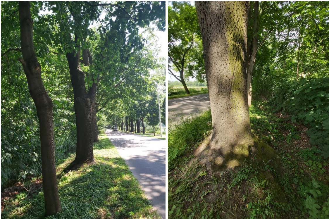
Fot. 45, 46 Jesion wyniosły nr 10 - widok od strony zachodniej; pień z zabliznionym starym pęknięciem (od strony wschodniej) oraz wyraźne nabiegi korzeniowe
