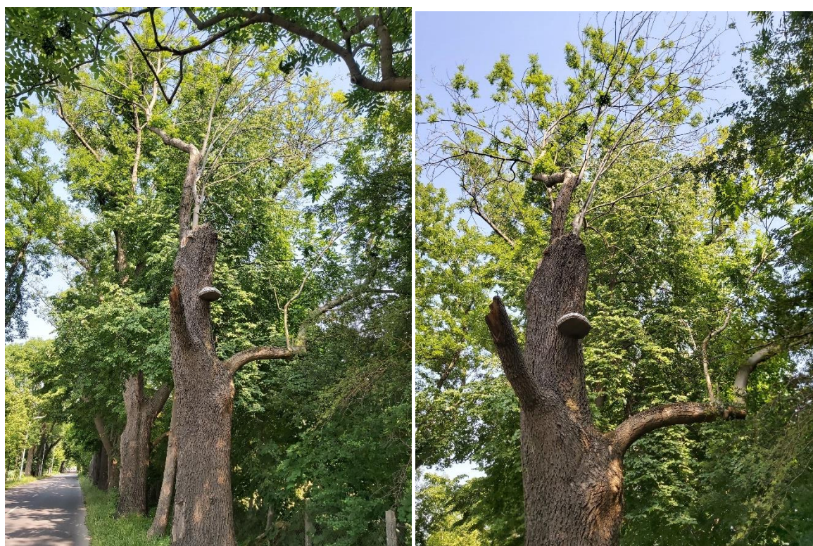
Fot. 137,138 Jesion nr 25 – Wyłamany przewodnik na wysokości ok. 7m. Pozostał kikut z postrzępionymi krawędziami i widocznym rozkładem, koronę tworzą jedynie dwa konary: jeden od strony zachodniej, drugi od strony północnej; Od strony wschodniej na wysokości ok. 6-7m wieloletni owocnik hubiaka ( Fomes fometarius )
