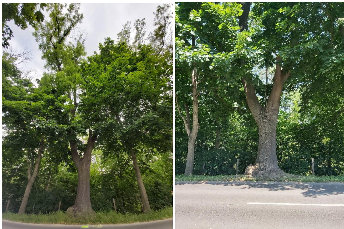
Fot. 67, 68 Jesion wyniosły nr 15 - rozwidlenie szeroko U-kształtne prawidłowe od wysokości ok 4m bez oznak pęknięć ani zakorka. Korona regularna z nieznaczną ilością suszu głównie w szczytowych partiach, konar od strony zachodniej zdecydowanie wyższy (górujący) od wschodniego, korona średnio zagęszczona, wykazująca przyrosty krótko i długopędów
