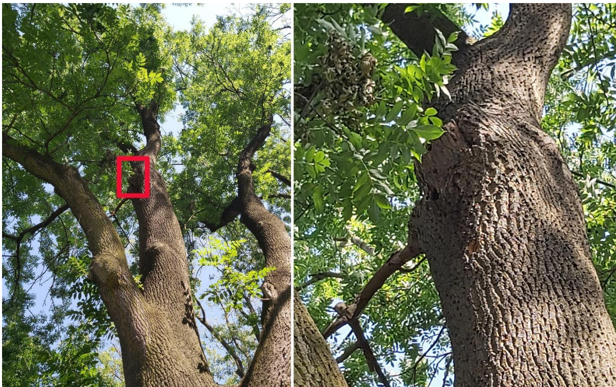
Fot. 231, 232 Jesion nr 41- na wysokości ok. 8-9m na centralnym konarze ślad po wyłamaniu w przeszłości konarze z zaawansowanym rozkładem, w rejonie którego stwierdzono 2 dziuple wykute przez dzięcioła
