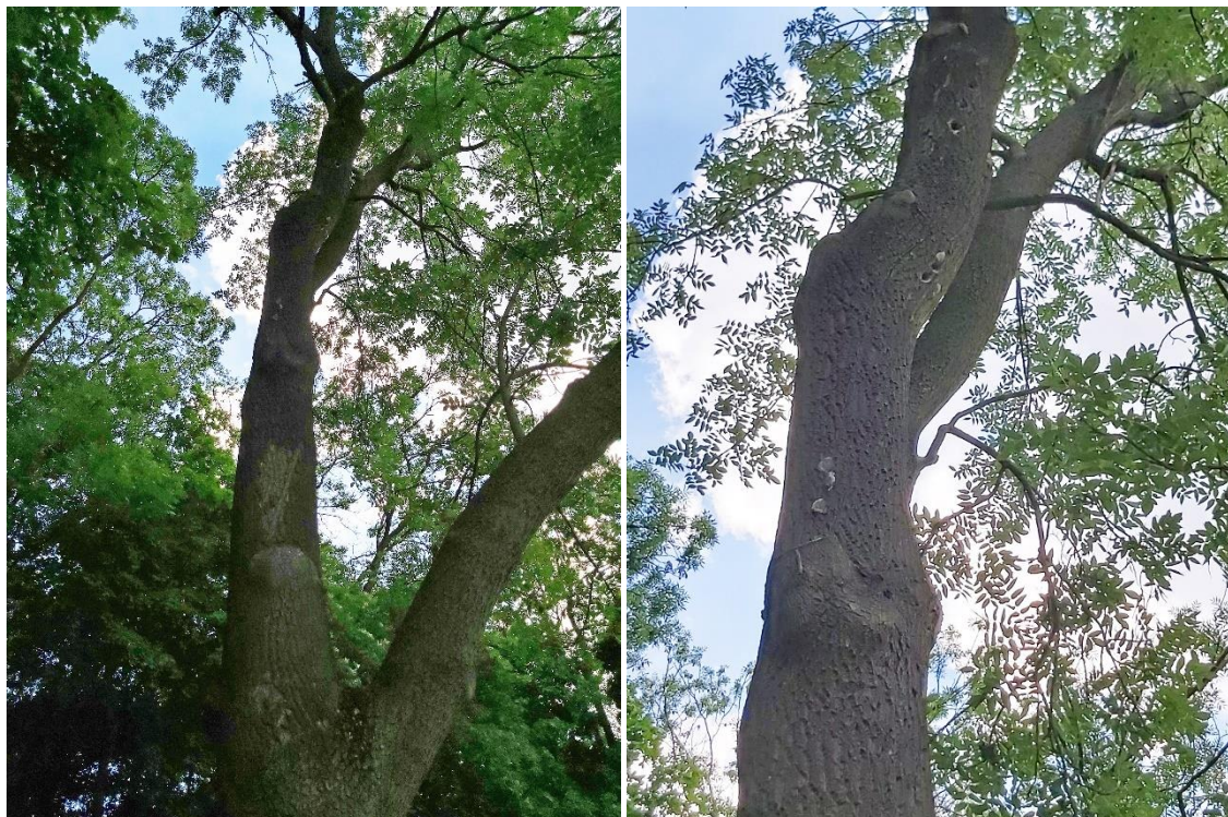
Fot. 283, 284 Jesion nr 52- konar centralny (w osi drzewa) prosty z wysoko osadzoną koroną i licznymi dziuplami wykutymi przez dzięcioła na wysokości ok.7m (6 dziupli); miejsce jest osłabione co zwiększa ryzyko złamania
