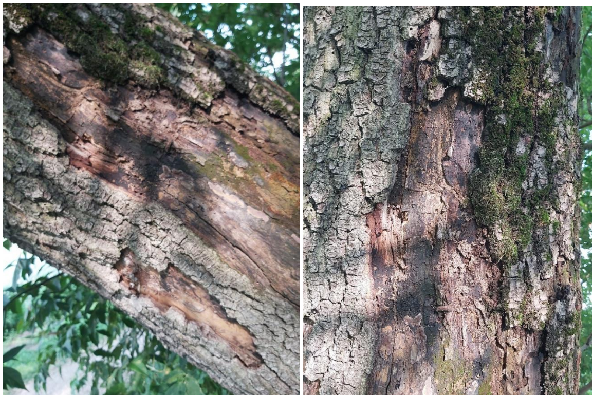
Fot. 211, 212 Jesion nr 37- konar od strony południowej jest powierzchniowo zbutwiały z podłużnymi i poprzecznymi pęknięciami -może stanowić zagrożenie
