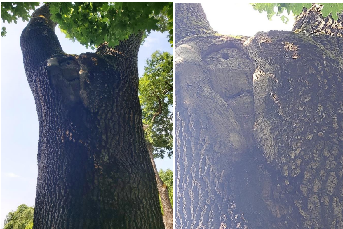
Fot. 188,189 Jesion nr 34 – od strony północnej na wysokości ok. 3m, czyli poniżej rozwidlenia potężny ślad po usuniętym w przeszłości konarze, zabliźniony jedynie na krawędziach z widocznym rozkładem w części centralnej
