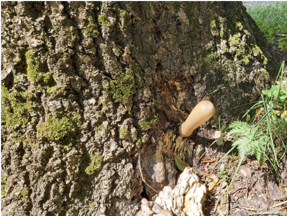
Fot. 264 Jesion nr 48- od strony północnej między nabiegami ubytek z rozkładem; sondowanie wykazało rozległy rozkład (sonda weszła na całą długość); widoczna biała zgnilizna, opukiwanie pnia młotkiem wykazało obecność pustych przestrzeni do wysokości ok 1,5m
