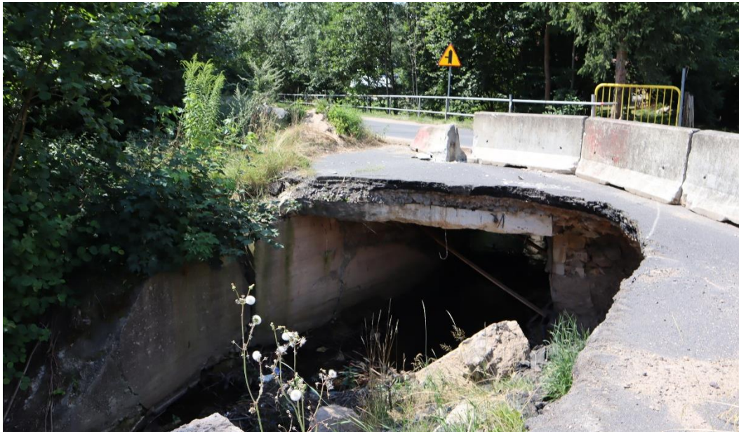
Fot. 1. Widok obiektu od strony dolnej wody.
