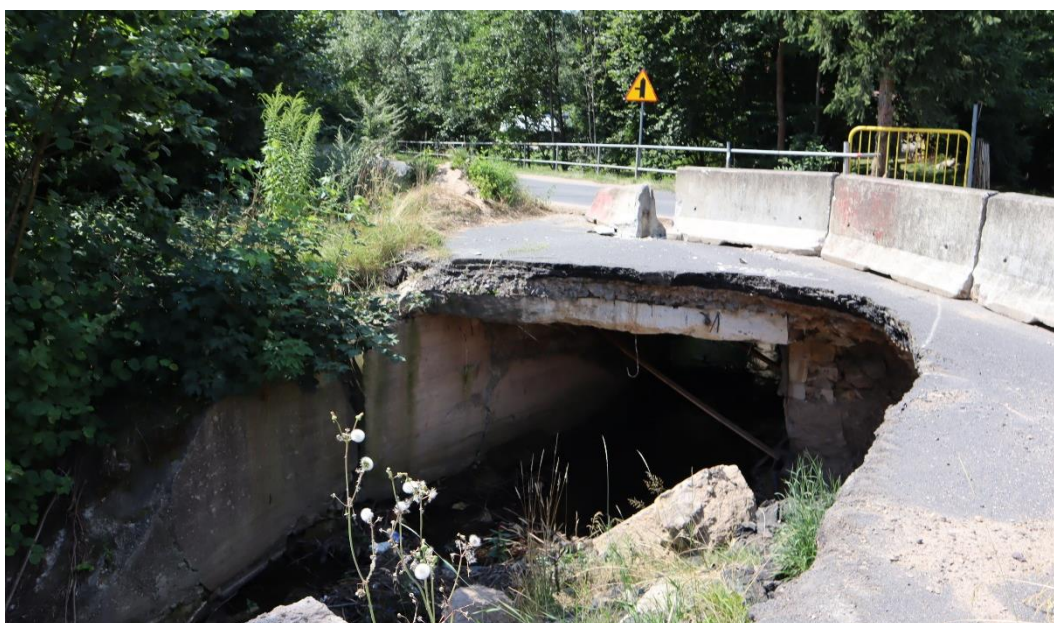
Fot. 1. Widok obiektu od strony dolnej wody.
