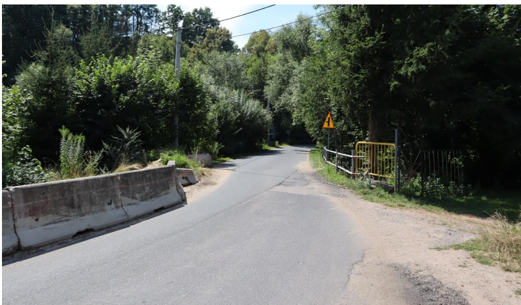
Fot. 3. Widok obiektu od strony północno-wschodniej.
