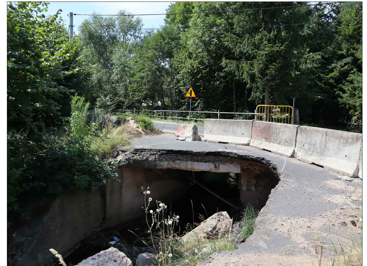
Widok obiektu od strony górnej wody.
