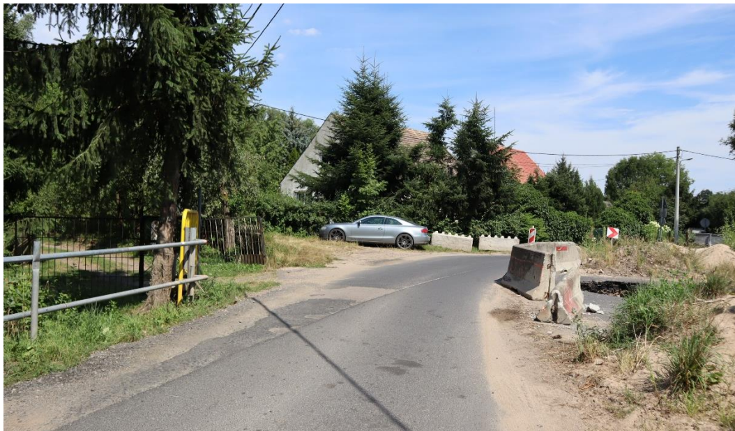
Fot. 4. Widok obiektu od strony południowo-zachodniej.
