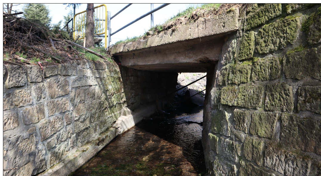
Widok obiektu od strony dolnej wody.
