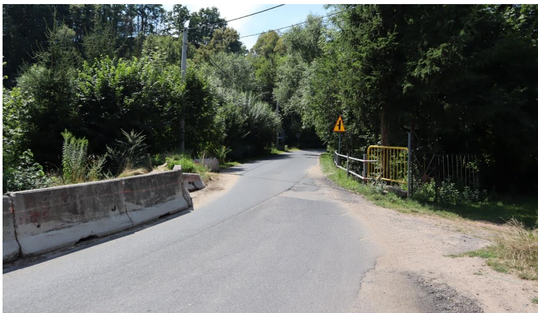
Fot. 3. Widok obiektu od strony północno-wschodniej.
