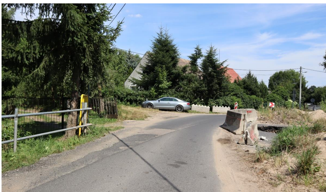
Fot. 4. Widok obiektu od strony południowo-zachodniej.
