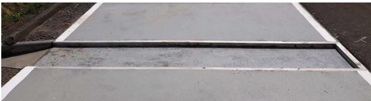
Rys.4. Zagłębienie na wagi przenośne typu WWS w kształcie jednostronnie otwartej rynny umożliwiającej grawitacyjny odpływ wody opadowej.
