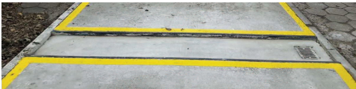
Rys.5. Zagłębienie pod wagi przenośne typu WWS w kształcie zamkniętej rynny ze studzienką odwadniającą.
