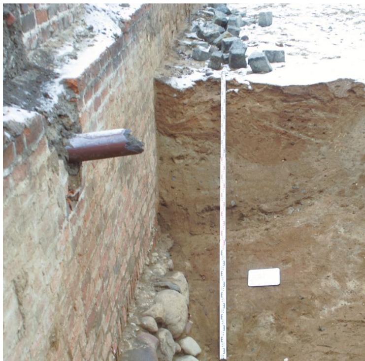
Il. 5. Sondaż 1. Profil A. Wkop fundamentowy muru oporowego fosy wykonany w nawarstwieniach żwirowych, zasypany jednocześnie całym żwirem. W prawym rogu fotografii widoczny nienaruszona naturalna struktura calca. Fot. P. Alagierski.
