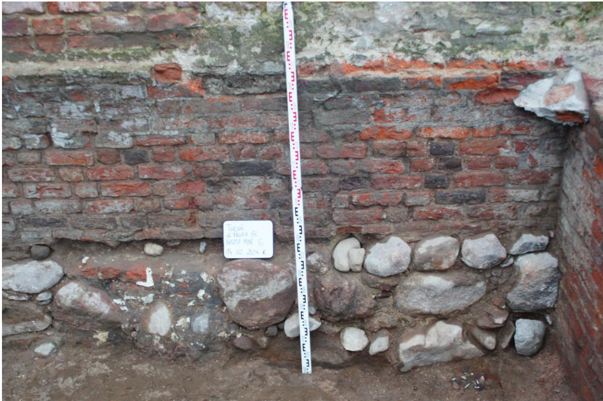
II.21. Strefa fundamentowa baszty. Fot. Piotr Alagierski.
