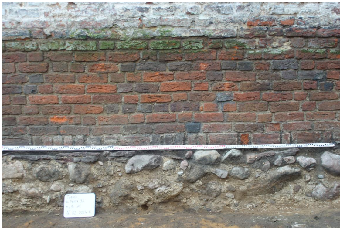
Il. 13. Fundament XIII w. muru A wraz z widoczną rolką wyrównującą. Fot. P. Alagierski.
