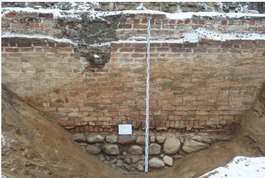
Il. 17. Sondaż 1 mur B. Strona S. widoczny fundament muru oporowego fosi nowomiejskiej. Fot. P. Alagierski.
