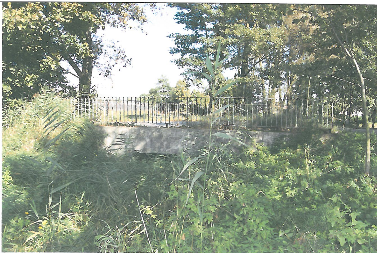
Fot. 2. Widok przepustu z boku
