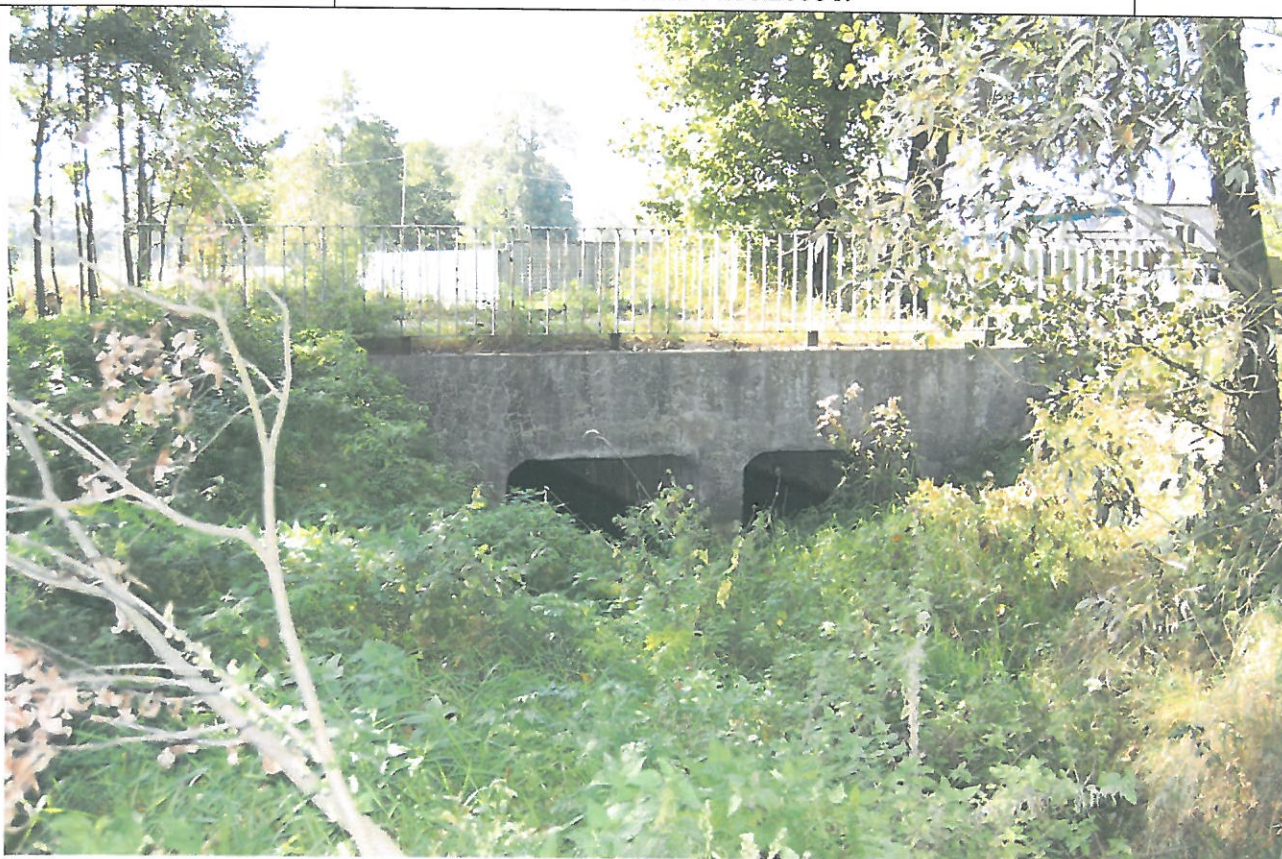
Fot. 1. Widok przepustu z boku
