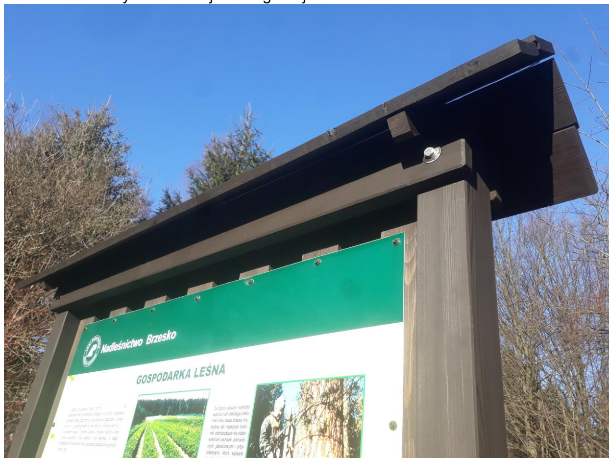
Daszek stelaża tablicy i konstrukcja belki górnej
