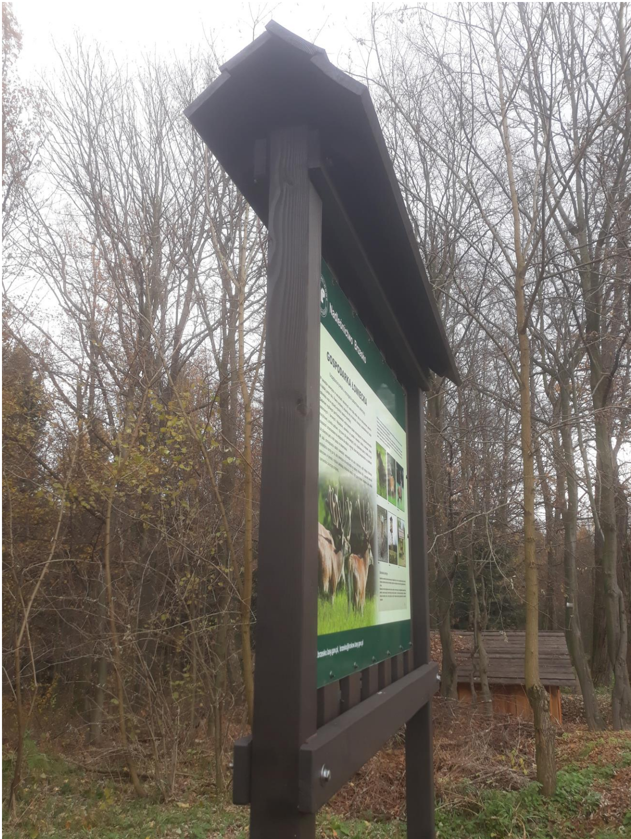
Widok konstrukcji stelaża tablicy – daszek na zakładkę, belki wzmacniające górne i dolne
