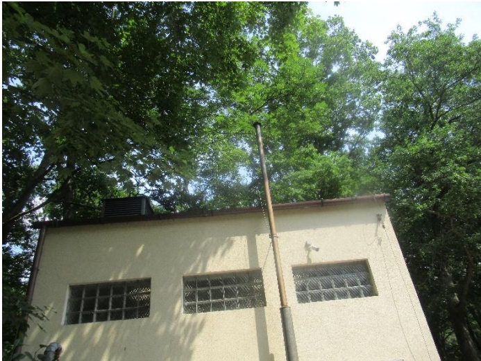
Zdj. nr 1. Stacja transformatorowa przy pompowni P1.
