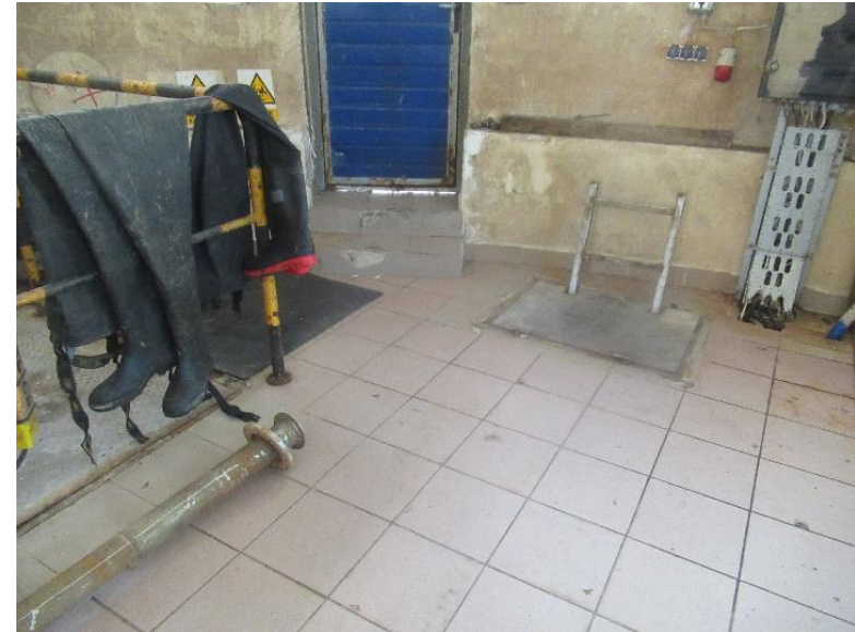
Zdj. nr 6. Pomieszczenie urządzeń sterujących w pompowni P1. – zabicie zawilgoconych tynków, wiercenie otworu na kratkę wentylacyjną, szpachlowanie, malowanie.
