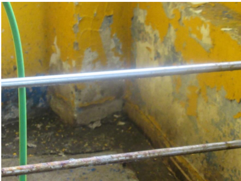
Zdj. nr 13. Pomieszczenie skratek w pompowni P1 – prace wykonać analogicznie jak opisano pod zdj. nr 12.
