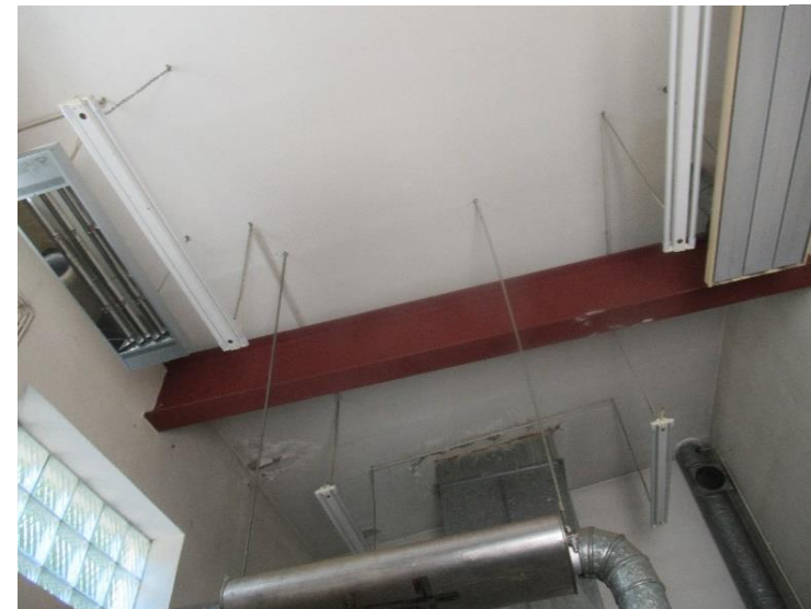
Zdj. nr. 4. Stacja transformatorowa przy pompowni P1 – miejsca przecieków dachu przy kanale wyrzutni powietrza – zbitcie tynku, szpachlowanie, malowanie.
