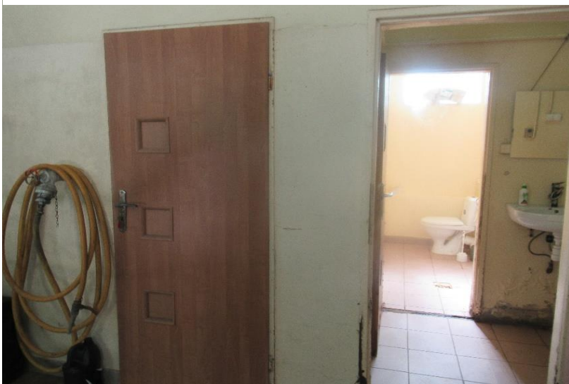
Zdj. nr 7. Na lewo magazyn w pompowni P1 – malowanie wnętrza, wymiana drzwi. Na Prawo pomieszczenie socjalno-bytowe – zabicie zmurszałych tynków, szpachlowanie, malowanie
