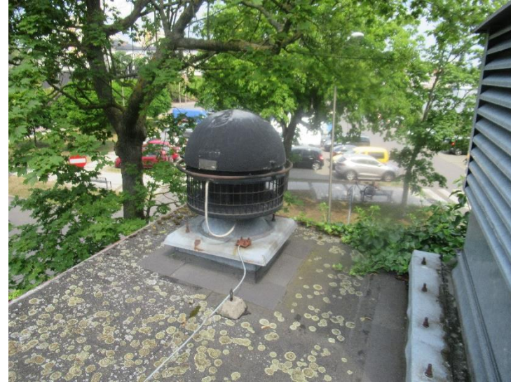
Zdj. nr 16. . Stacja transformatorowa przy pompowni P2. – Wykonać naprawy pokrycia dachowego przy wentylacji mechanicznej.
