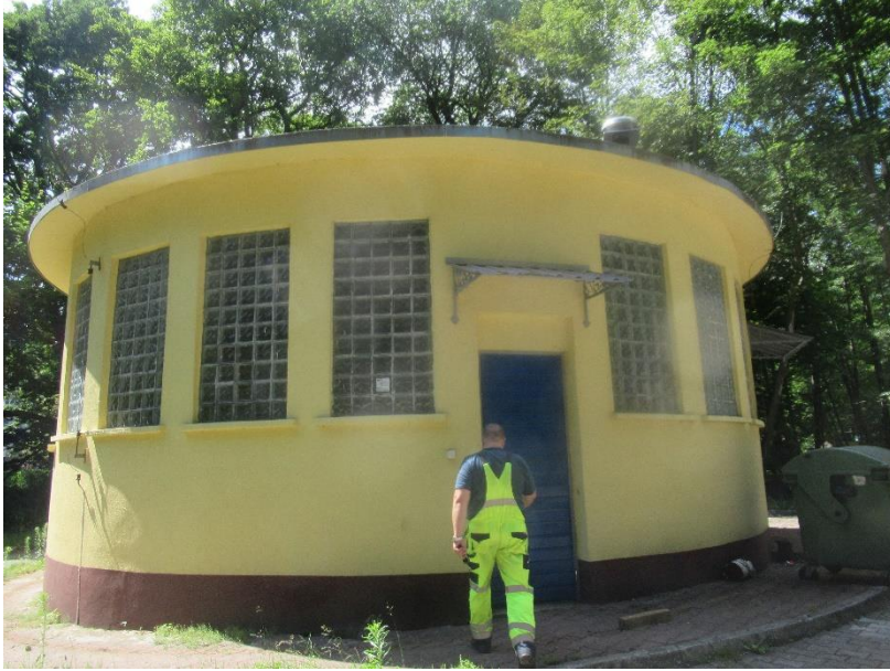
Zdj. nr 5. Pompownia P1.
