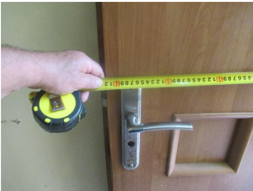
Zdj. nr 11. Pomieszczenie socjalne w pompowni P1 – wymiar drzwi.
