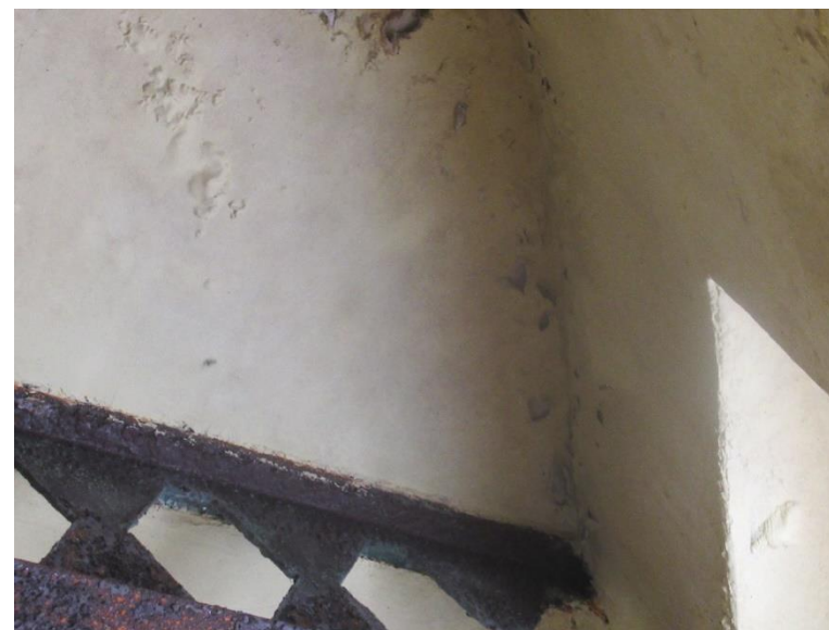
Zdj. nr 14. Pomieszczenie skratek w pompowni P1 - Czyszczenie rdzy i zabezpieczenie konstrukcji stalowej farbą antykorozyjną.
