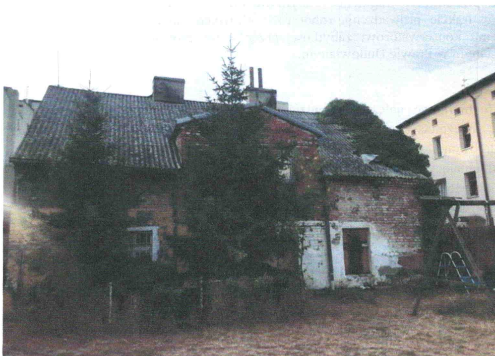
fot. nr 2 Widok ogólny budynku oficyny mieszkalnej przewidzianej do rozbiórki – tył od strony podwórza – widoczny ubytek poszycia dachowego.
