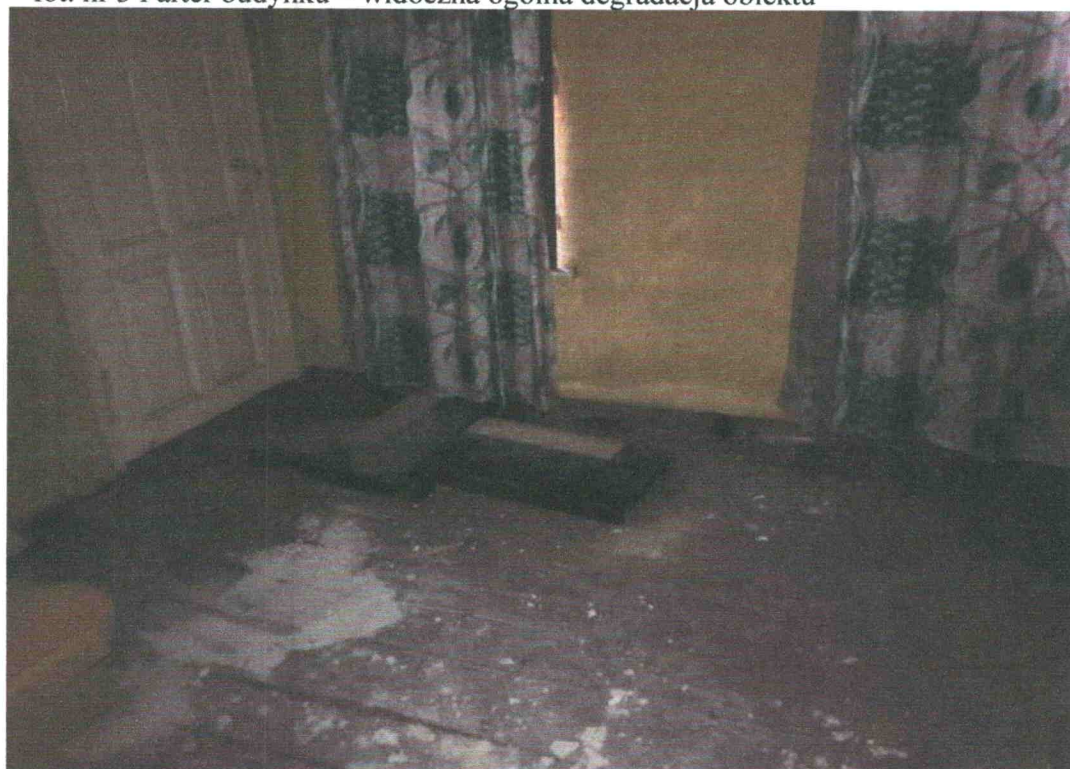
Fot. nr 4 Parter – pomieszczenie od strony działki nr 82 – widoczne zarwanie stropu piwnicy zabezpieczone deskami.
