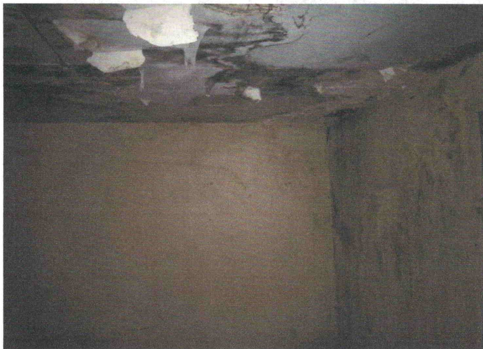
fot. nr 5 Parter – efekt zalania ścian i stropu parteru – elementy stropu grożą awarią.
