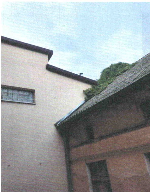
fot. nr 9 połączenie budynku z bud. oficyny na działce nr 82 – w trakcie oględzin stwierdzono że każdy z budynków ma niezależną ścianę – założenie potwierdzić po rozbiórce obróbek na styku i dokonaniu stosownych odkrywek.
