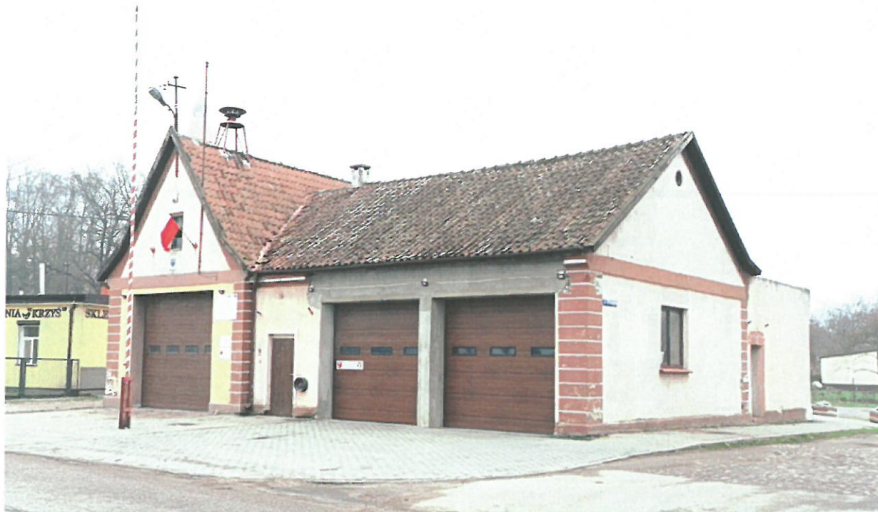
Fot. 1. Widok elewacji frontowej północno - zachodniej - widok ogólny
