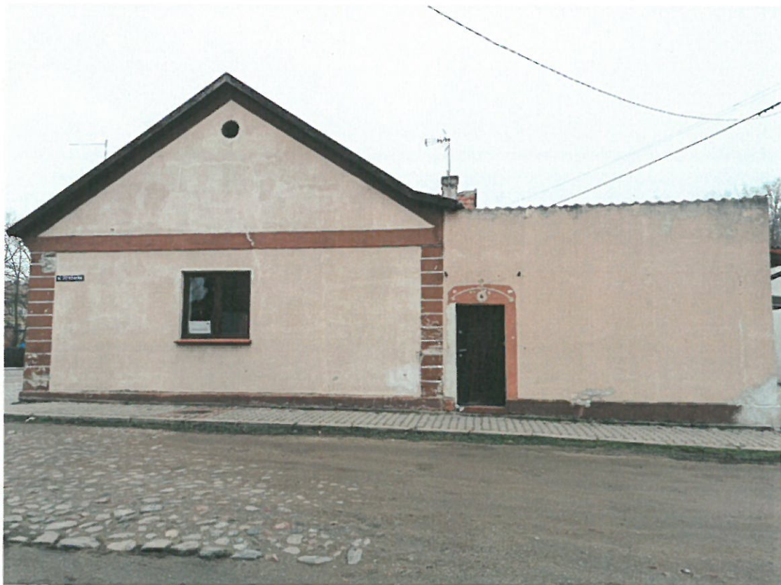
Fot. 8. Elewacja północno-wschodnia - widok ogólny
