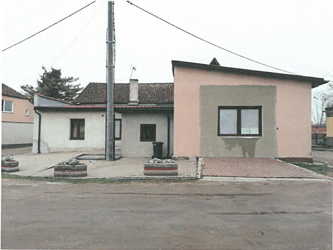
Fot. 7. Elewacja południowo-wschodnia - widok ogólny
