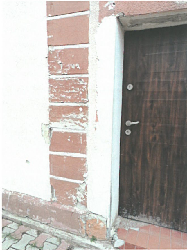
Fot. 11. Ozdobne boniowanie - stan zachowania
