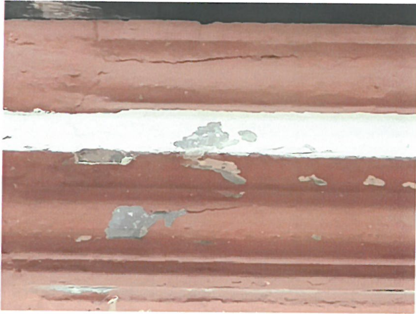
Fot. 3. Detal architektoniczny wieńczący wykonany w technice ciągniętej - stan zachowania
