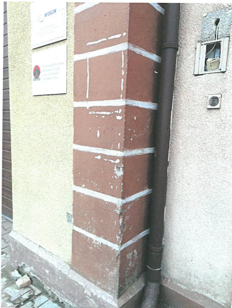
Fot. 4. Ozdobne boniowanie naroża- stan zachowania
