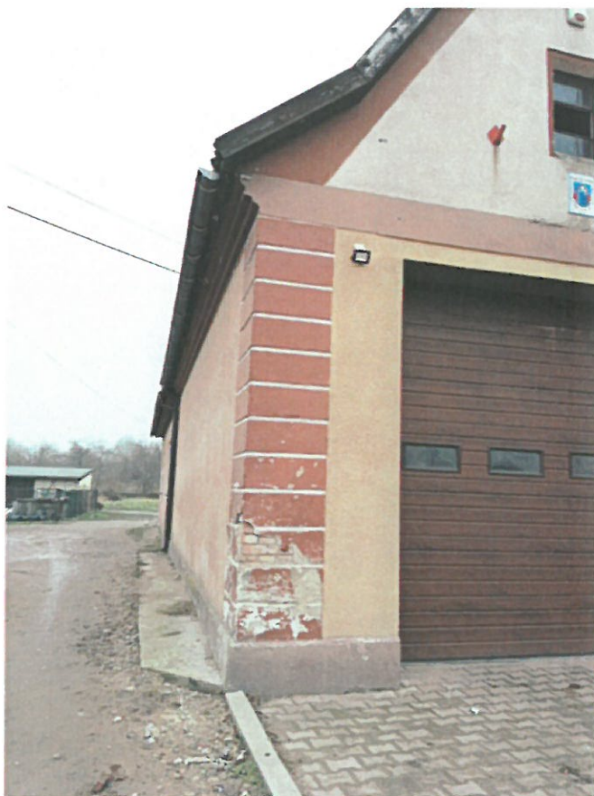
Fot. 5. Ozdobne boniowanie naroża- stan zachowania
