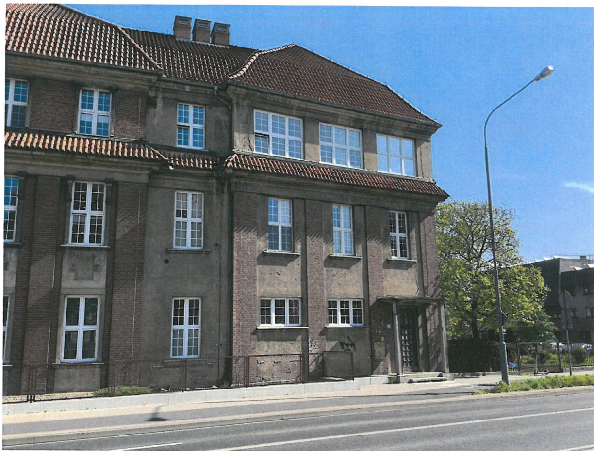
Ilustracja 5: Widok ogólny od ul. Bukowskiej
