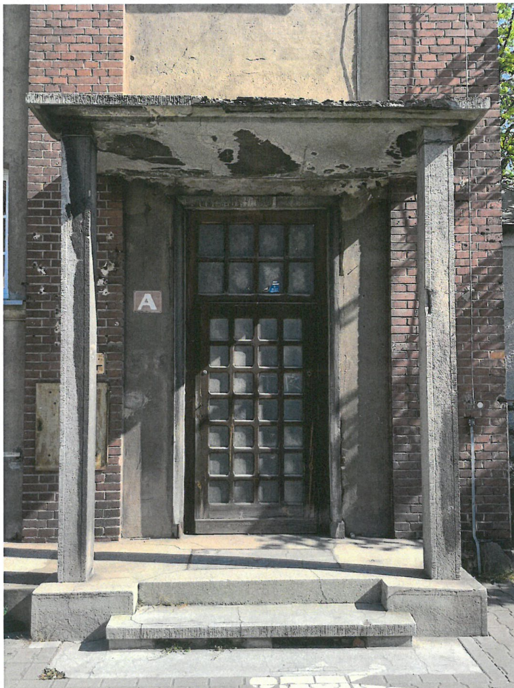
Ilustracja 1: Widok na zadaszenie wejścia od ul. Bukowskiej
