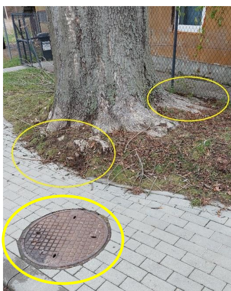
Fot. 06 - strefy naruszenia systemu korzeniowego
