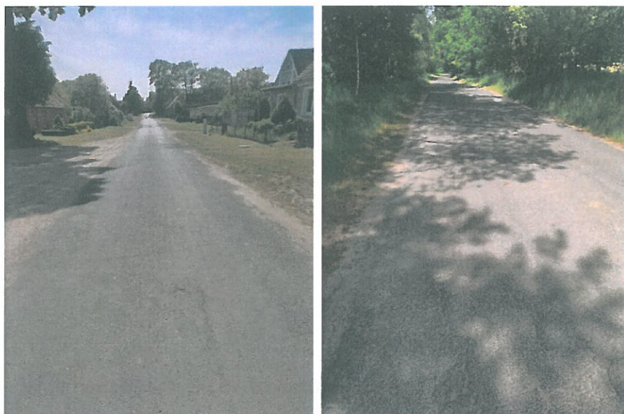
Fotografia nr 1 Istniejąca nawierzchnia
