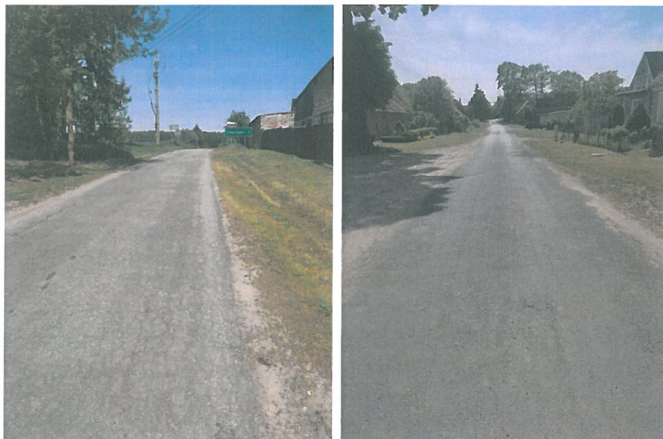
Fotografia nr 3 Trzeci odcinek
