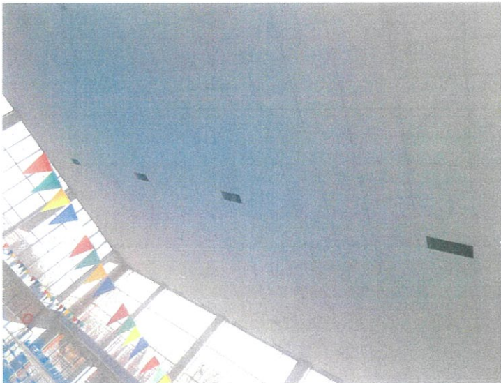
Fot. nr 2 – kratki wentylacyjne o wymiarach 1000 x 400 mm zlokalizowane nad niecką basenową
