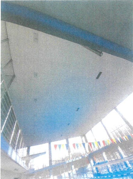
Fot. nr 1 – kratki wentylacyjne o wymiarach 1000 x 400 mm zlokalizowane nad niecką basenową
