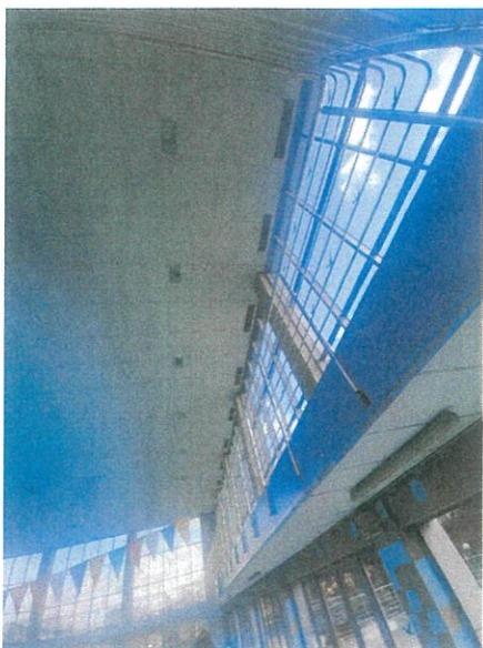
Fot. nr 3 – kratki wentylacyjne o wymiarach 1000 x 200 mm (10 szt.) zlokalizowane nad antresolą
