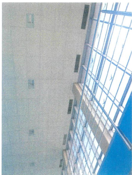
Fot. nr 4 – kratki wentylacyjne o wymiarach 1000 x 200 mm (10 szt.) zlokalizowane nad antresolą
