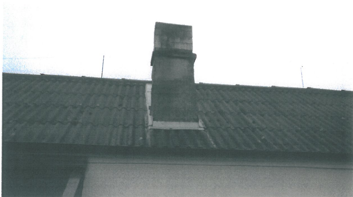
Zdj. Nr 3 Dach budynku świetlicy wiejskiej. Widoczne pokrycie oraz część komina z opierzeniem z blachy ocynkowanej.
