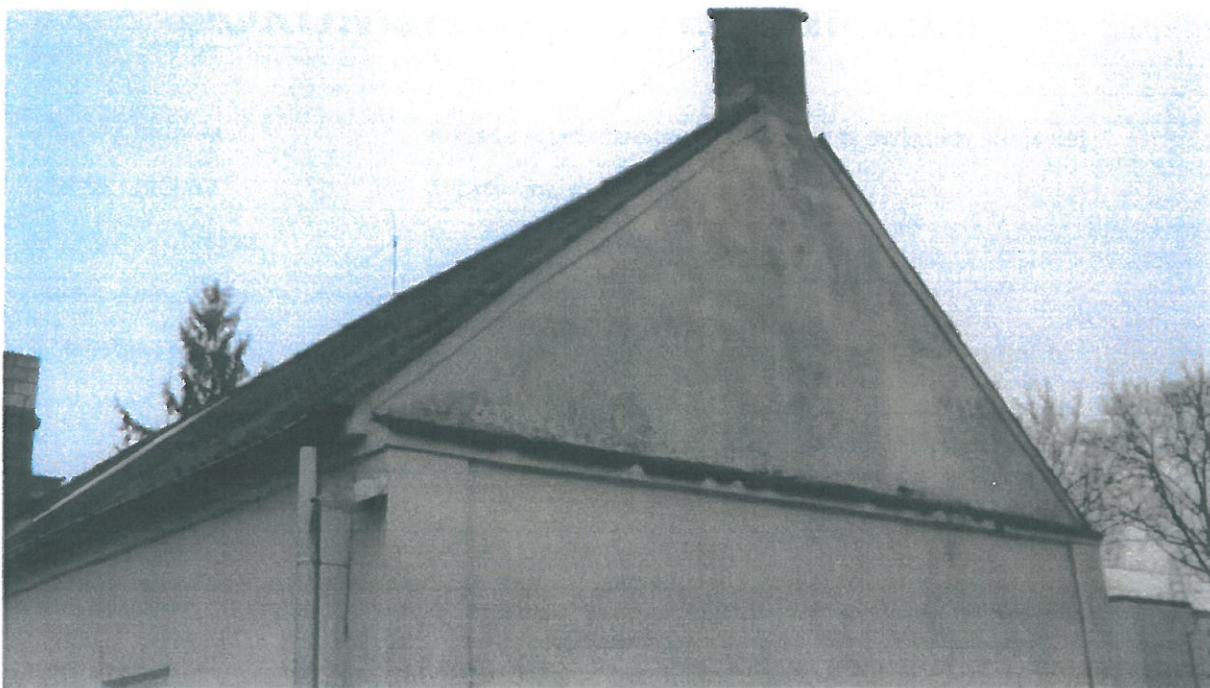
Zdj. Nr 4. Szczyt północno zachodni. Rynny i rury spustowe wymienione na nowe. U góry widoczna instalacja odgromowa budynku.
