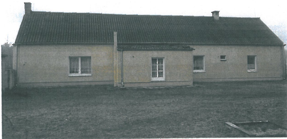
Zdj. Nr 2 Elewacja budynku od strony południowo – zachodniej. Widoczne pokrycie dachu płytami azbestowo – cementowymi
