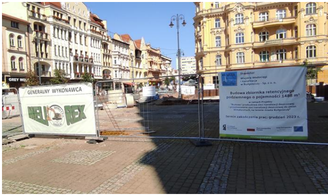
Fotografia 1. Prace prowadzone na Placu Wolności stan na dzień 08.09.2023 r.
