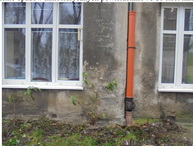
Foto. nr 5. Widok ogólny nieuszczelnej rury spustowej.
