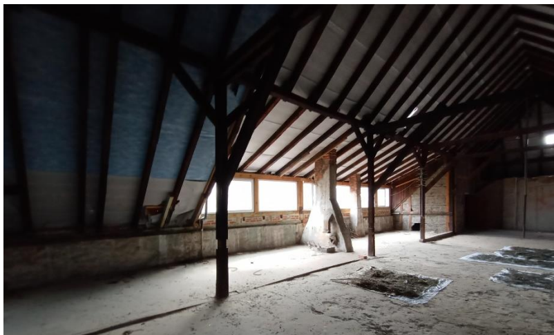
Fot. 1 Południowa część dachu
