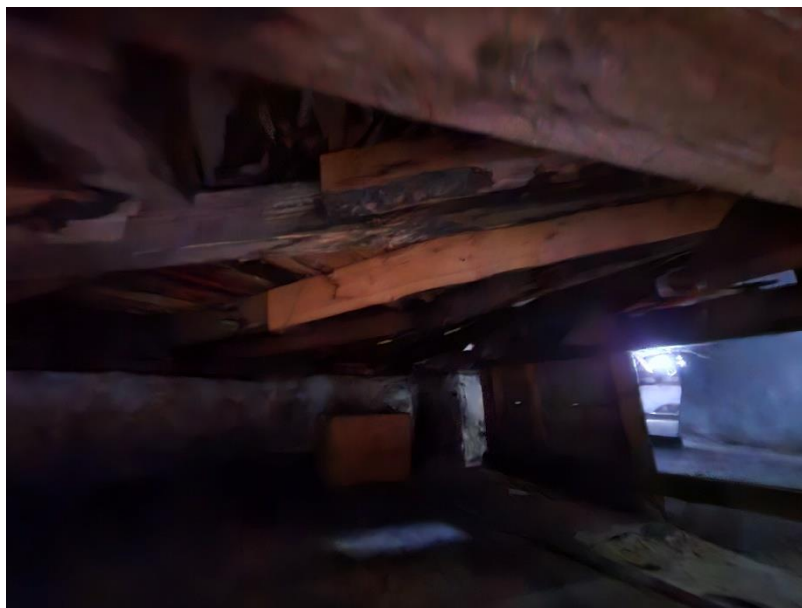
Fot. 3 Więżba dachowa narożnej części dachu, pokrycie papą
