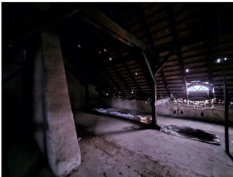
Fot. 4 Okno we wschodniej części dachu
