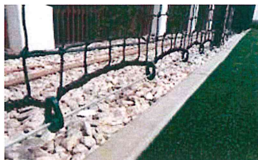
Przykładowy montaż siatki na linkach naciągowych - na zaczepach
