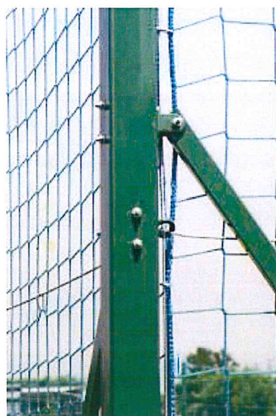
Przykładowy montaż stężenia oraz linki na skrajnych słupach
