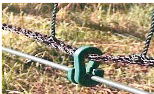
Przykładowy montaż siatki na linkach naciągowych - na zaczepach
