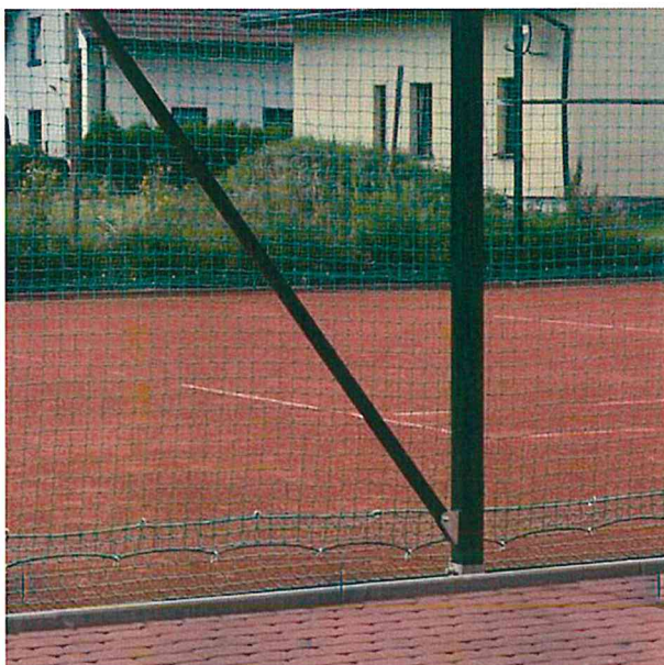
Przykładowy montaż stężenia oraz linki na skrajnych słupach
