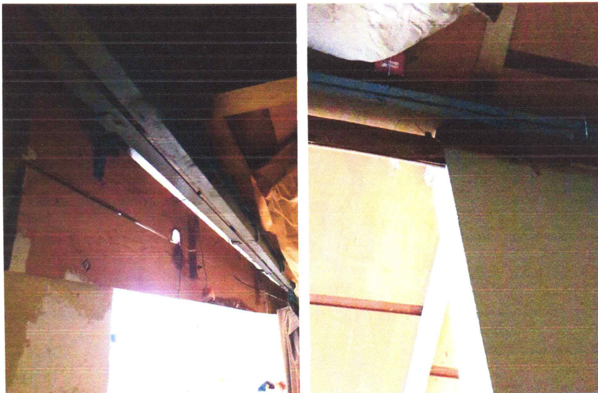
Zdjęcie 6,7 Aula – widok na deskę czołową sceny oraz na szynę jezdnią kotary sceny
