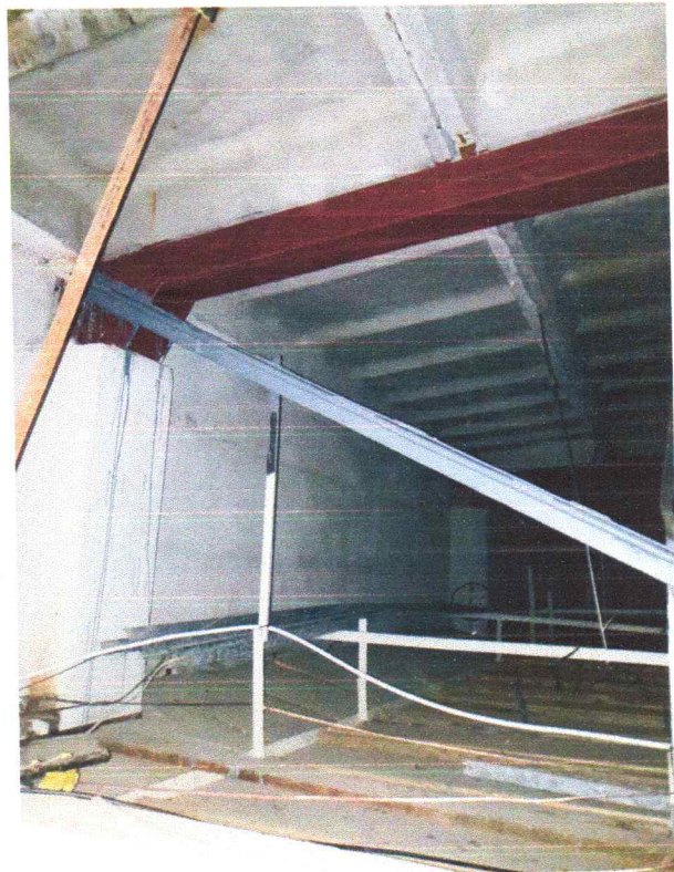
Zdjęcie 3 Aula – widok na sufit podwieszany z płyt wiórowych w okleinie naturalnej łączonych na pióro oraz stelaż z teownika T80 w rozstawie ok 1,4m.
