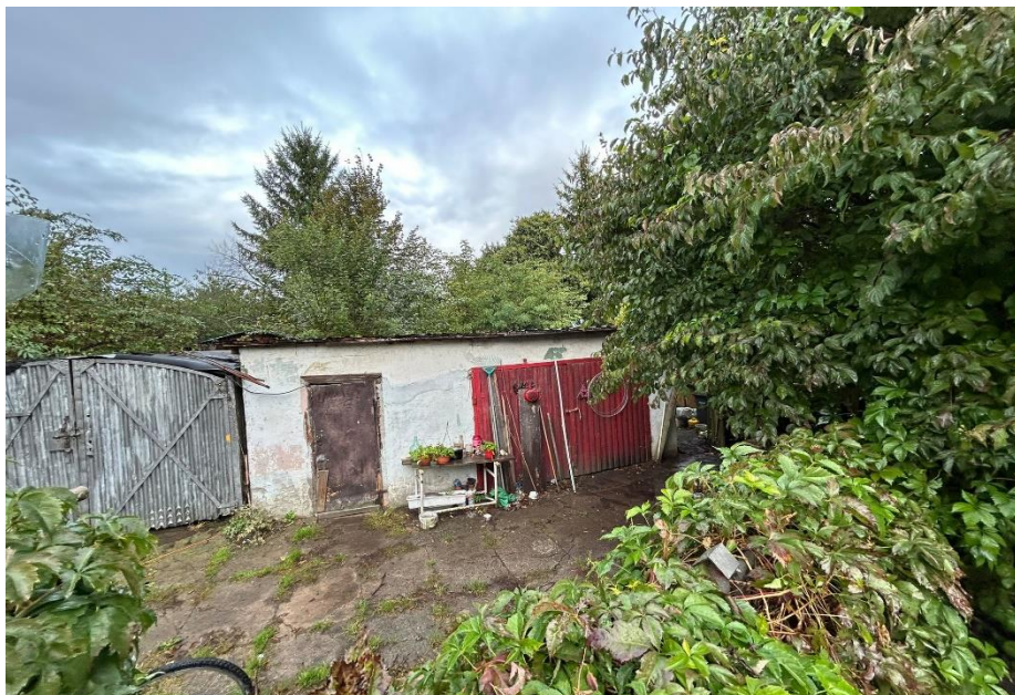
Rys. 1. Budynek gospodarczy przeznaczony do rozbiórki
