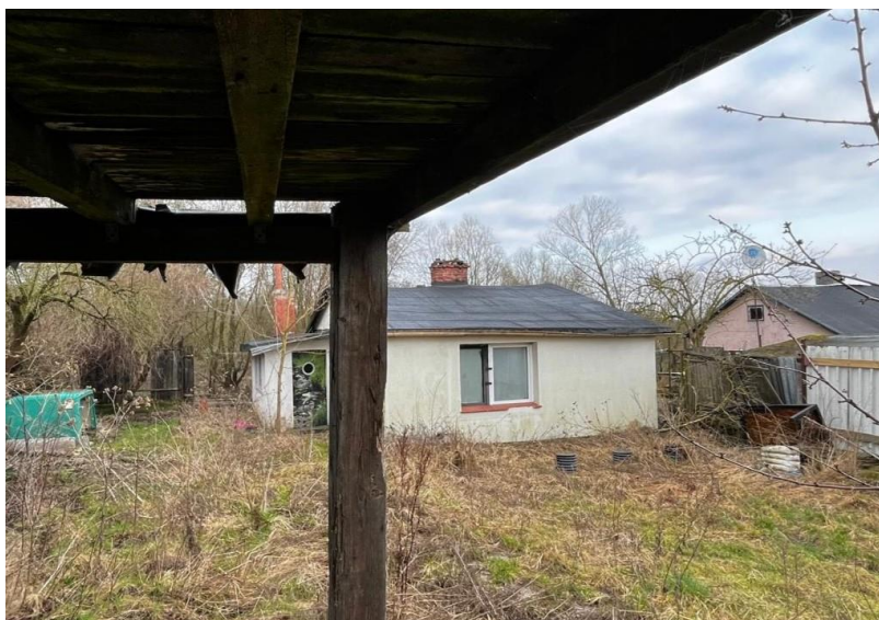
Rys. 2. Altanka nr 1 przeznaczona do rozbiórki
