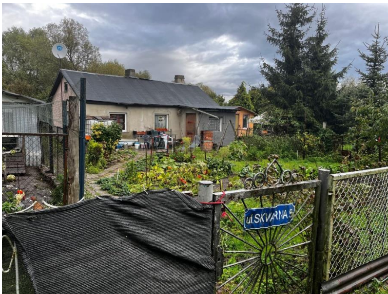
Rys. 3. Altanka nr 2 przeznaczona do rozbiórki
