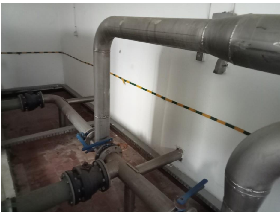
Rys. nr 2 Widok przyłącza rurowego.
