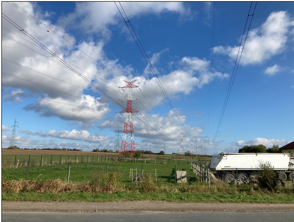
Rycina 3 Linie elektroenergetyczne na skraju miejscowości Szewce, przecinające teren inwestycji (fot. M. Roszyk)
