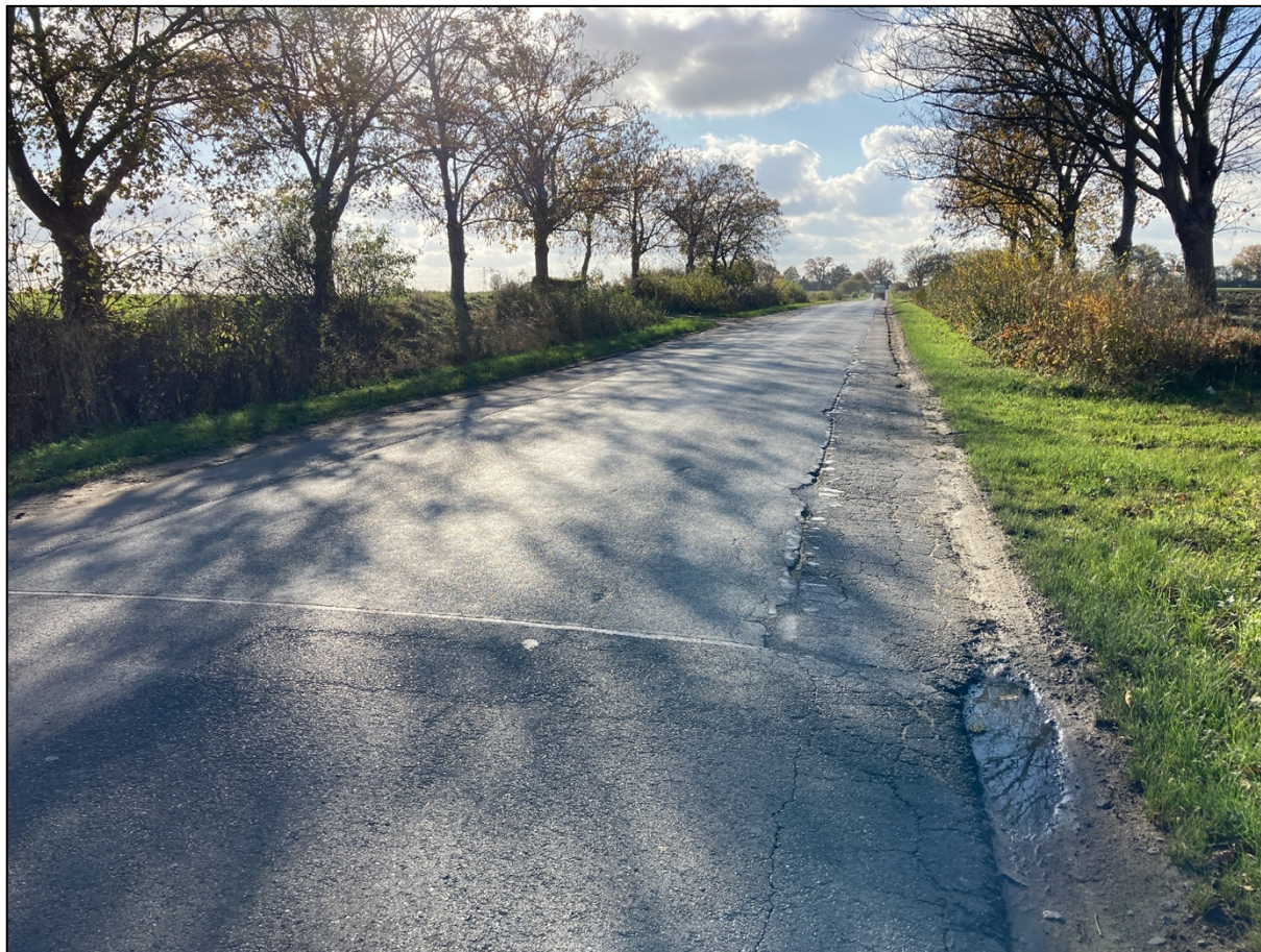
Rycina 6 Koniec odcinka nr 2 przed miejscowością Strzeszów (fot. M. Roszyk)
