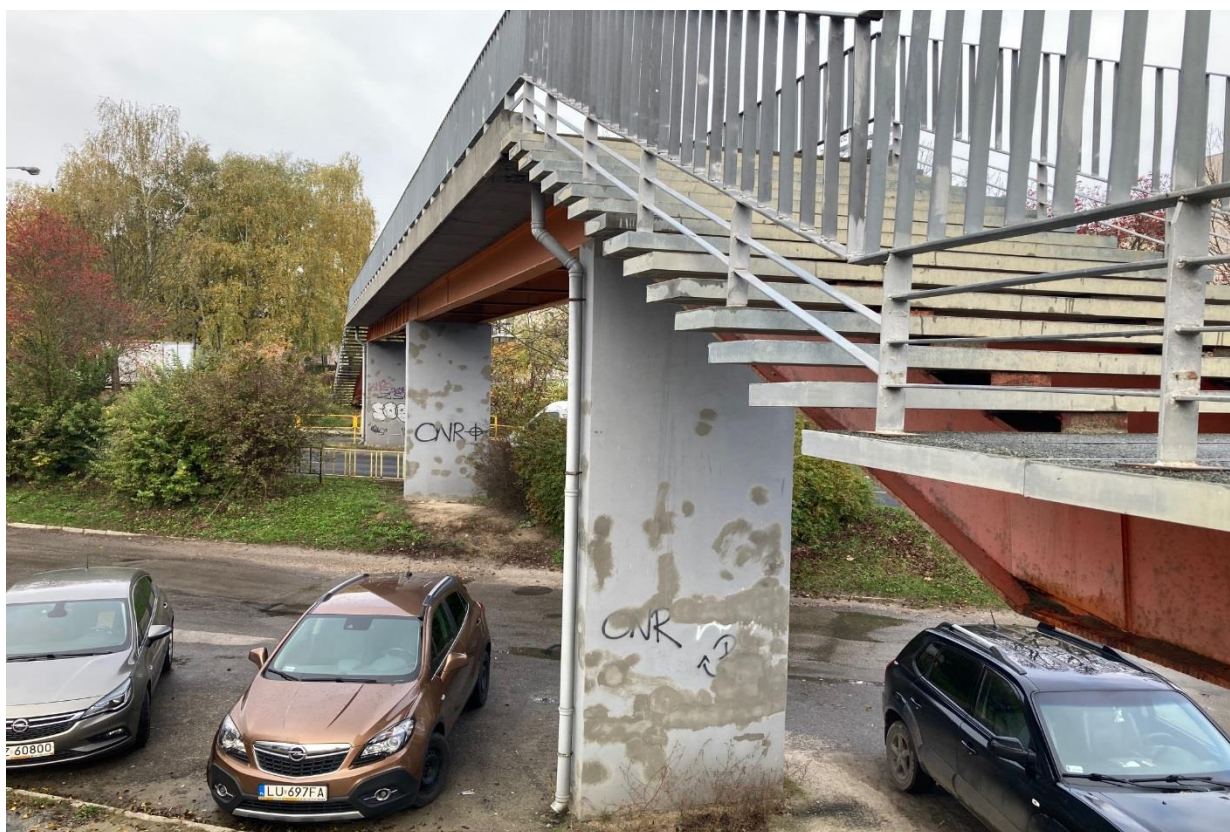
Fot. 15 Widok schodów od strony wschodniej
