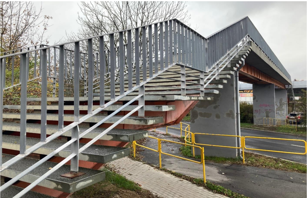
Fot. 13 Schody od strony zachodniej
