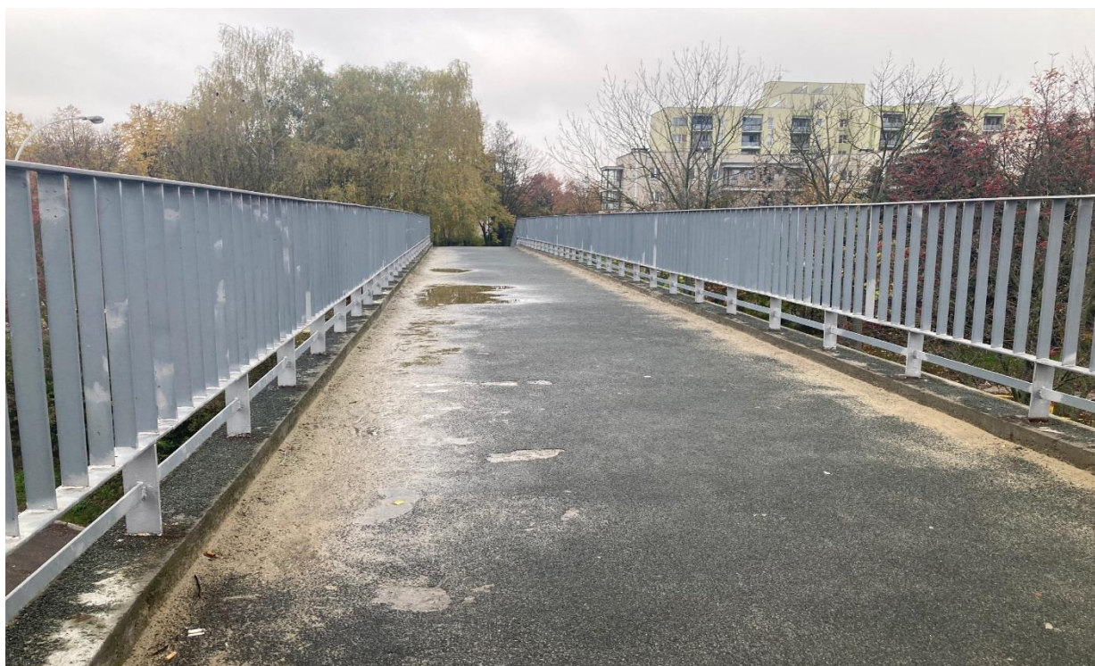
Fot. 16 Widok nawierzchni kładki
