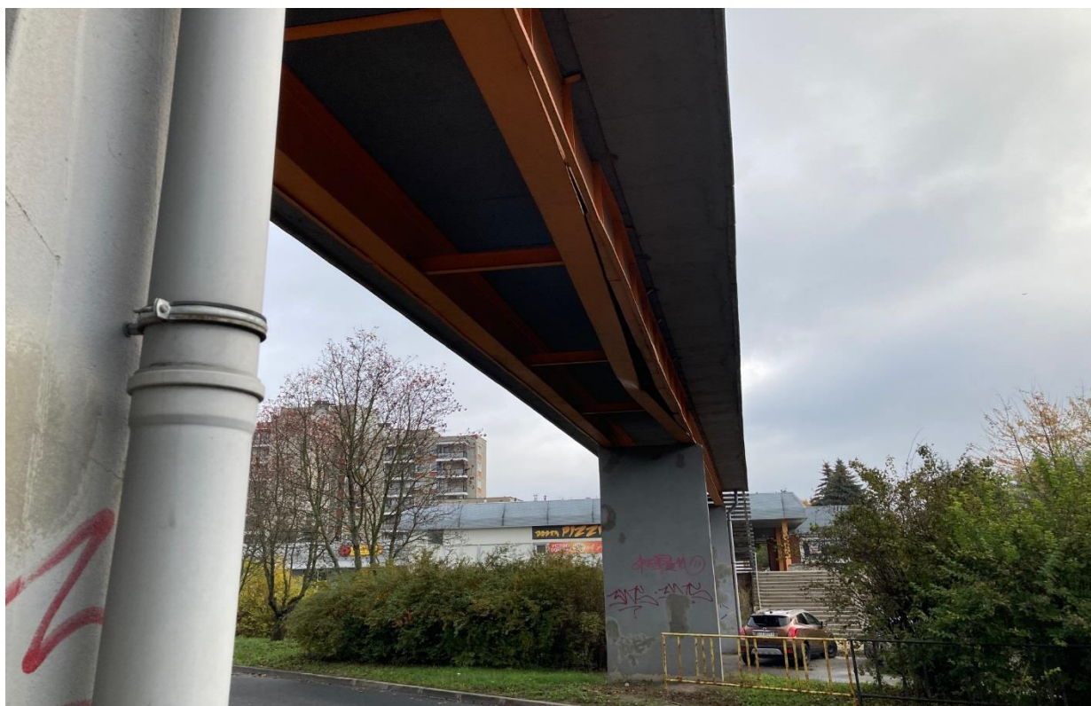
Fot. 10 Widok od spodu konstrukcji wzmacniającej
