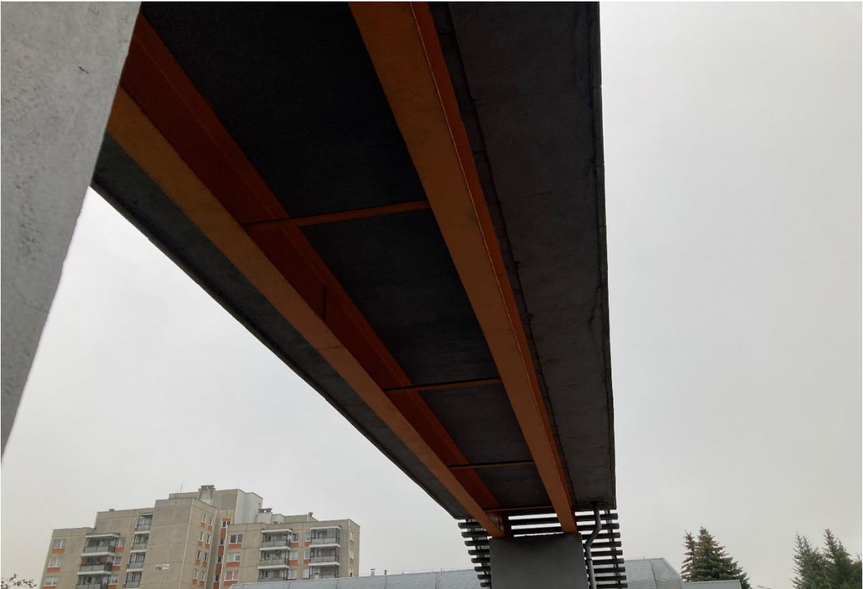
Fot. 18 Widok konstrukcji nośnej kładki przęsła nieuszkodzonego
