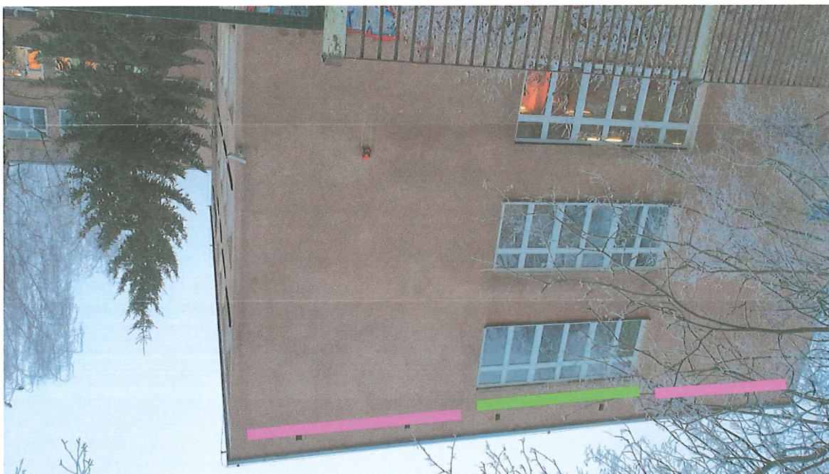
Fot. Nr 3. Elewacja budynku – wystawa wschodnia. Różowe linie wskazują planowane miejsca montażu budek dla jeryzków (10szt.), a linia zielona 3 budki dla wróbli. Widoczne siedem niezabezpieczonych wlotów do stropodachów.
