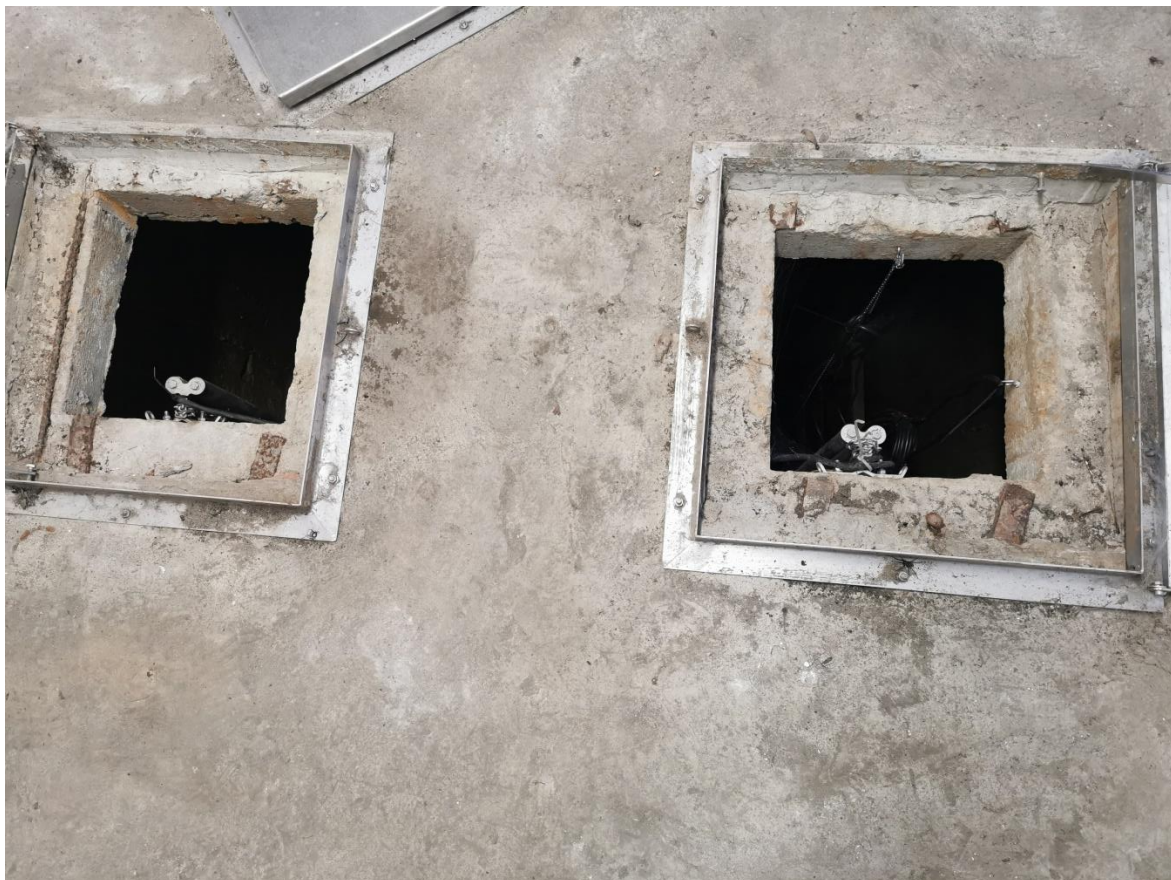
Rysunek 4. Włazy rewizyjne stan istniejący
