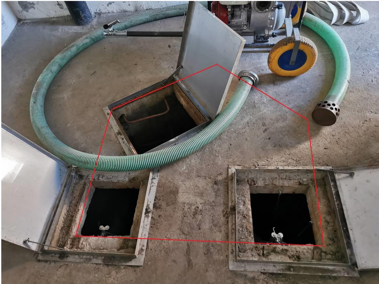
Rysunek 5. Sugerowany obszar powiększania włazów rewizyjnych
