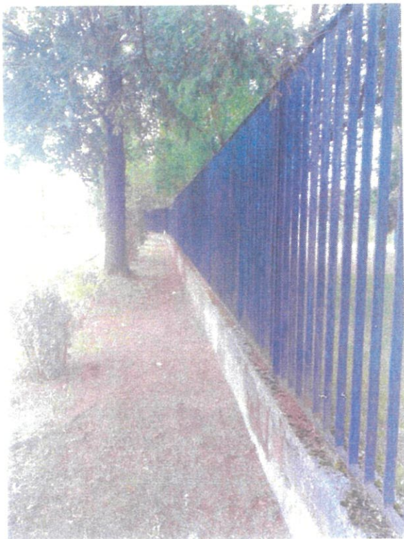
fot. 8 – ogrodzenie istniejące ul. Zegrzyńska
