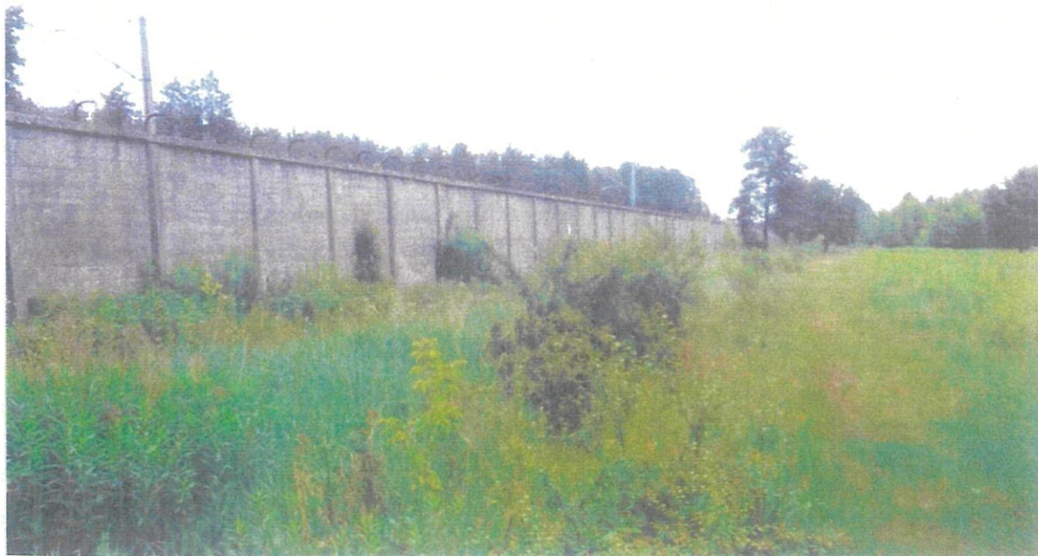
fot. 3 – ogrodzenie istniejące od strony torów
