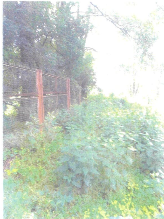
fot. 2 – ogrodzenie istniejące od strony kanału Bródnowskiego
