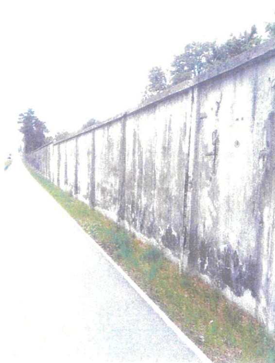
fot. 1 – ogrodzenie istniejące ul. Zegrzyńska
