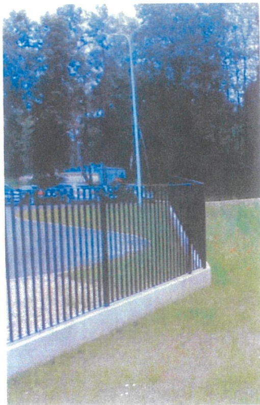
fot. 9 – ogrodzenie istniejące ul. Zegrzyńska
