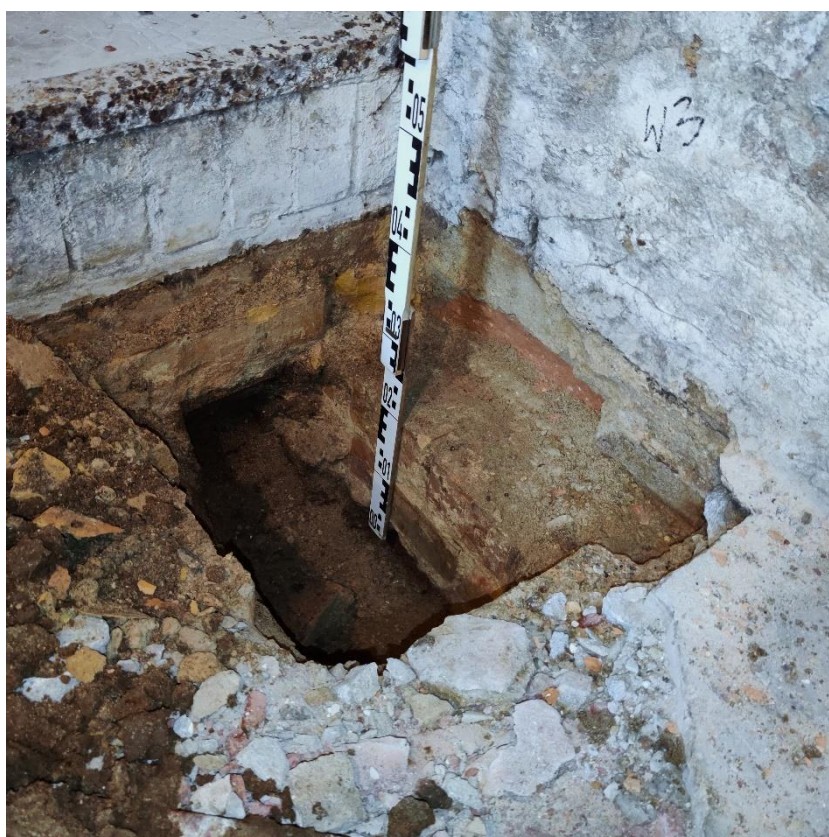
Fot. 14 Odkrywka nr 2 – fundament.
