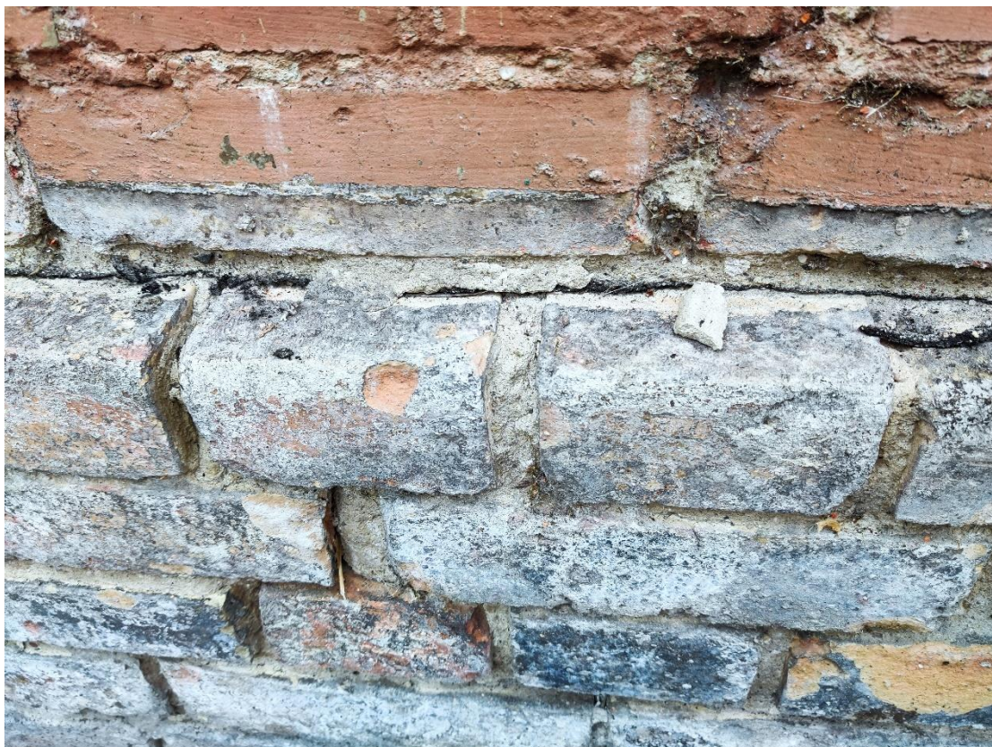
Fot. 19 Izolacja przeciwwilgociowa (papa asfaltowa w poziomie 0).
