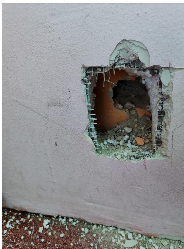
Fot. 20 Odkrywka nr 7 - wewnętrzne docieplenie dachu mansardowego.
