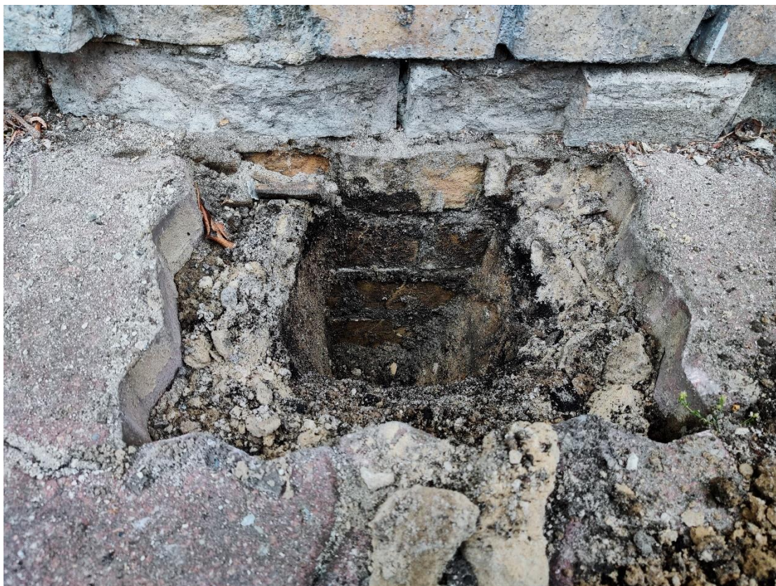
Fot. 17 Odkrywka nr 5 – ściana fundamentowa.
