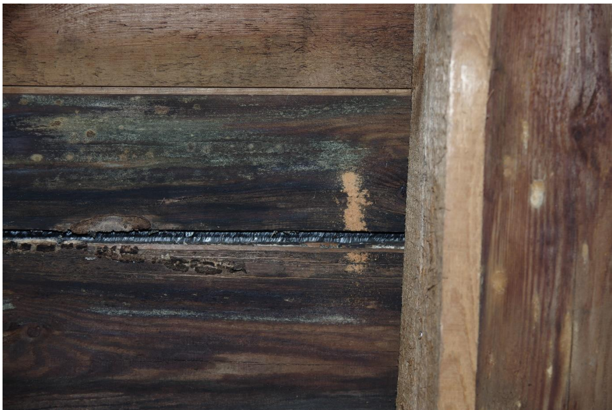
Fot. 27 Rozwój grzyba – widoczna grzybnia i owocnik na dolnej powierzchni deskowania.
