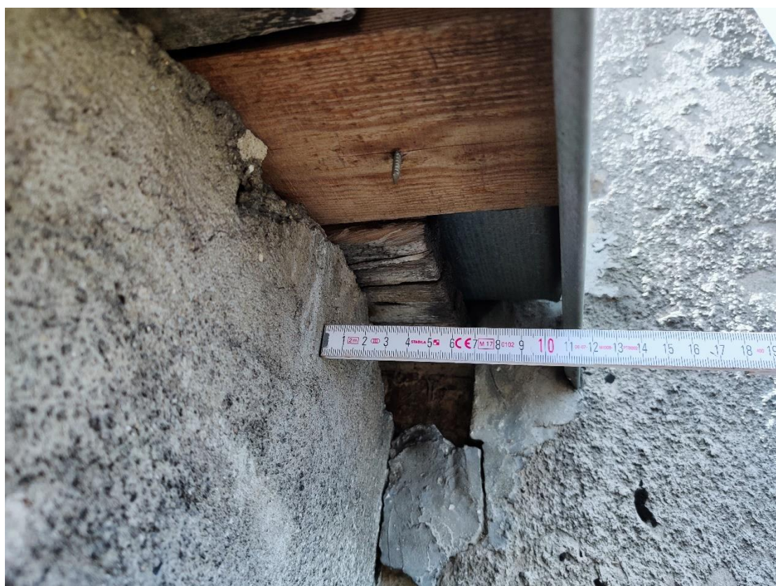
Fot. 26 Krawędź płaskiej połaci dachu mansardowego.
