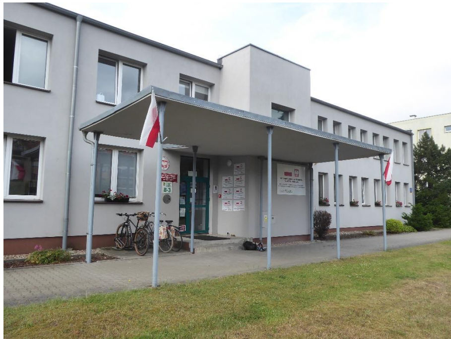
Fot. 1. Zadaszenie od strony północnej przy budynku Dolnośląskiego Ośrodka Doradztwa Rolniczego przy ul. Zwycięskiej 89 we Wrocławiu
