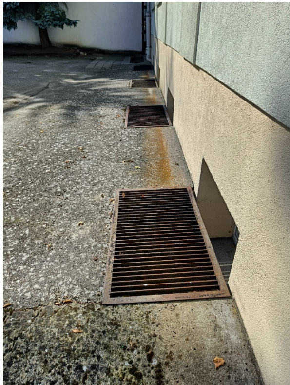
Fot. 1 kraty zabezpieczające przed oknami do wymiany lub odrestaurowania
