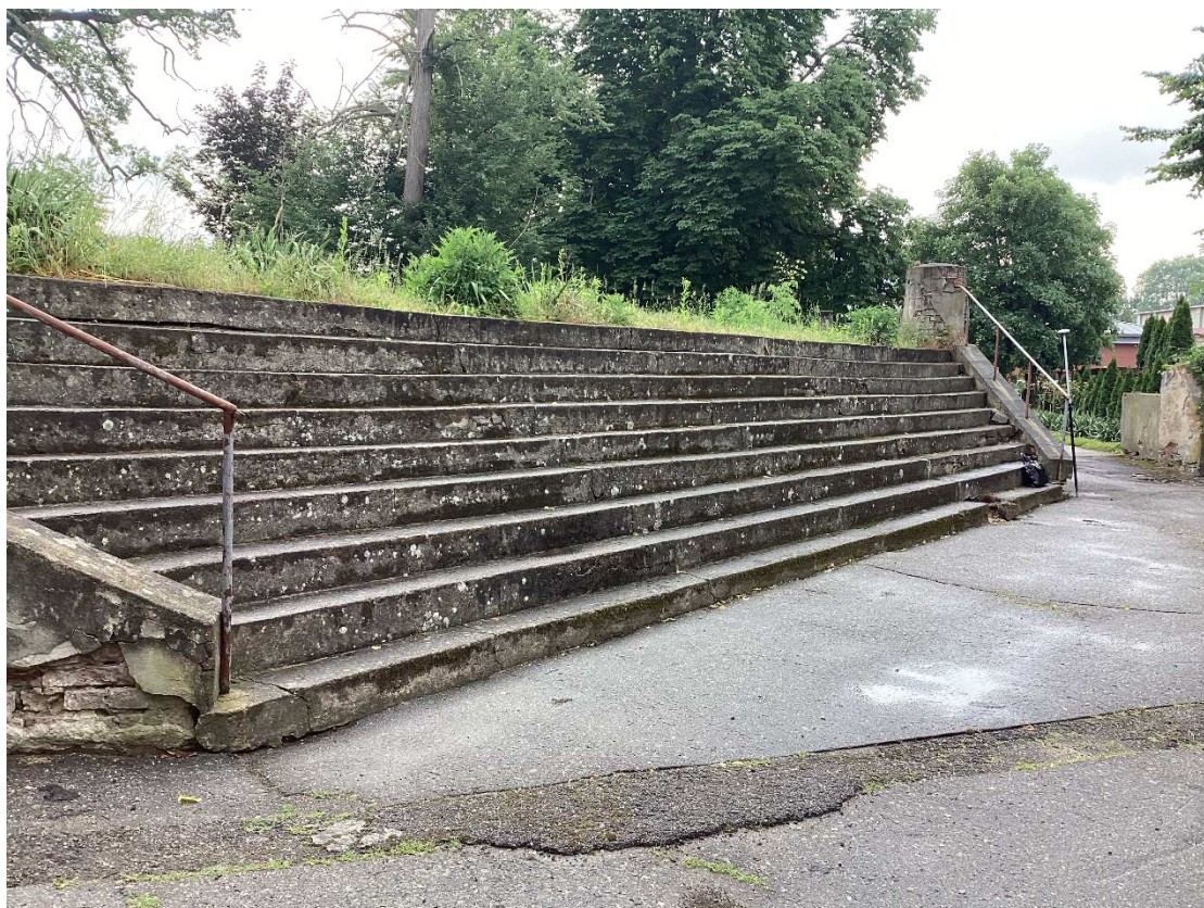
Fot. 7 renowacja muru oporowego
