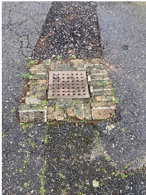
Fot. 4 kratka do wymiany
