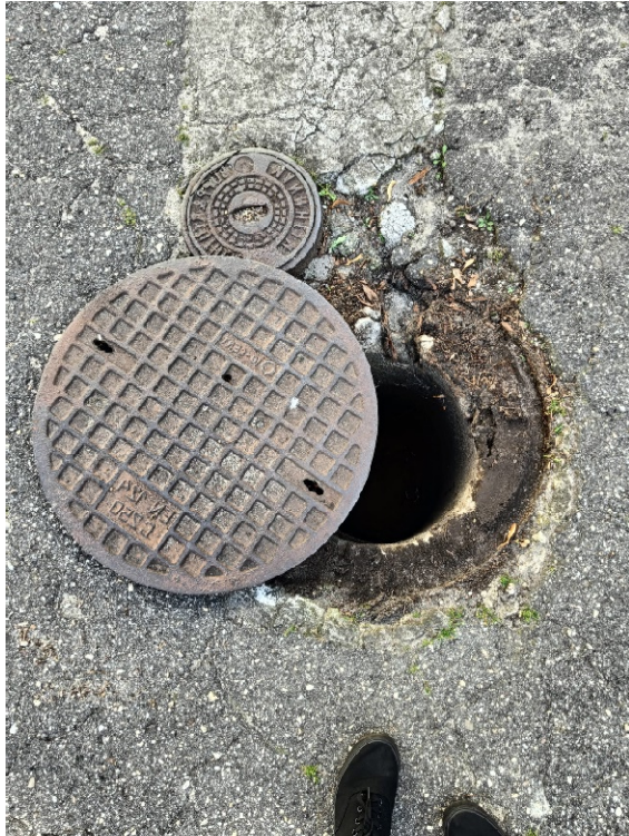
Fot. 3 wyłaz do wymiany
