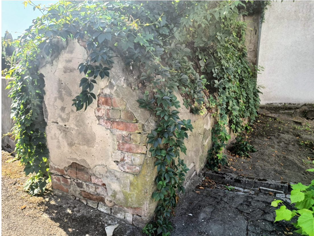
Fot. 9 renowacja murów
