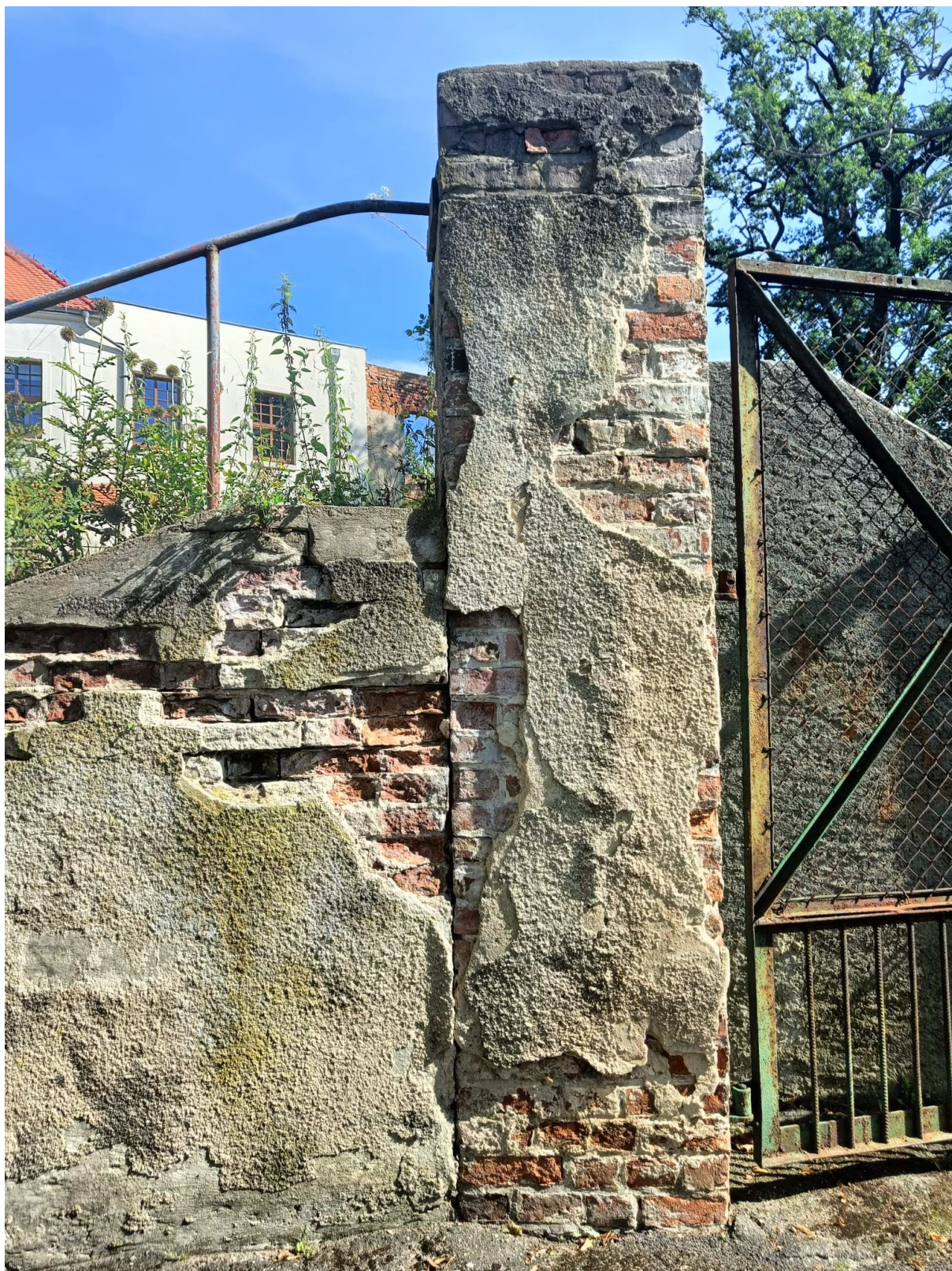
Fot. 8 renowacja słupa
