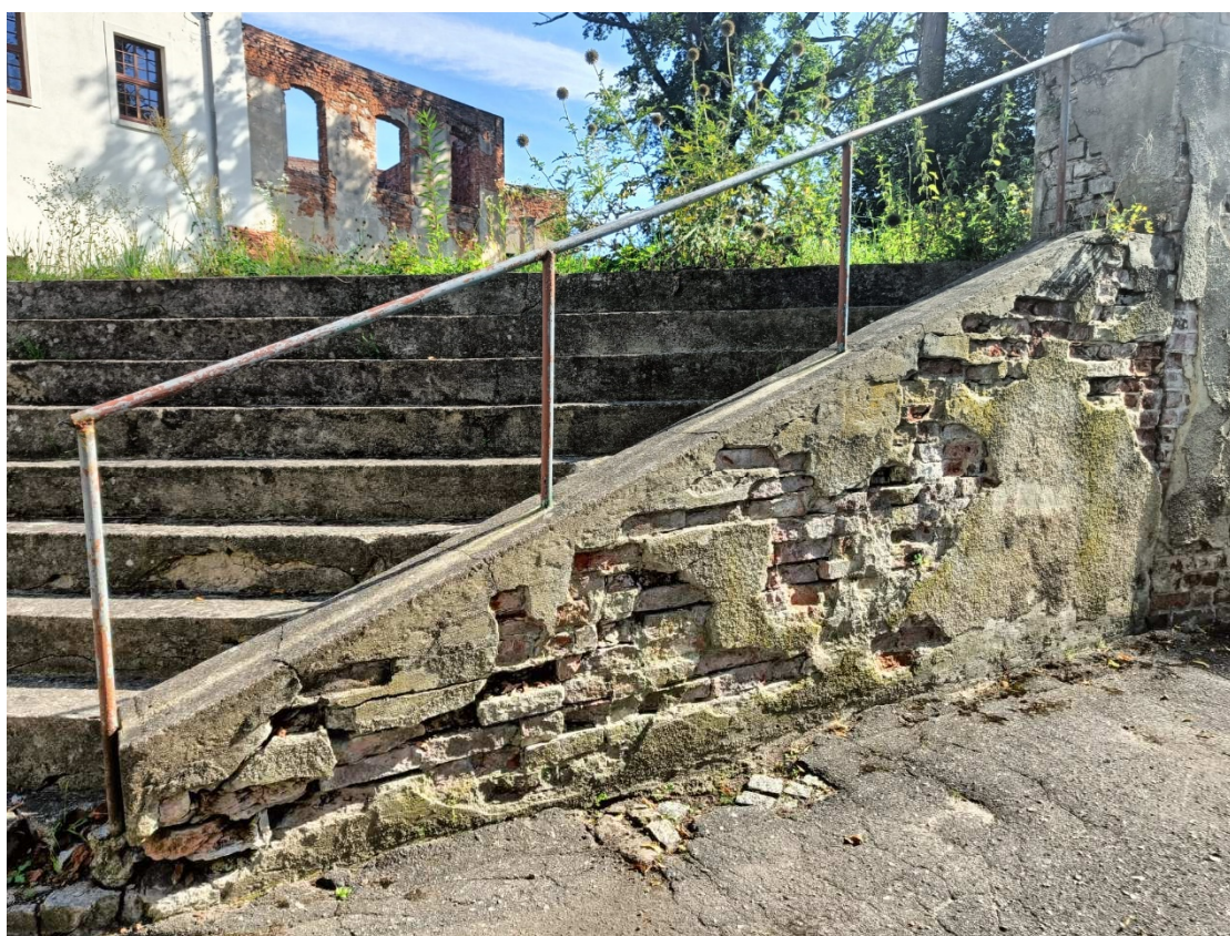
Fot. 7 renowacja muru oporowego
