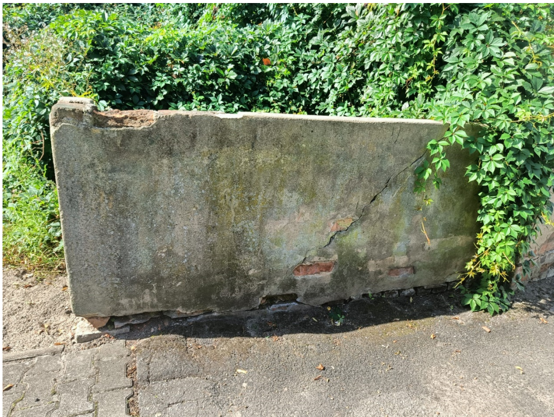
Fot. 9 renowacja murów
