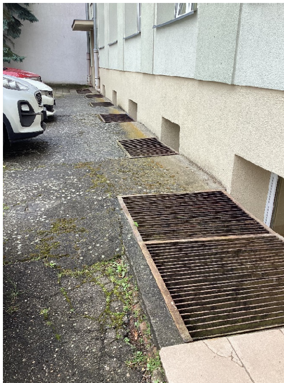
Fot. 1 kraty zabezpieczające przed oknami do wymiany lub odrestaurowania
