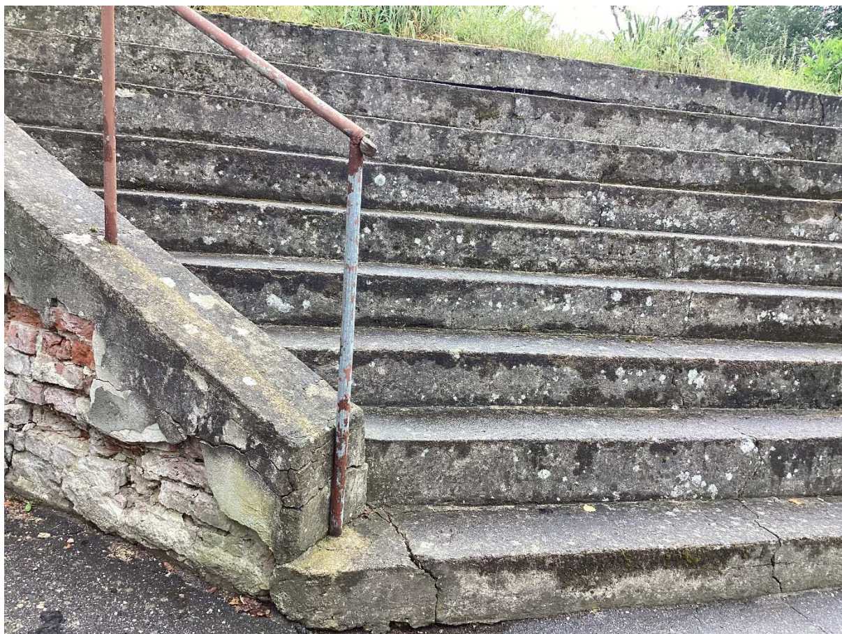
Fot. 7 renowacja muru oporowego
