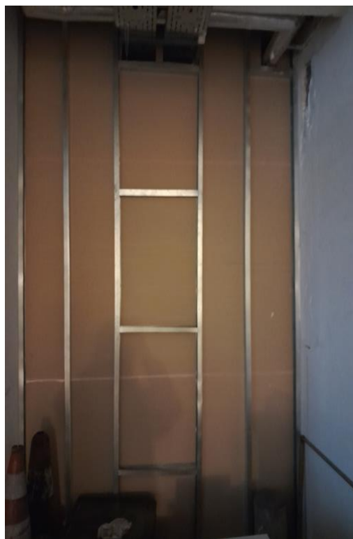
Zdjęcie 7. Ścianka działowa korytarz - parter
