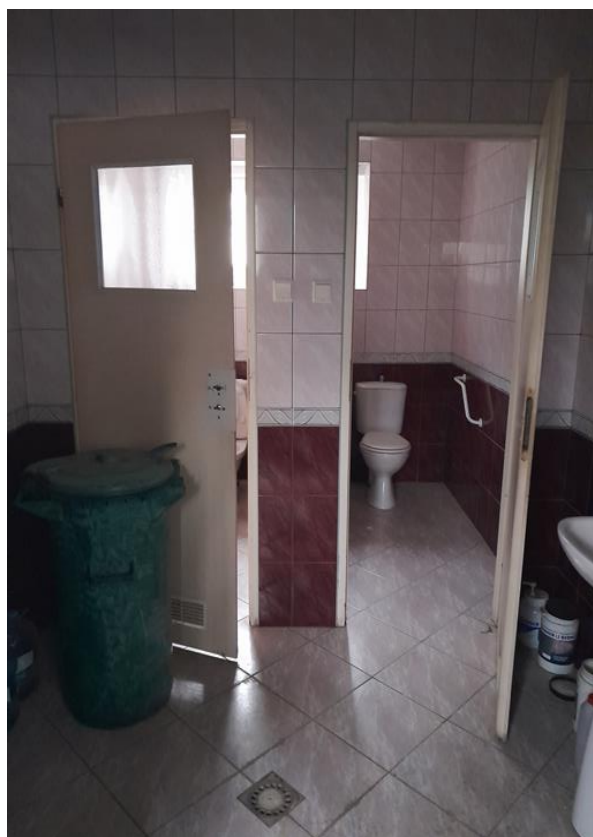
Zdjęcie 10. Widok pomieszczenia higieniczno – sanitarnego - parter
