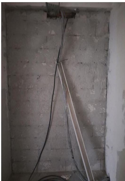
Zdjęcie 6. Ścianka działowa korytarz - 1 piętro
