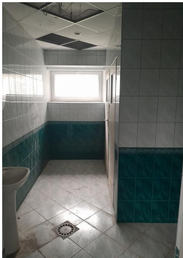
Zdjęcie .9 Widok pomieszczenia higieniczno – sanitarnego – - parter
