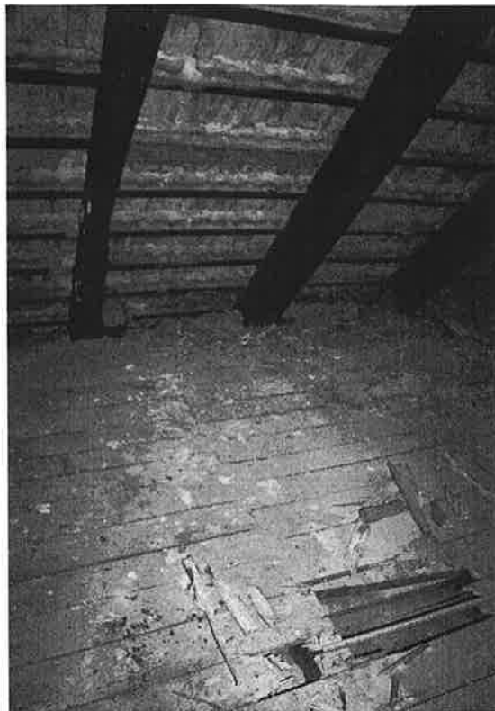
Fot.10 – Strop nad dolną kondygnacją poddasza ( nad IIp. ); odkrywka w rejonie krokwi nr 5
