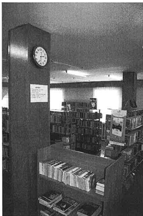
Fot. 01 - Strop nad I p.; widoczne dwa filary wspierające strop bez widocznego podciagu;
