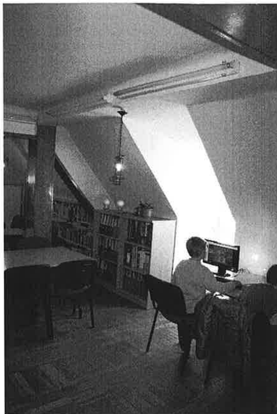
Fot.04 – Strop nad dolną kondygnacją poddasza ( nad IIp. ); widok na pd.-zach.
