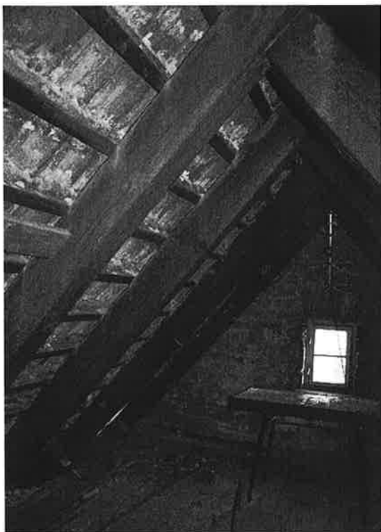
Fot. 13 – Górna kondygnacja poddasza ( IIIp.); widoczne krokwie 1E-4E;
