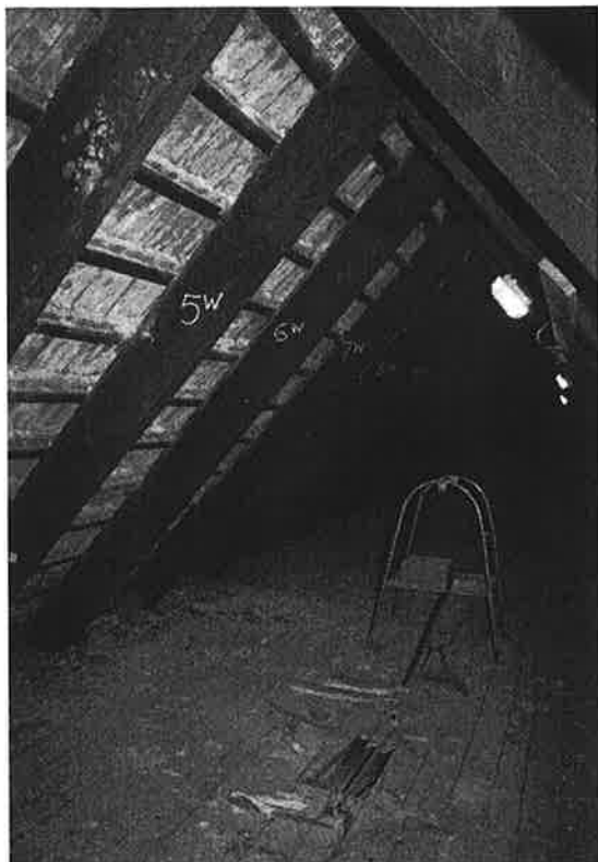
Fot. 09 - Strop nad dolną kondygnacją poddasza ( nad IIp. ); odkrywka w rejonie krokwi nr 5
