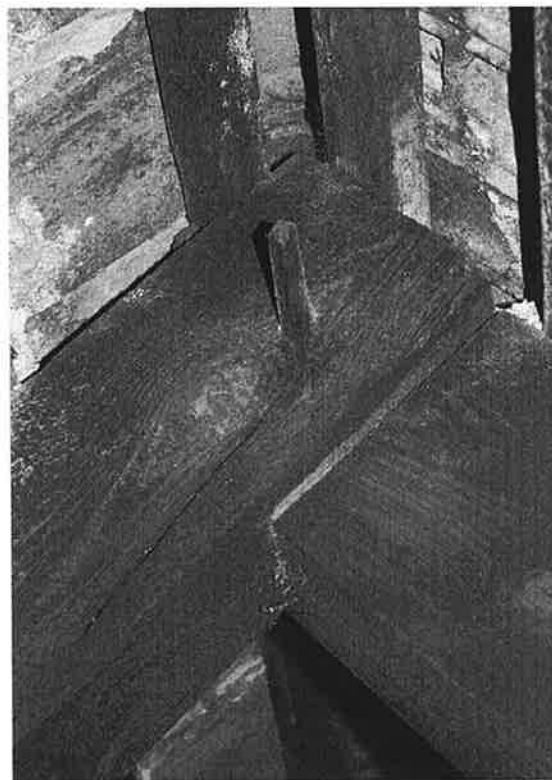
Fot.16 – Górna kondygnacja poddasza ( IIIp.); widoczne połączenie krokwi 7E i 7W;
