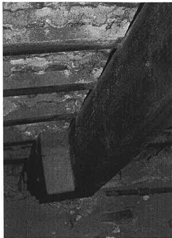
Fot.14 – Górna kondygnacja poddasza ( IIIp.); widoczne połączenie dolnej i górnej krokwi 5E;
