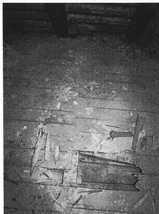
Fot. 11 - Strop nad dolną kondygnacją poddasza ( nad IIp. ); odkrywka w rejonie krokwi nr 5
