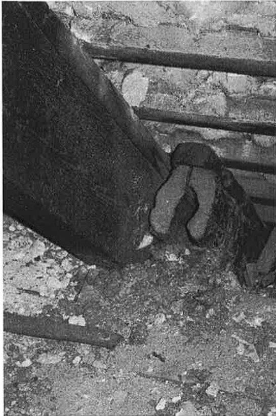
Fot. 17 – Górna kondygnacja poddasza ( IIIp.); połączenie dolnej ( opalonej ) i górnej krokwi 3;
