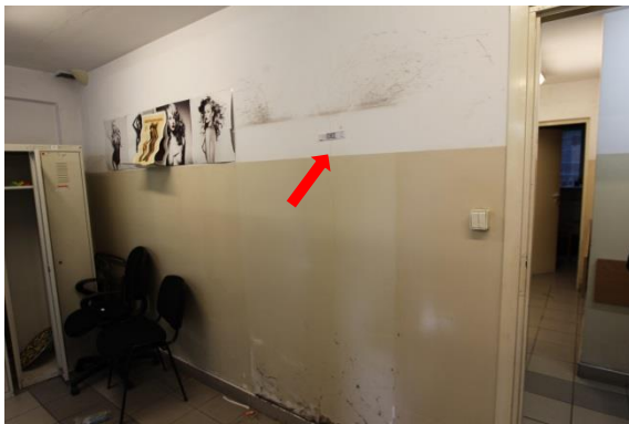
Szczelinomierz S18 – piwnica
