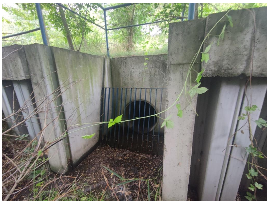
Fot.16. Komora wlotowa przepustu w km 1+175.
