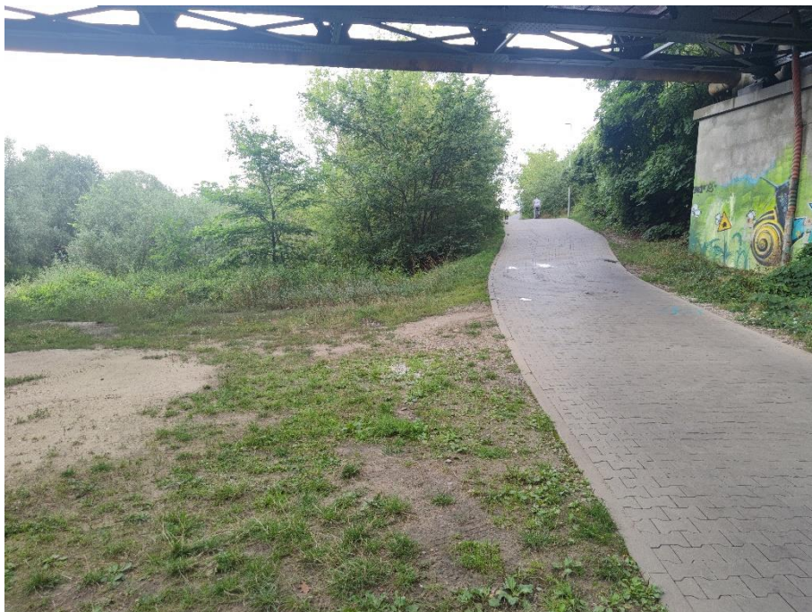
Fot.1. Widok na wał w km 1+610
