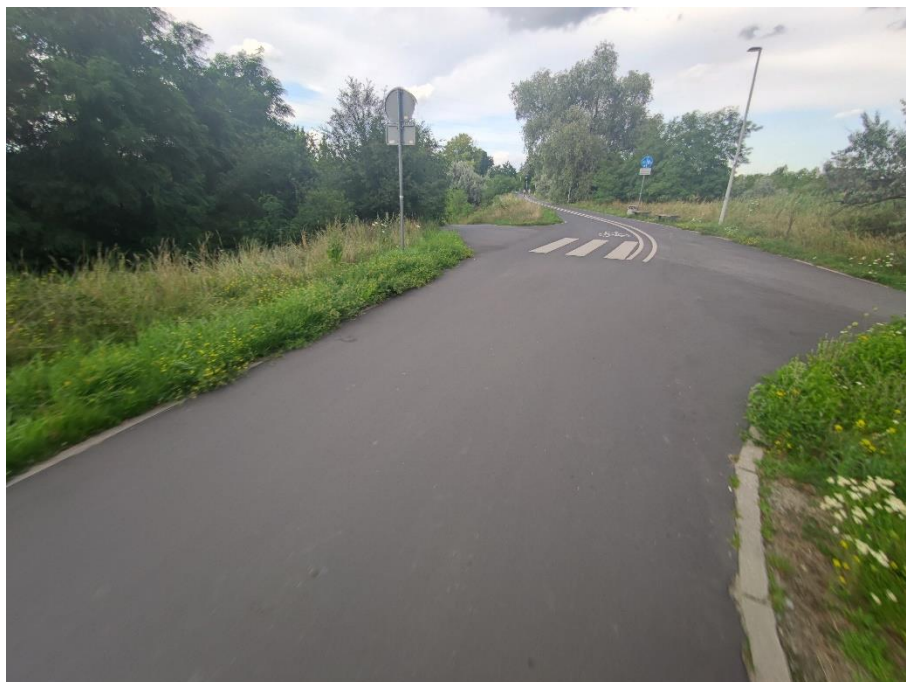
Fot.7. Widok na przejazd przez wał w km 1+290. Widoczne krzewy i drzewa na skarpach wału.
