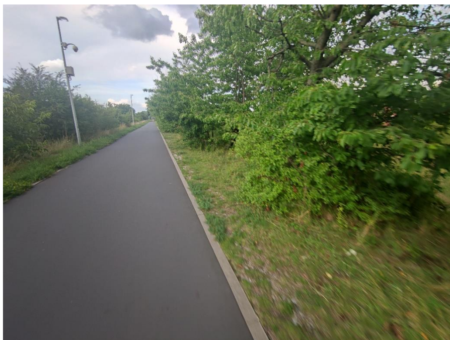
Fot.4. Widok na wał w km 1+550. Widoczne krzewy i drzewa na skarpach wału.
