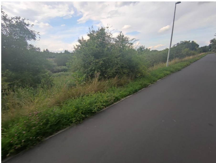
Fot.5. Widok na wał w km 1+450. Widoczne krzewy i drzewa na skarpach wału.
