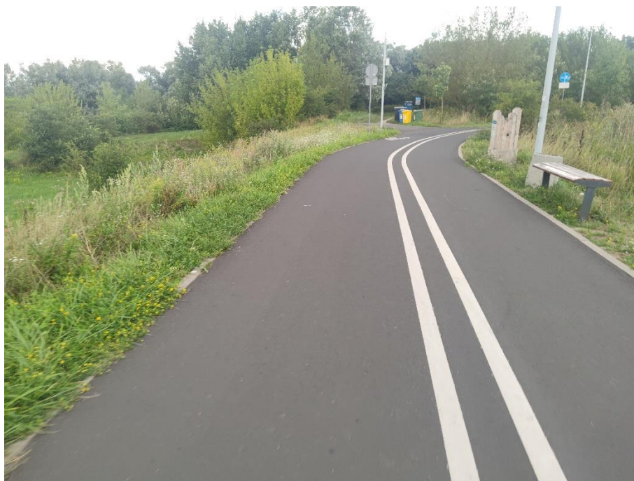
Fot.20. Widok na wał w km 0+150. Widoczne krzewy i drzewa na skarpach wału
