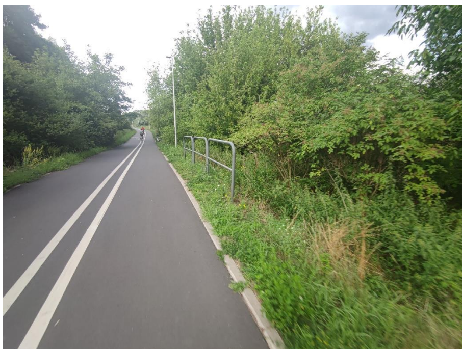
Fot.8. Widok na wał w km 1+250. Widoczne krzewy i drzewa na skarpach wału
