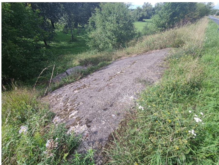
Fot.12. Wylot rurociągu w km 0+615.
