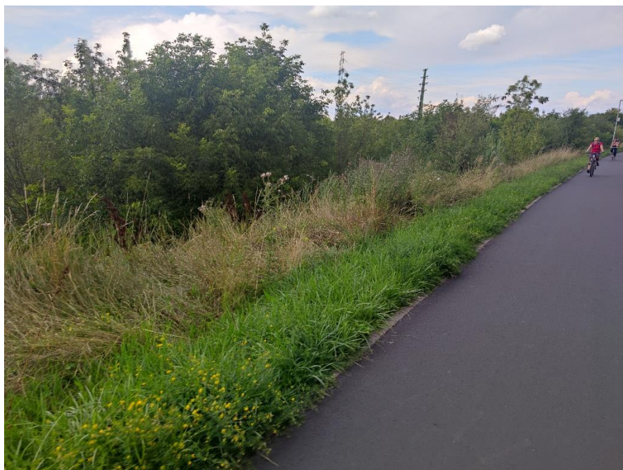
Fot.3. Widok na wał w km 1+600. Widoczne krzewy i drzewa na skarpach wału.
