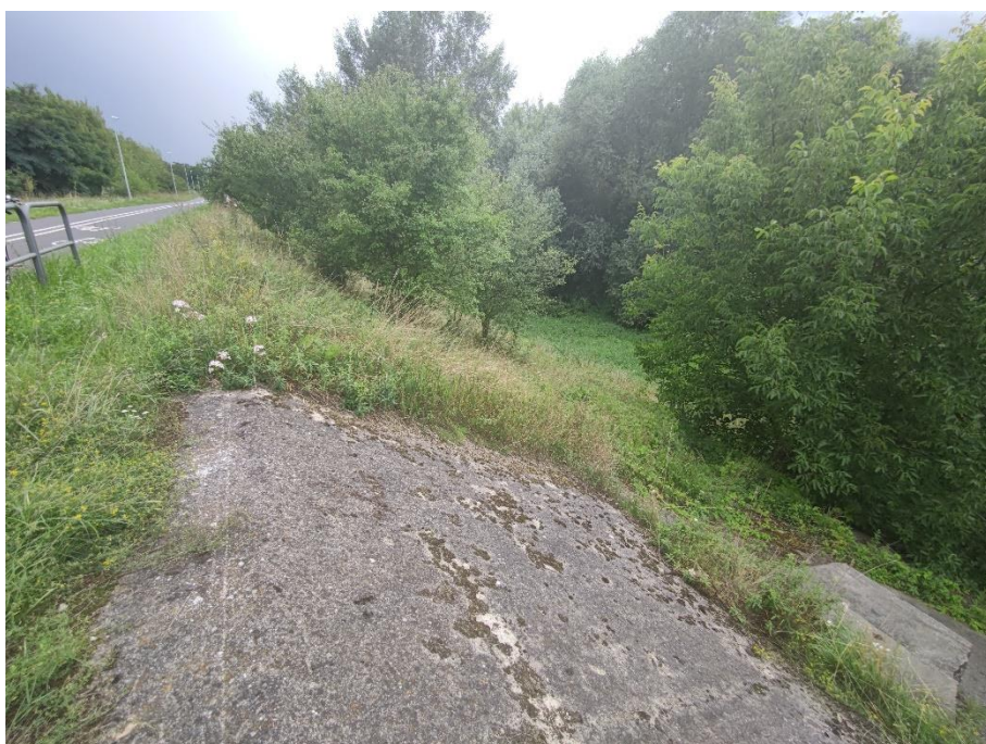
Fot.14. Wylot rurociągu w km 0+615.
