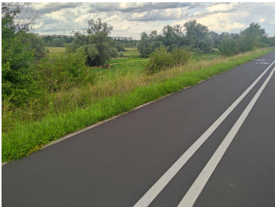
Fot.17. Widok na wał w km 0+550. Widoczne krzewy i drzewa na skarpach wału
