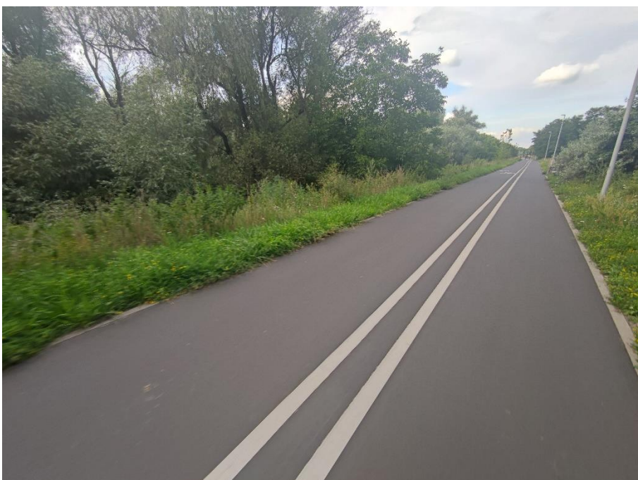
Fot.10. Widok na wał w km 1+150. Widoczne krzewy i drzewa na skarpach wału
