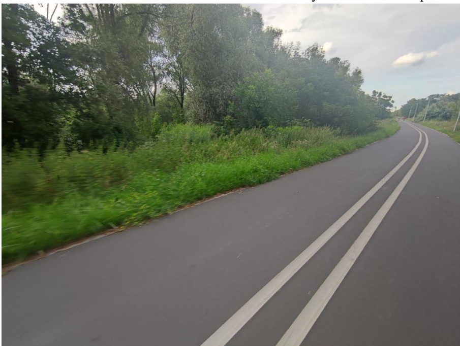
Fot.9. Widok na wał w km 1+200. Widoczne krzewy i drzewa na skarpach wału
