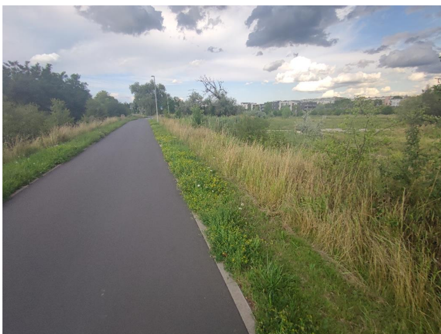
Fot.6. Widok na wał w km 1+400. Widoczne krzewy i drzewa na skarpach wału.
