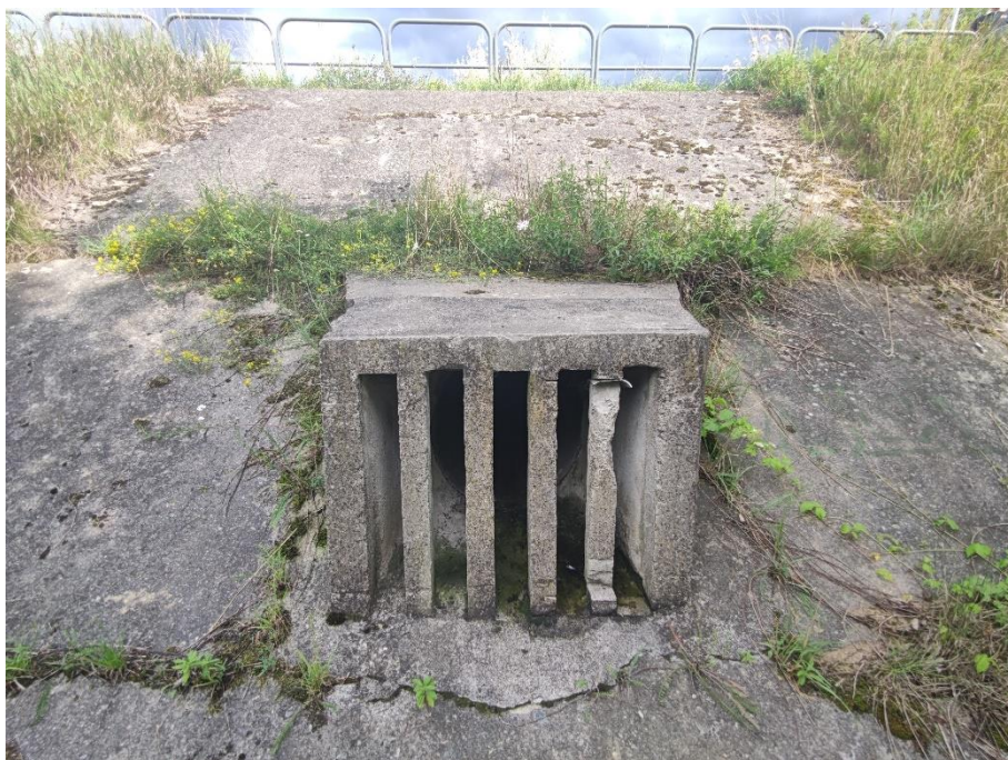
Fot.13. Wylot rurociągu w km 0+615.
