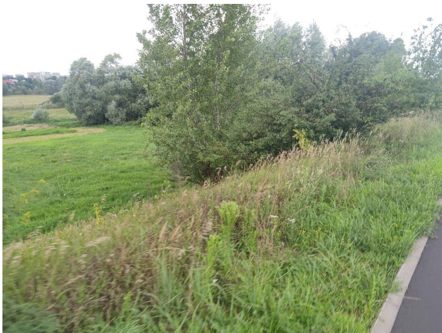
Fot.18. Widok na wał w km 0+300. Widoczne krzewy i drzewa na skarpach wału
