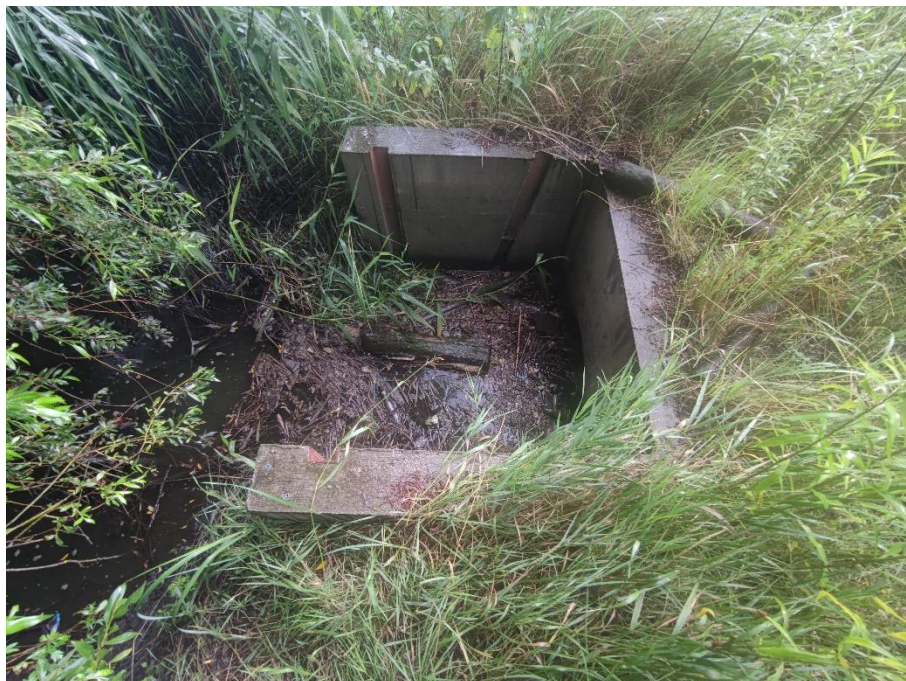
Fot.19. Wlot do przepustu wałowego w km 0+460. Widok z pomiarów sklerometrycznych komory wlotowej przepustu
