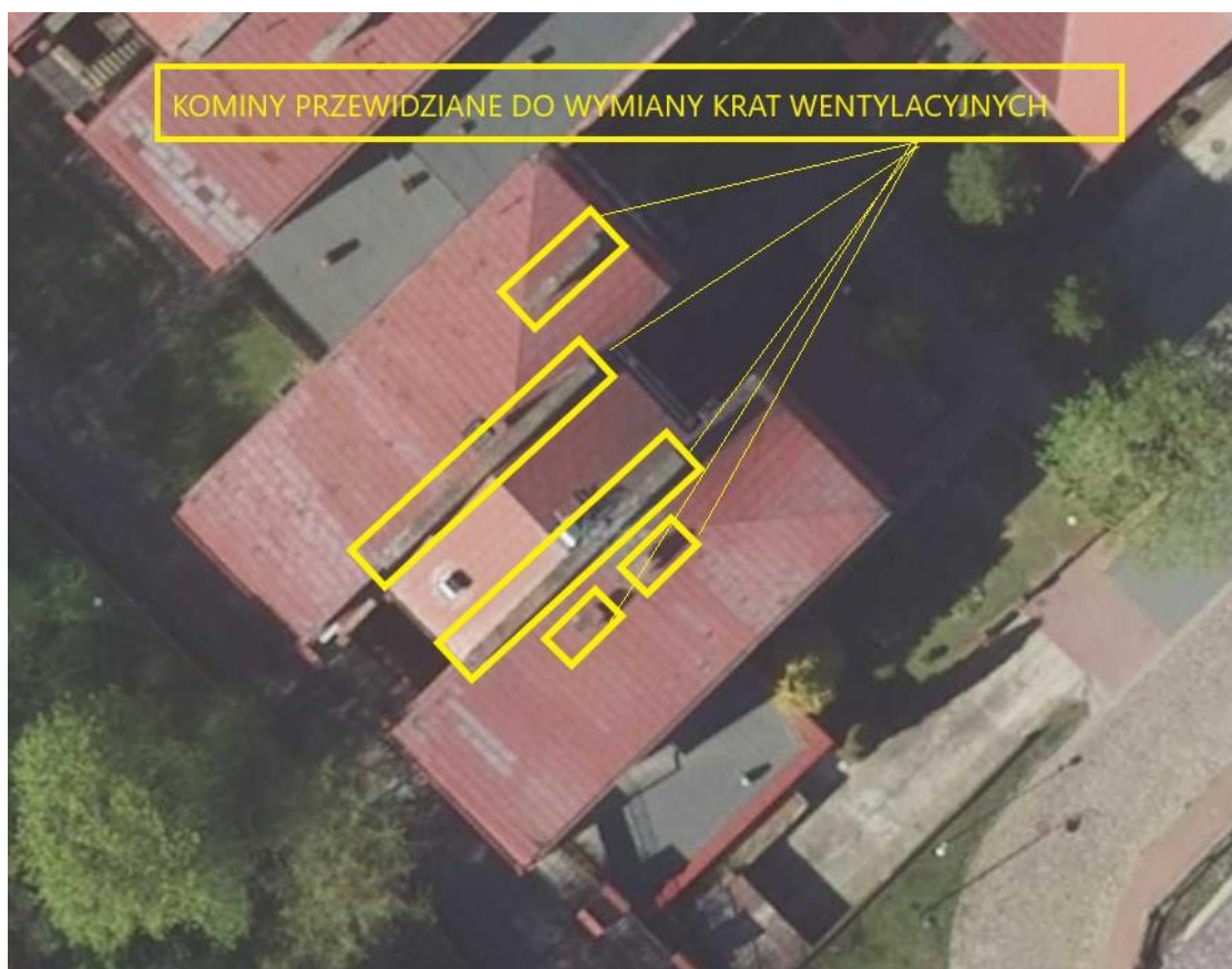
Fotografia nr 1 – Widok dachu budynku dydaktycznego B - ZSTiO Nr 4 w Łomży kominy podlegające wymianie krat wentylacyjnych.
