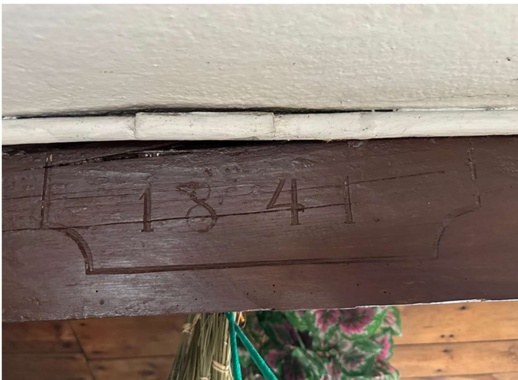
Zdj. Nr. 2 Widoczna data najprawdopodobniej budowy budynku
