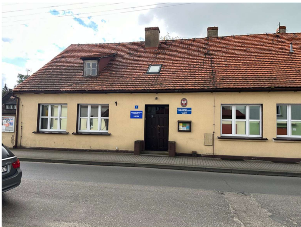
Zdj. Nr. 1 Widok na budynek ze strony ul. Dworcowej
