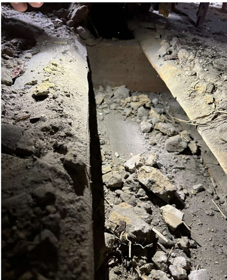
Zdj. Nr. 8 Strop nad poddaszem. Widoczne ocieplenie z polepy glinianej na górze deskowania. Widoczna w głębi jętki i podsufitka z desek.
