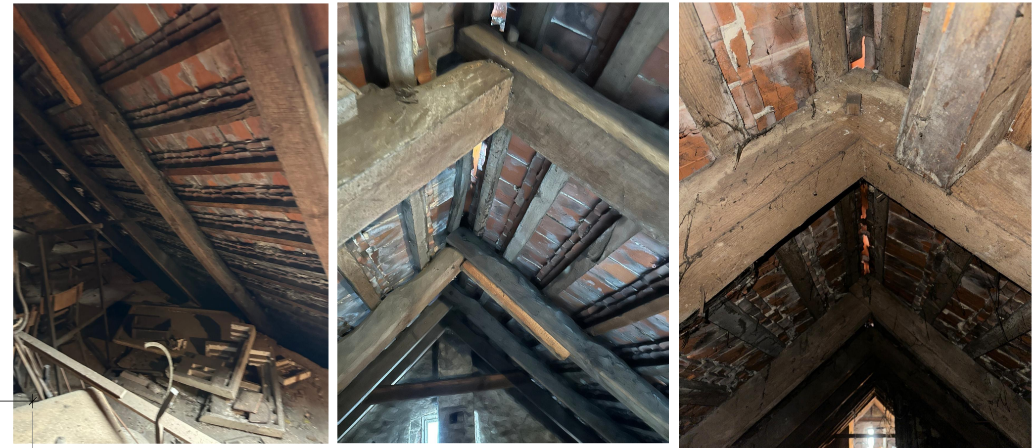
Zdjęcia konstrukcji istniejącego dachu
