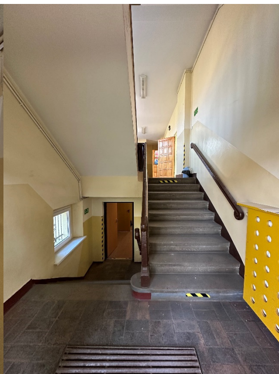
Fot. 10 Widok klatki schodowej, od wejścia do budynku
