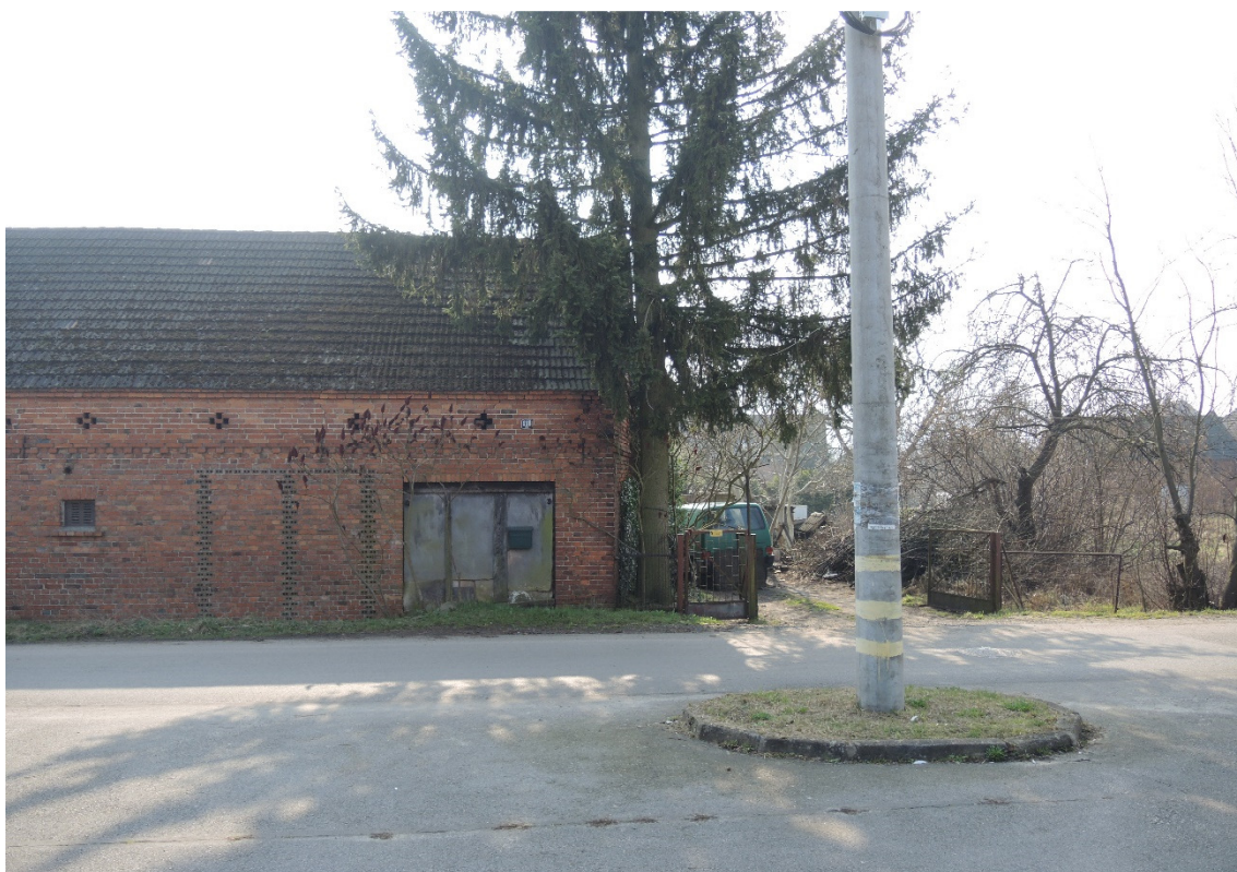
Fot. 8 Strefa zjazdu na działkę z widocznym słupem elektroenergetycznym i zabudową sąsiednią
