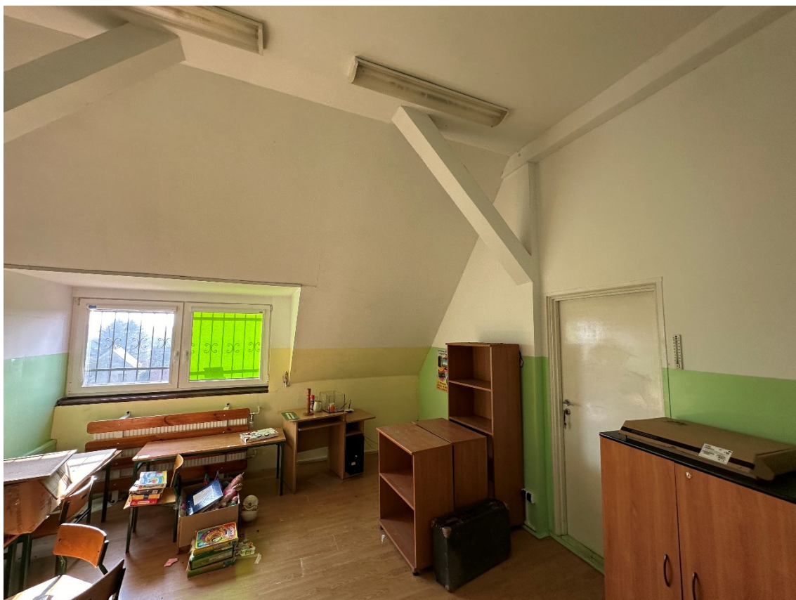
Fot. 39 Widok na lukarnę w połaci południowej, w poziomie poddasza
