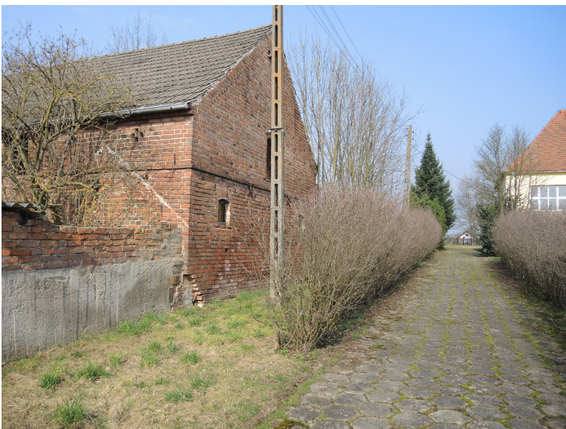
Fot. 6 Istniejący dojazd do budynku
