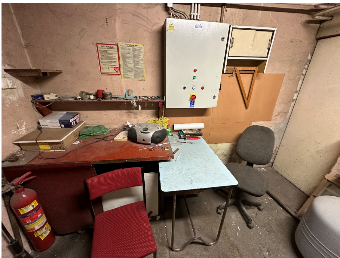
Fot. 14 Widok pomieszczenia kotła, w poziomie piwnicy
