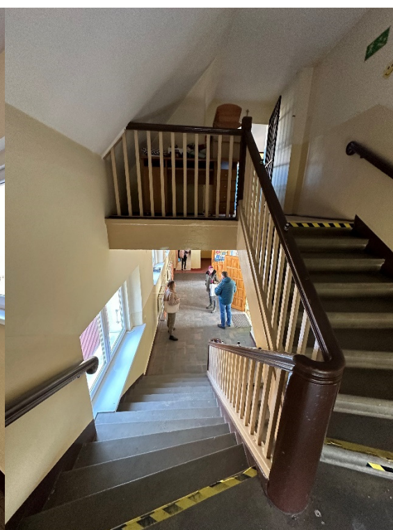
Fot. 12 Widok klatki schodowej, ze spocznika biegu prowadzącego na poddasze
