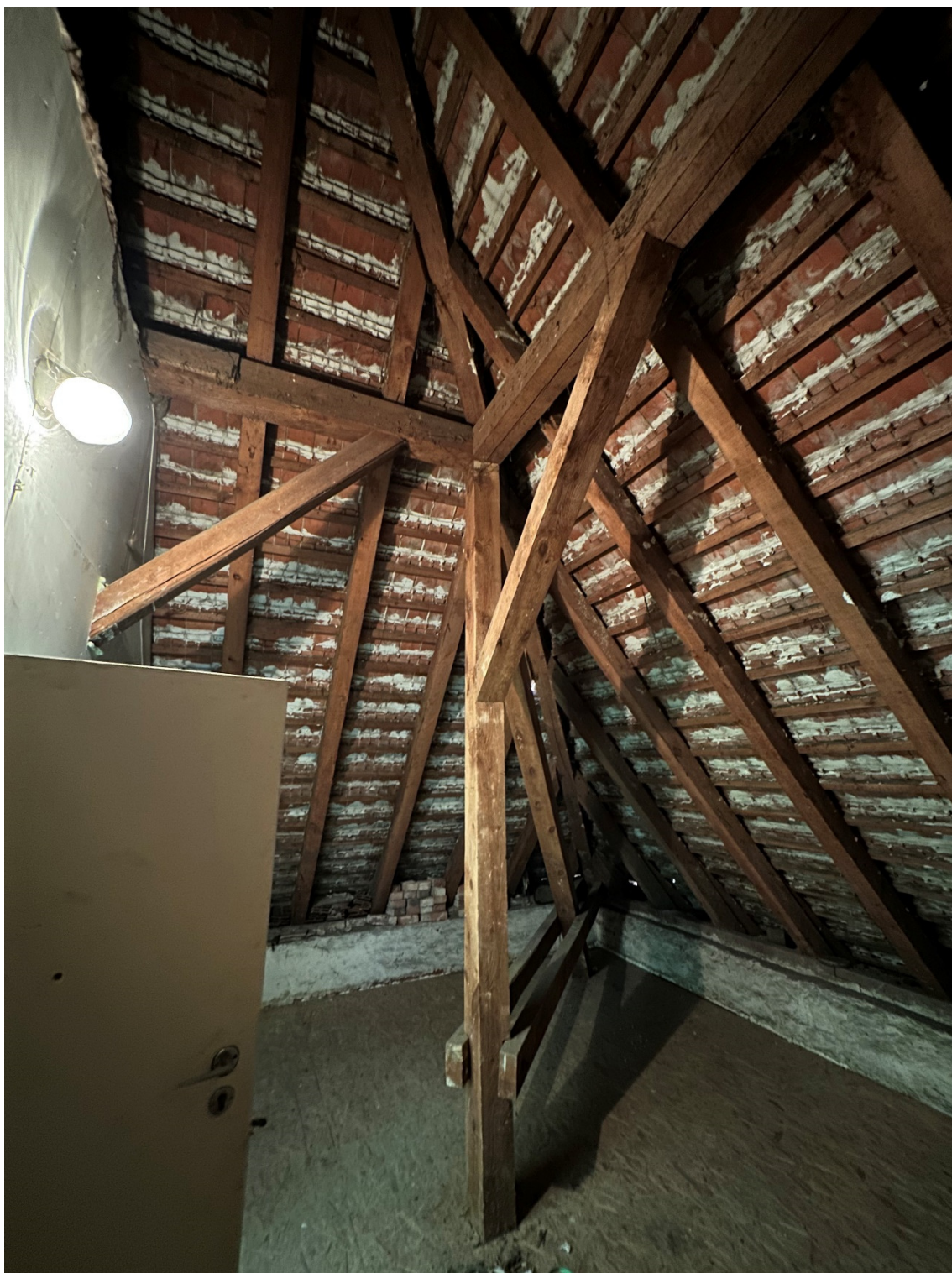
Fot. 41 Widok na konstrukcję więźby dachowej w, w południowo-zachodnim narożniku, w poziomie poddasza
