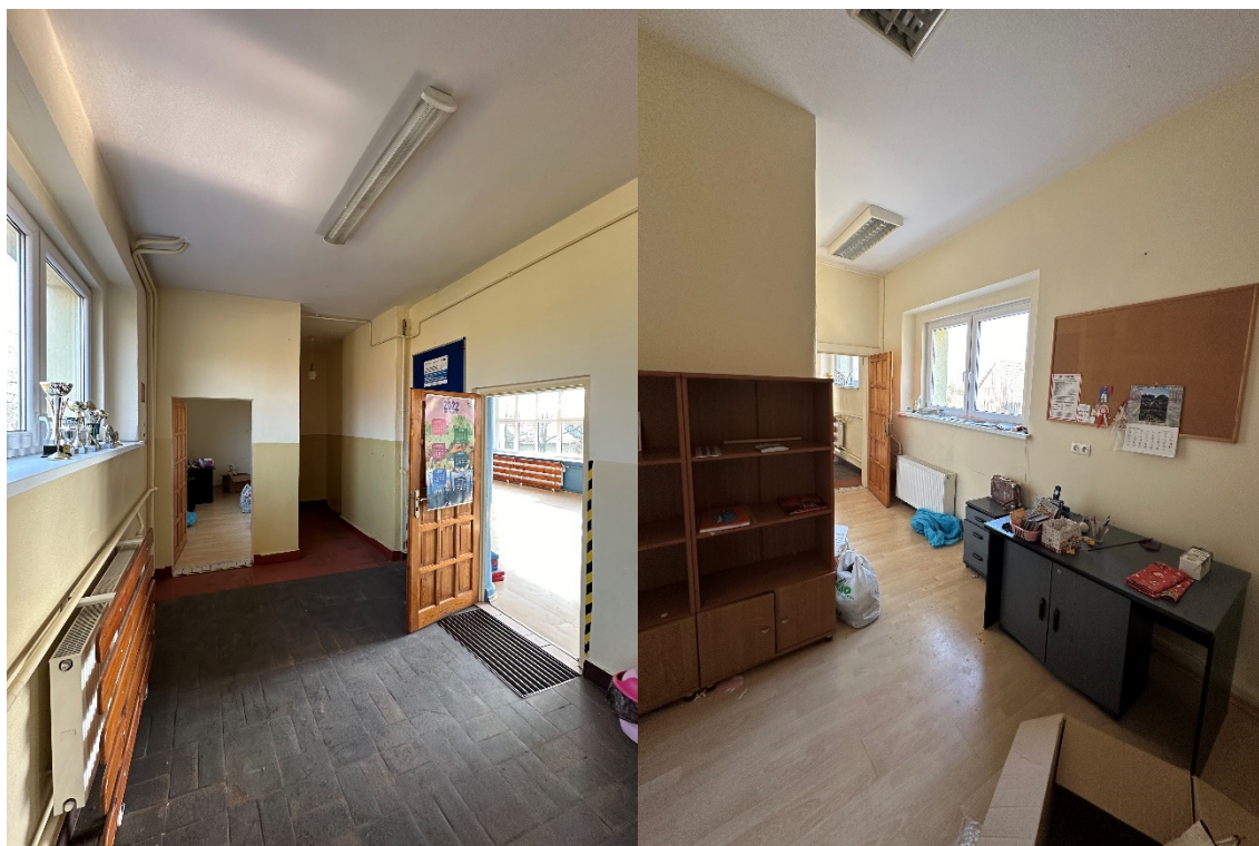
Fot. 34 Widok części wschodniej traktu północnego, w poziomie parteru
