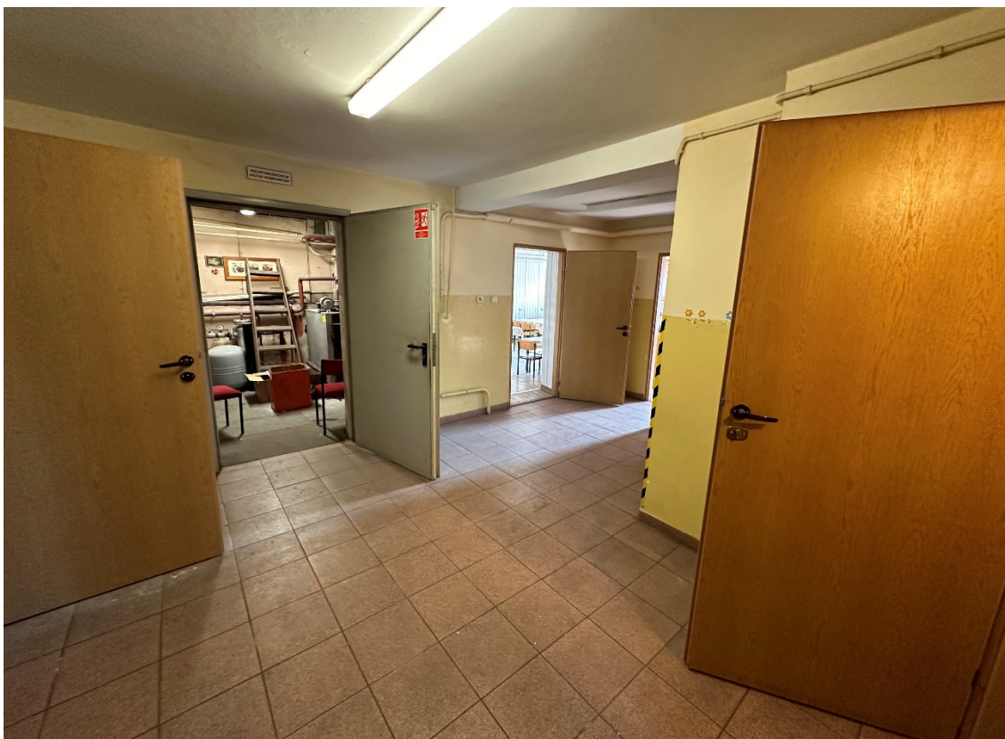
Fot. 13 Widok korytarza w poziomie piwnicy
