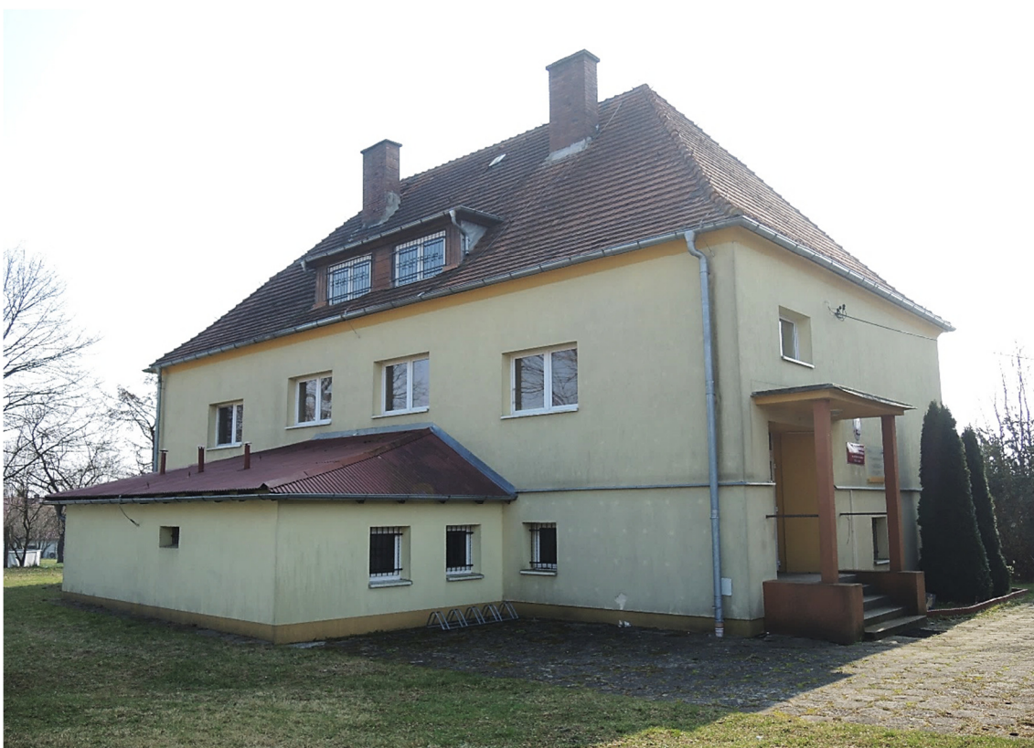
Fot. 2 Elewacja północna i zachodnia, wejście do budynku, dobudówka od strony północnej
