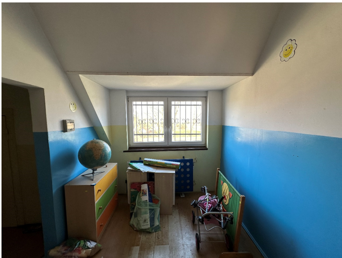
Fot. 38 Widok na lukarnę w połaci północnej, w poziomie poddasza
