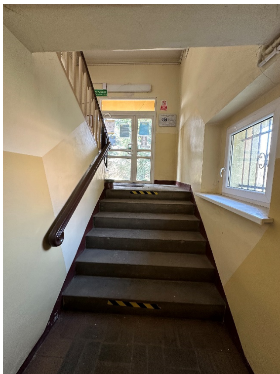
Fot. 9 Widok klatki schodowej z poziomu piwnicy
