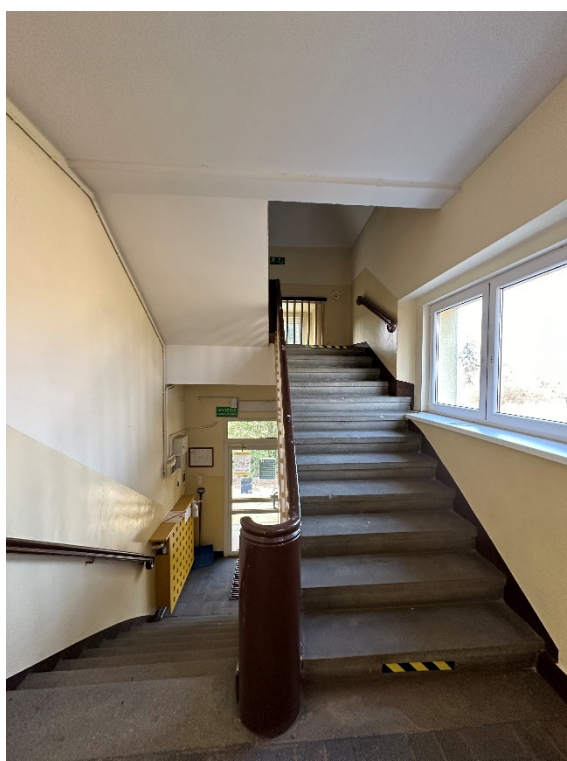
Fot. 11 Widok klatki schodowej z poziomu parteru
