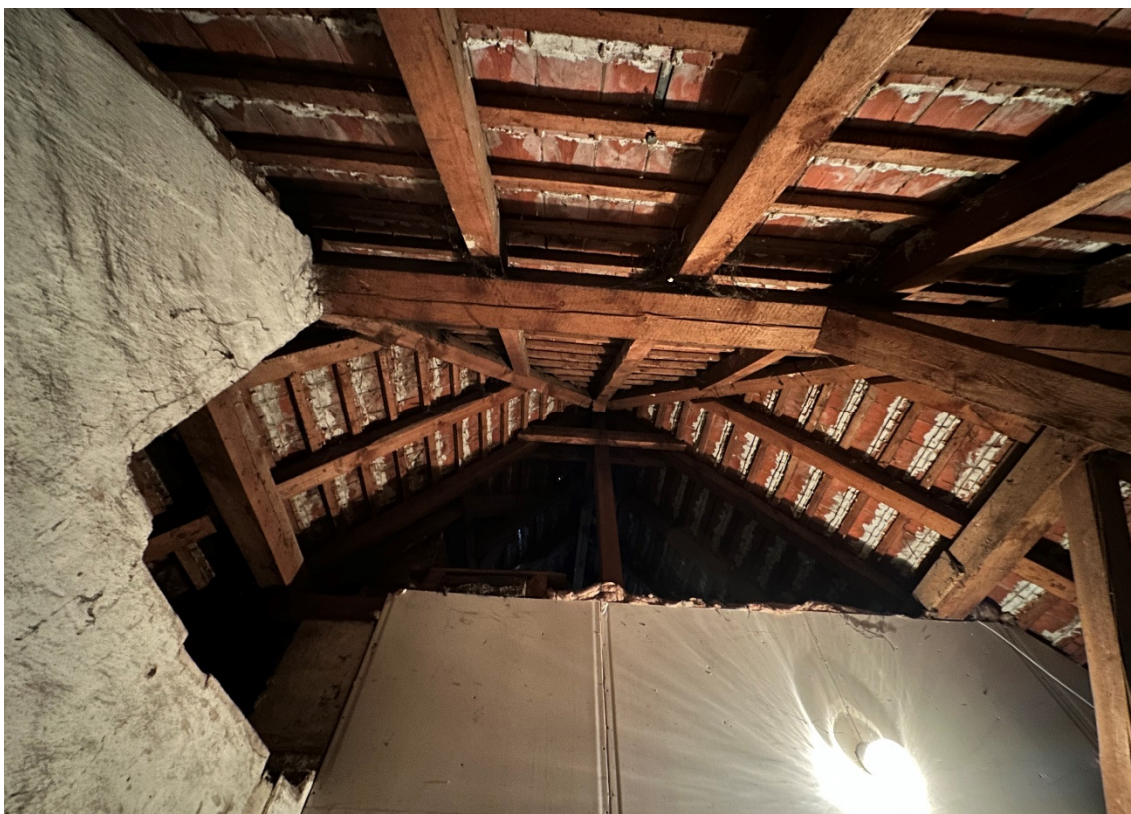
Fot. 42 Widok na konstrukcję więźby dachowej w osi '2' przy klatce schodowej
