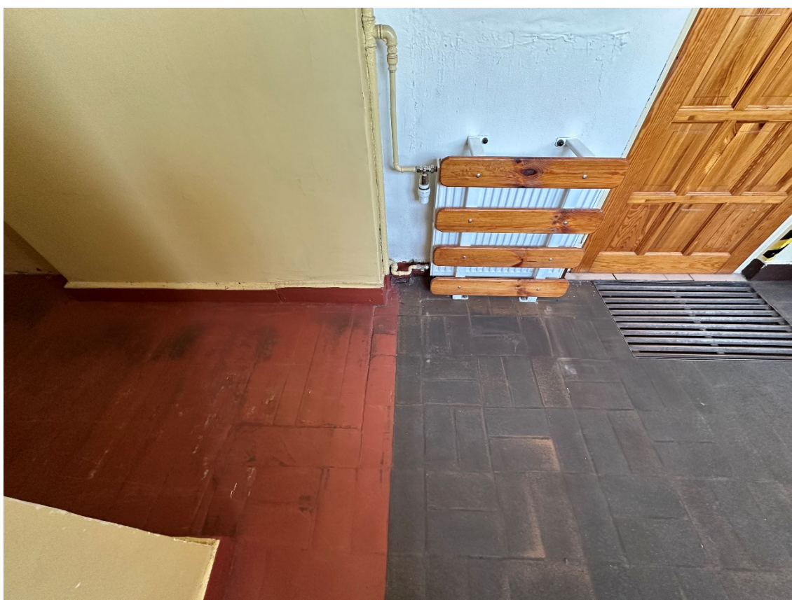
Fot. 36 Widok posadzki w trakcie północnym, w poziomie parteru
